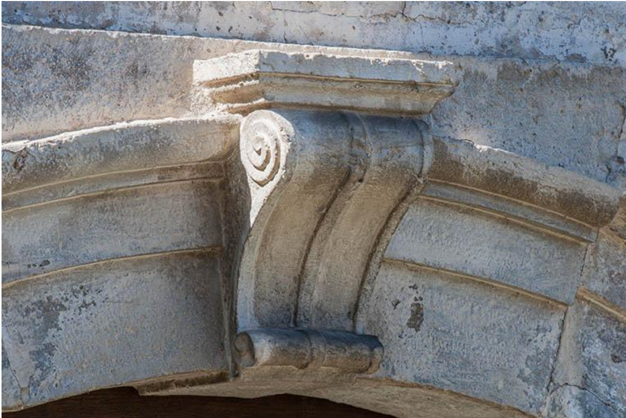
Détail de la porte 70, Gy Grande Rue
