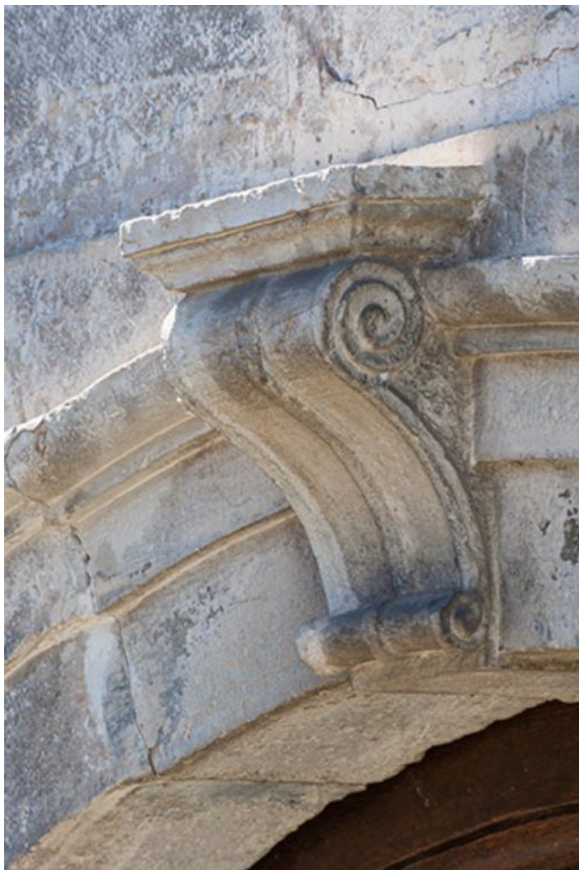
Détail de la porte 70, Gy Grande Rue
