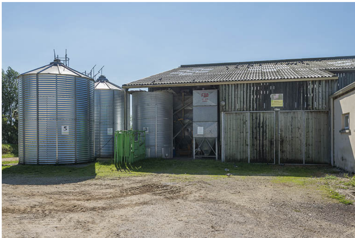
Angle nord-est du bâtiment de production laitière.
