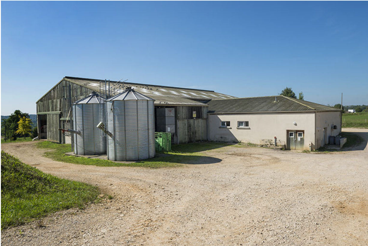
Façade est du bâtiment de production laitière.
