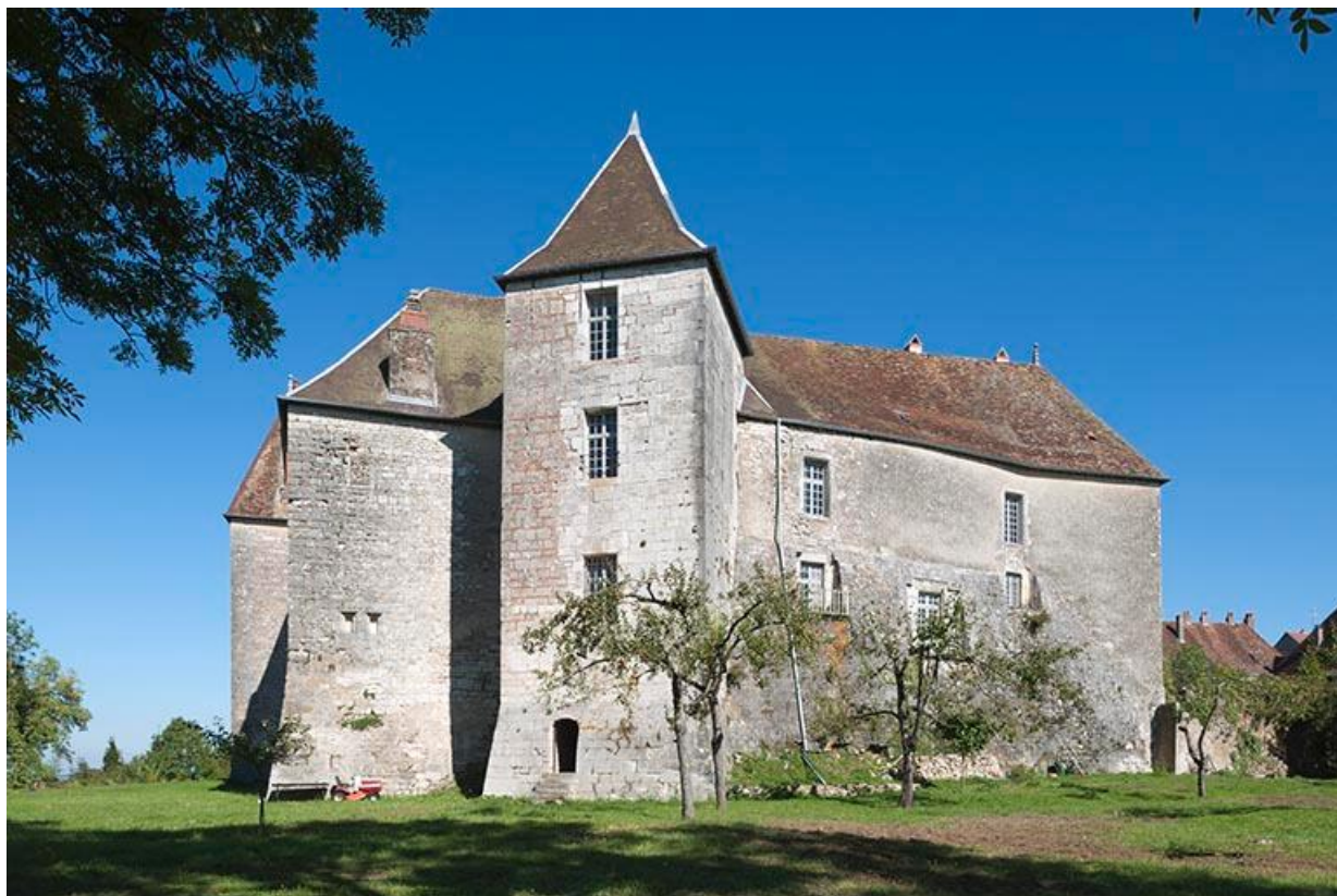
Vue générale ouest 70, Gy
