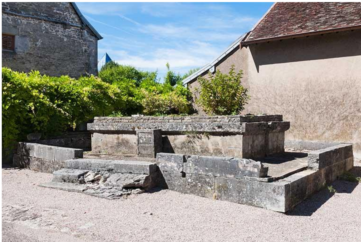
Emplacement de l'ancien lavoir de la ville haute 70, Gy
