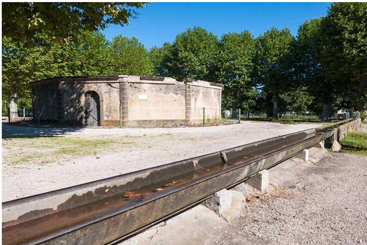
Vue générale du lavoir et de l'abreuvoir 70, Gy
