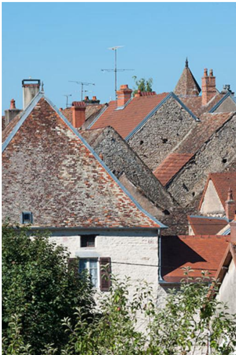
Vue des toitures des constructions de la ville haute 70, Gy
