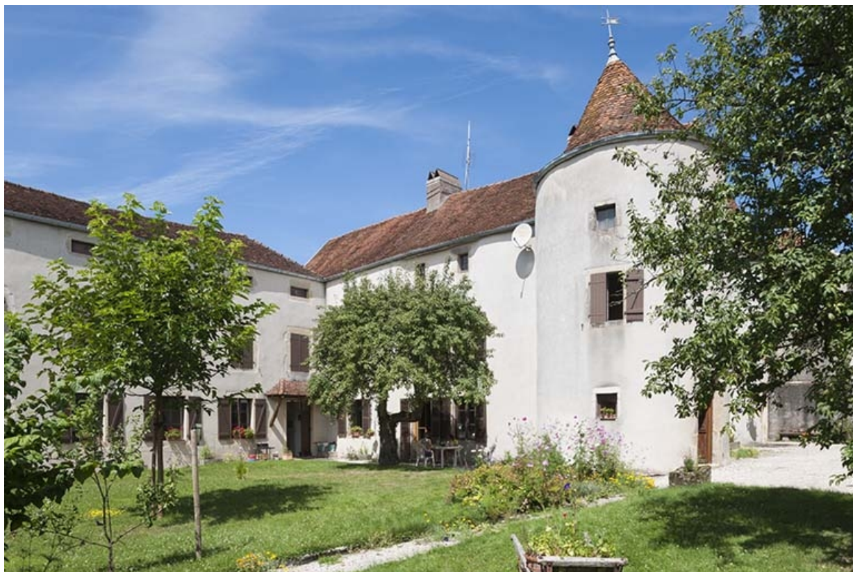
Vue d'ensemble du logis et de l'aile du bâtiment depuis le jardin.
