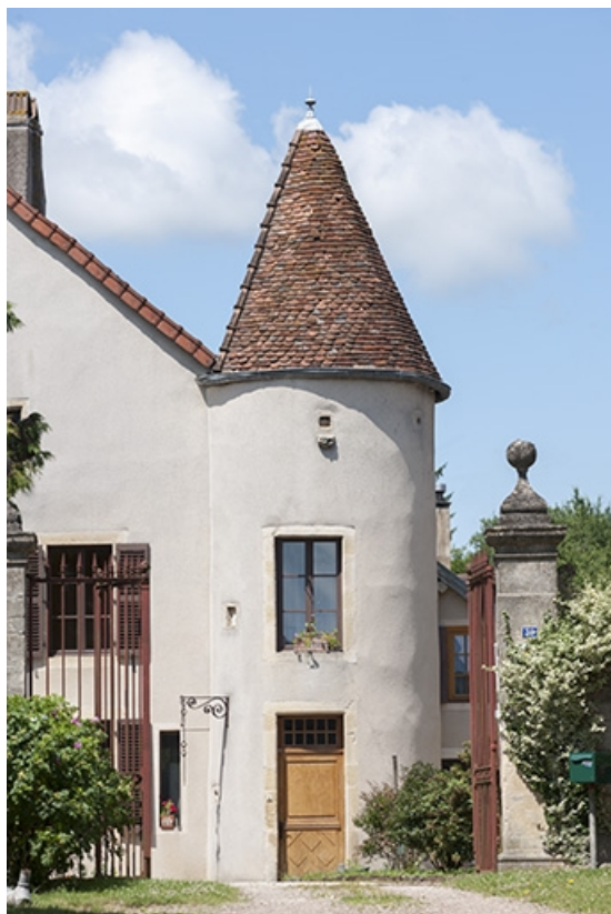
Façade antérieure et tour nord.
