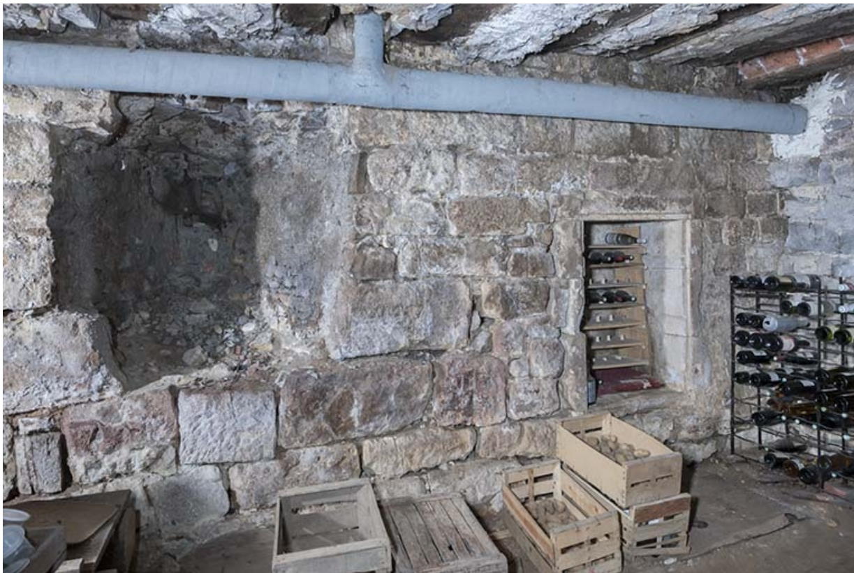
Le mur de l'enceinte médiévale visible au niveau de la cave.
