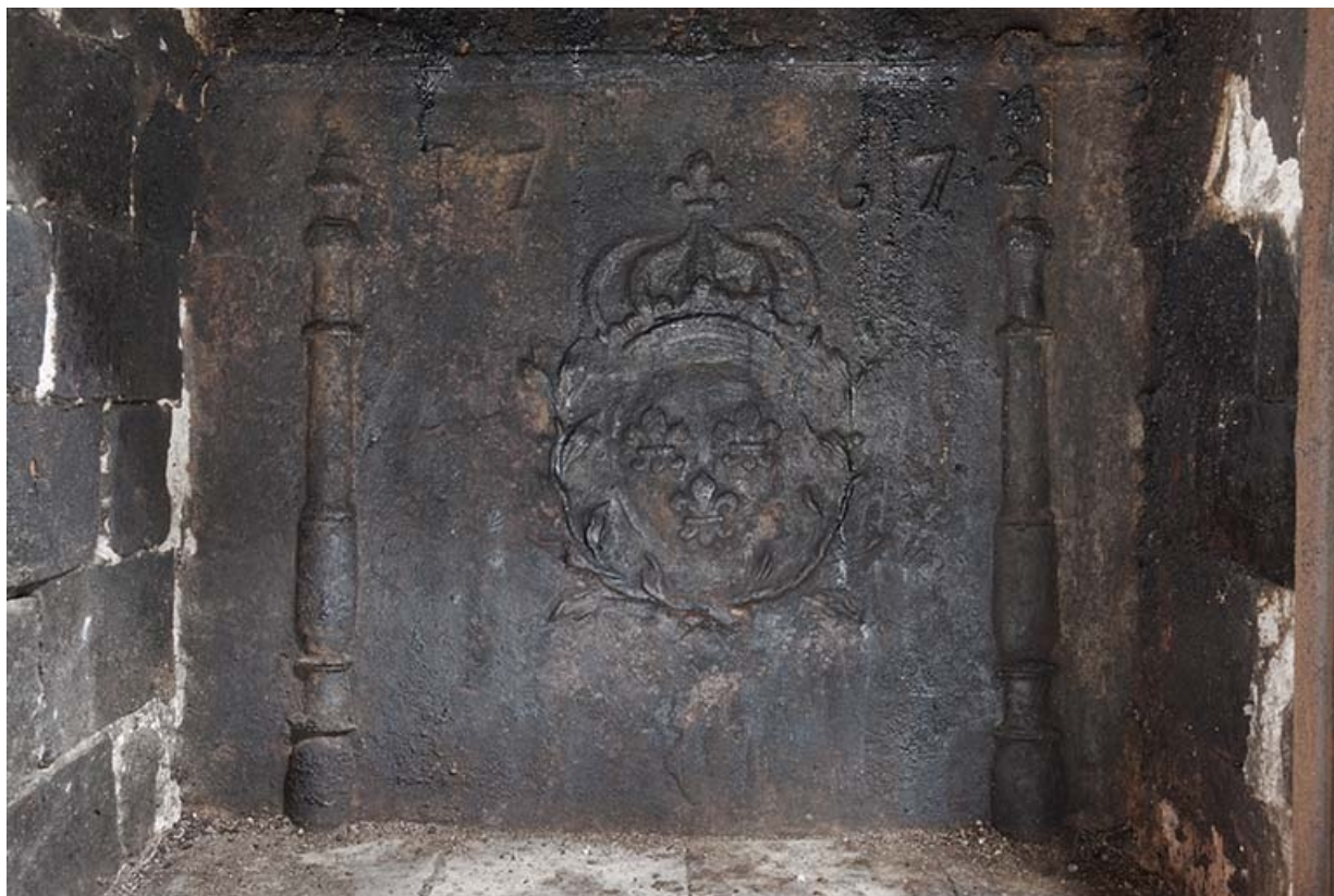
Détail : plaque de la cheminée avec date (1767) et armoiries.
