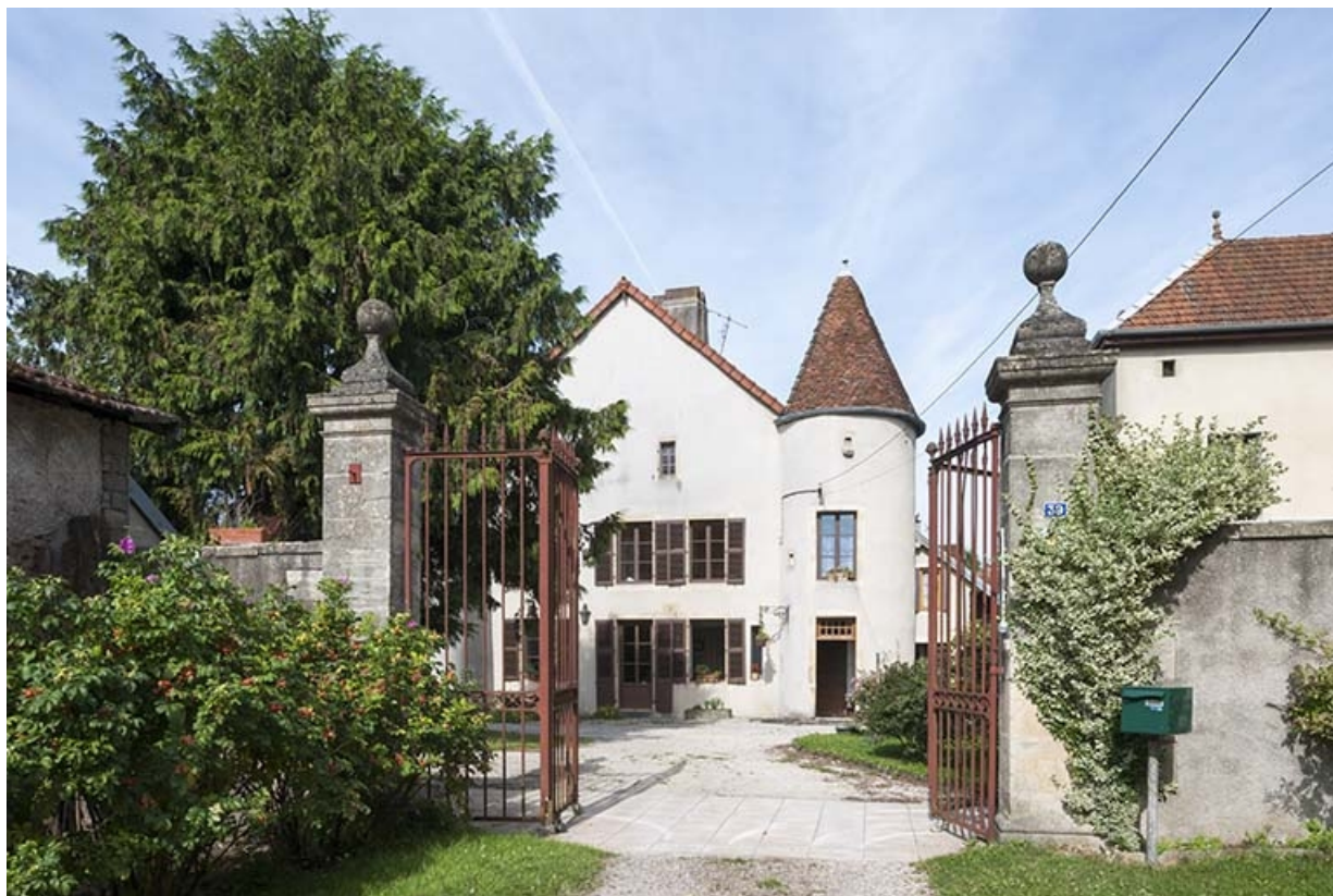
Vue rapprochée depuis la Grande Rue.
