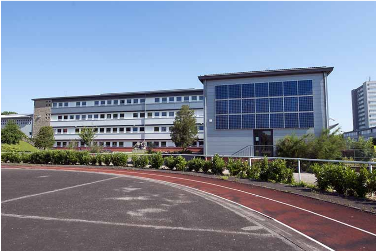
Pignon sud du bâtiment d'administration, façades sud des bâtiments d'externat et du préau.
