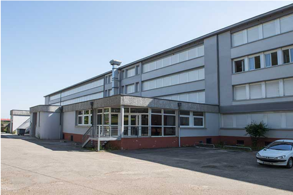
Façade ouest postérieure du bâtiment d'externat et de restauration.
