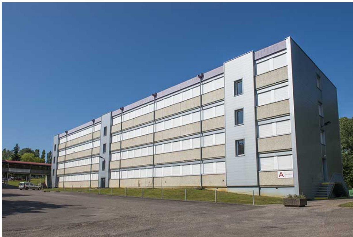
Nord-est de la façade antérieure du bâtiment d'externat et d'internat nord (A). 70, Vesoul, 18 rue Edouard Belin, lieu-dit : Grand Mont Marin
