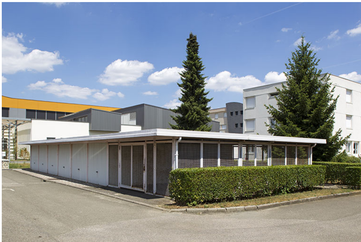
Vue d'ensemble depuis l'angle sud-ouest du local à vélo et garages.
