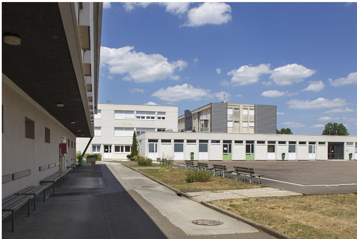
Le long de la façade est de la cantine, vue sur les façades sud de l'administration et le pignon sud de l'internat.
