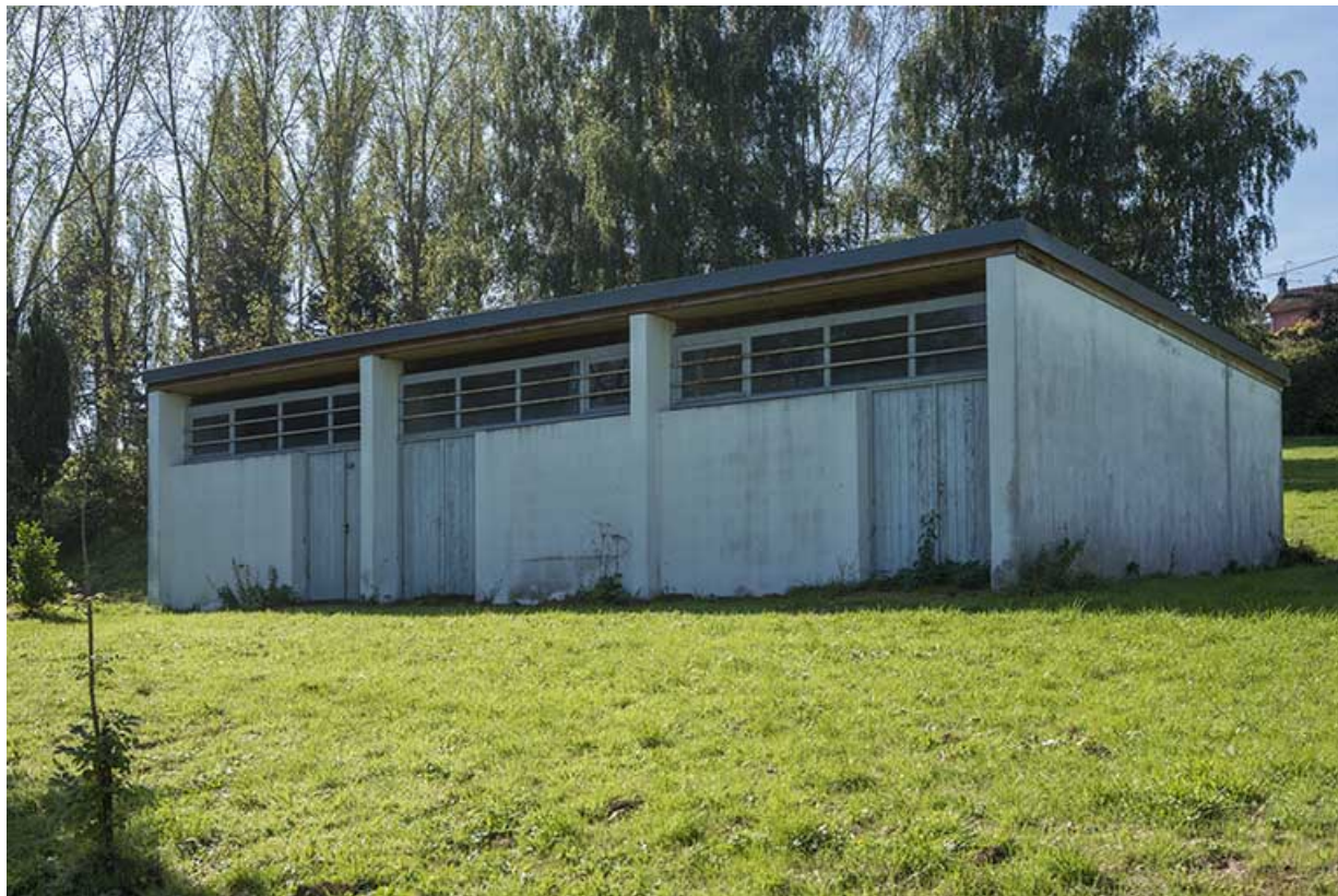
Angle nord-ouest et façade nord-est du dépôt.
