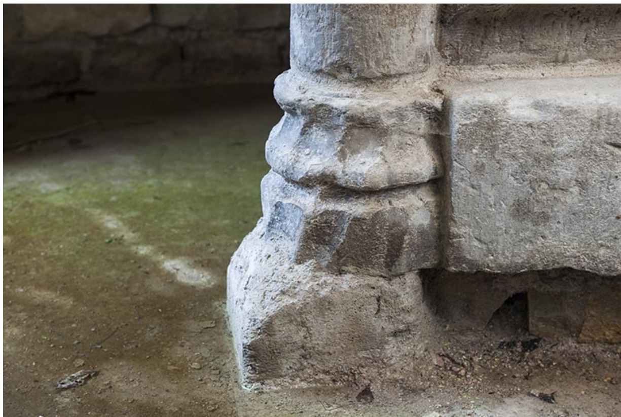
Intérieur de la tour : détail de la base du noyau.
