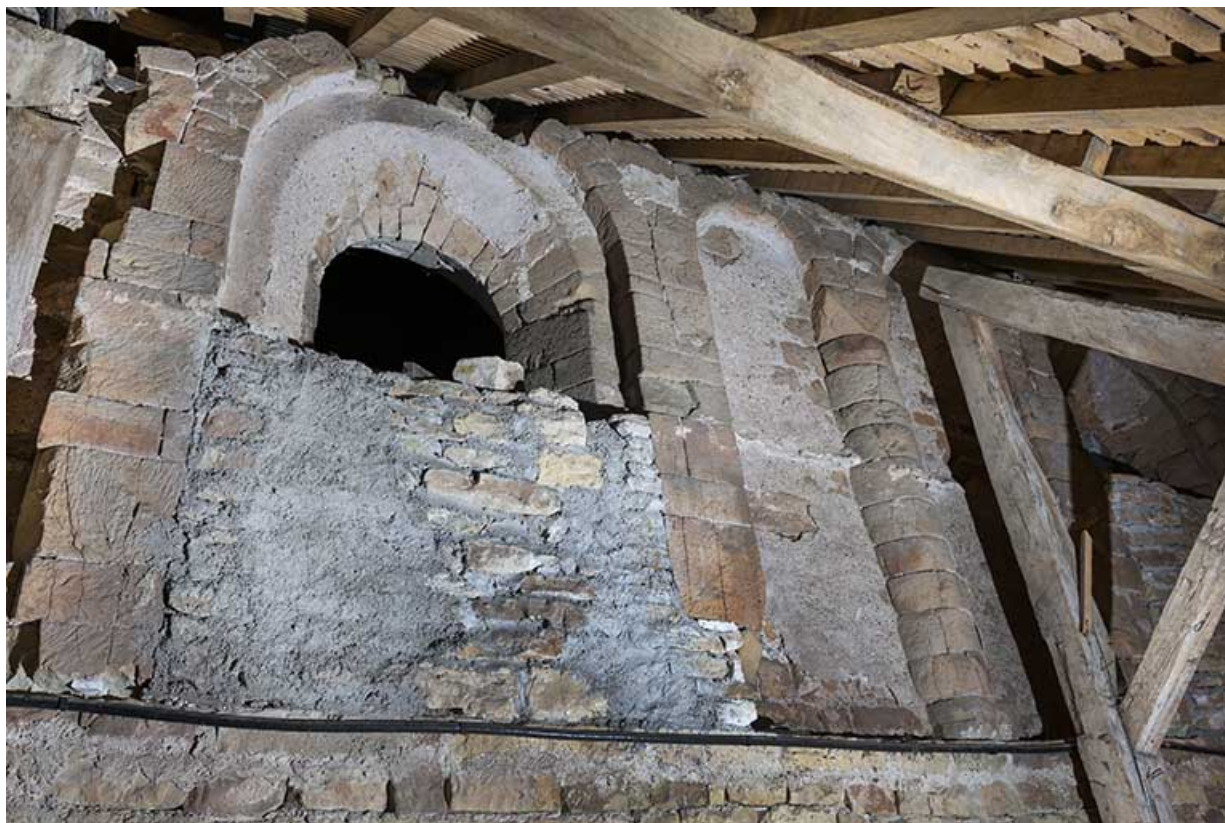
Baie en plein cintre vue depuis le comble du bas-côté sud.
