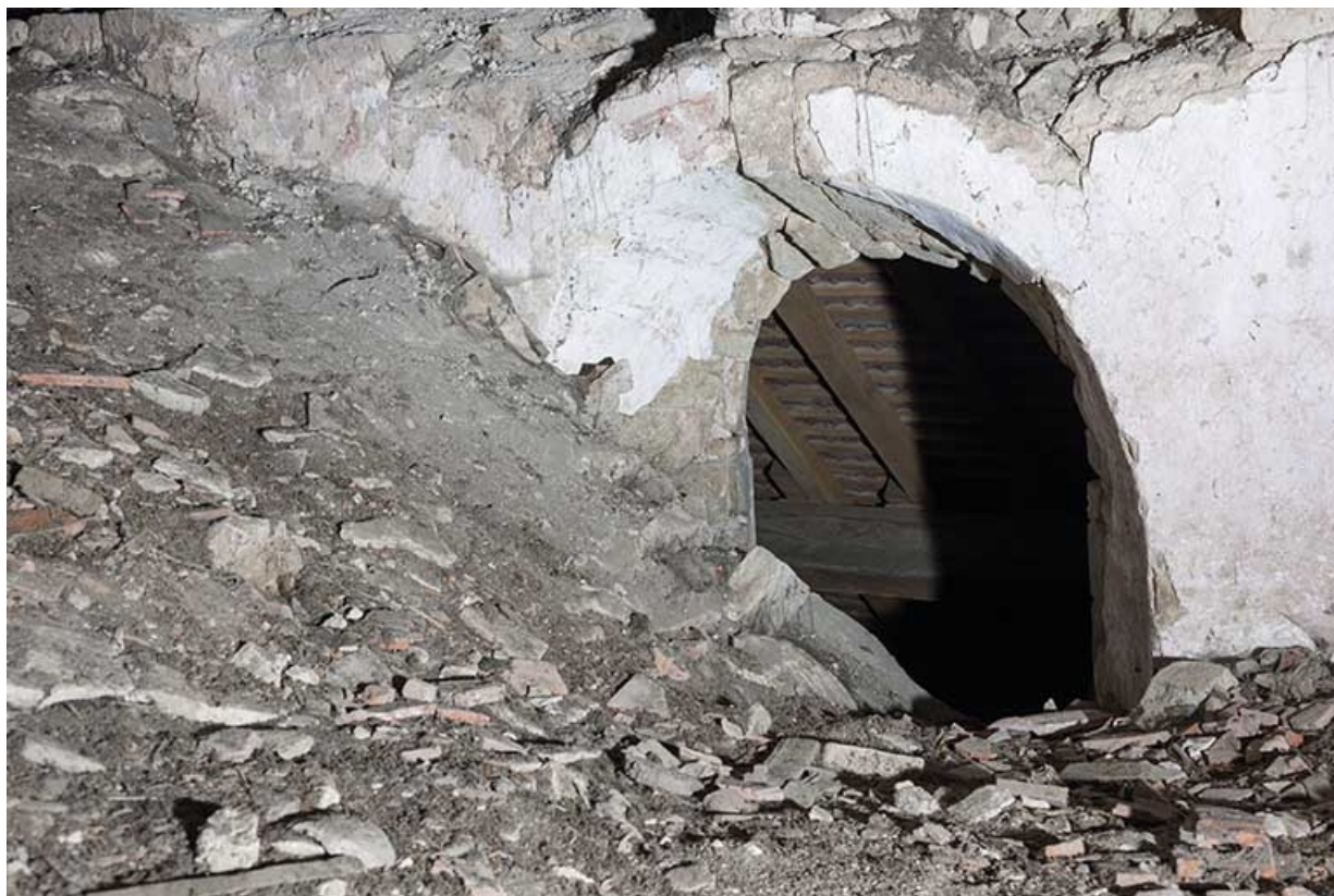
Ancienne baie au-dessus de la voûte.
