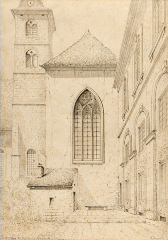
Ancien Couvent des Bénédictins de Faverney [angle de l'église et de l'aile est, depuis le cloître], [1898]. 70, Faverney place de la République
