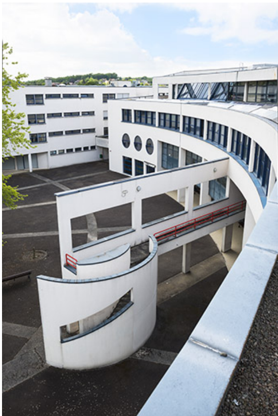
Sud-ouest de la cour postérieure, angle nord-est de l'internat et façade sud de l'externat semi-circulaire. 62, Héricourt rue Pierre Mendès France
