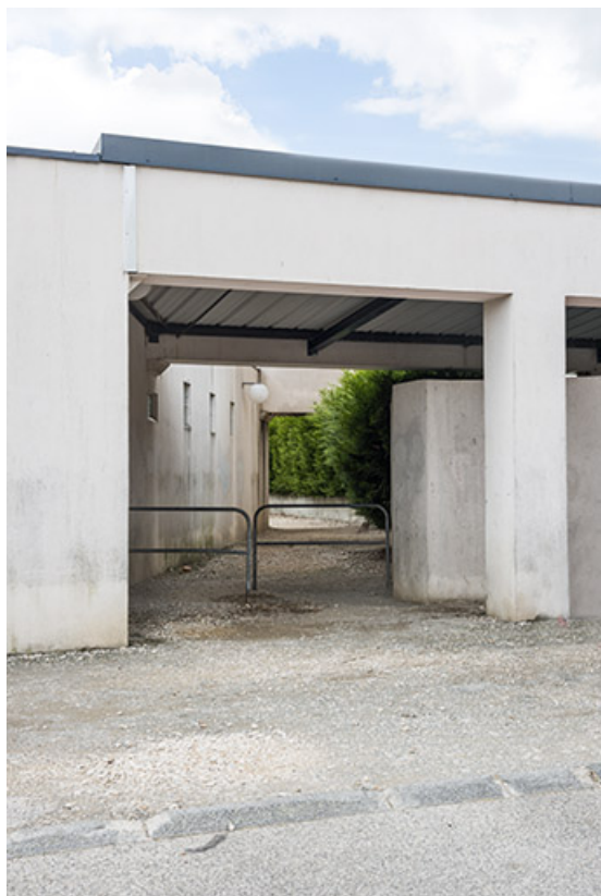
Détail du passage de la rue Mendès France vers la cour. 62, Héricourt rue Pierre Mendès France
