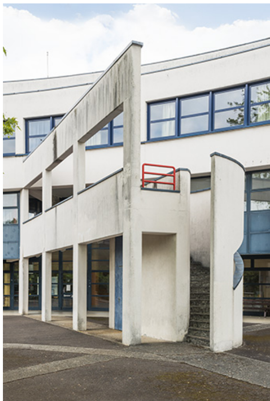
Détail de l'escalier hors-oeuvre dans la cour postérieure. 62, Héricourt rue Pierre Mendès France
