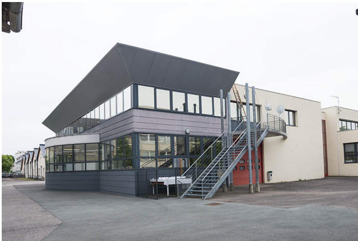
Façade intérieure ouest de l'atelier froid et climatisation domotique.
