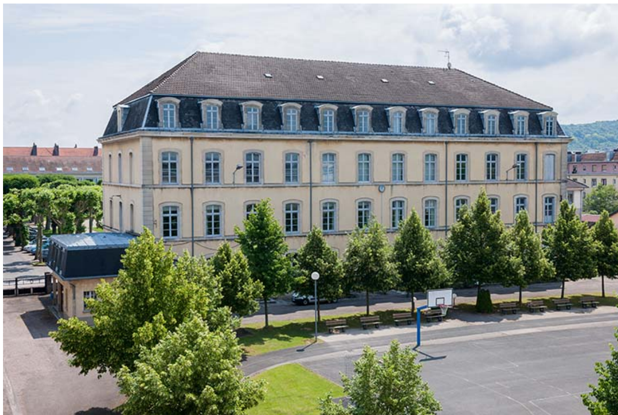
Façade ouest sur cour de l'administration-internat.
