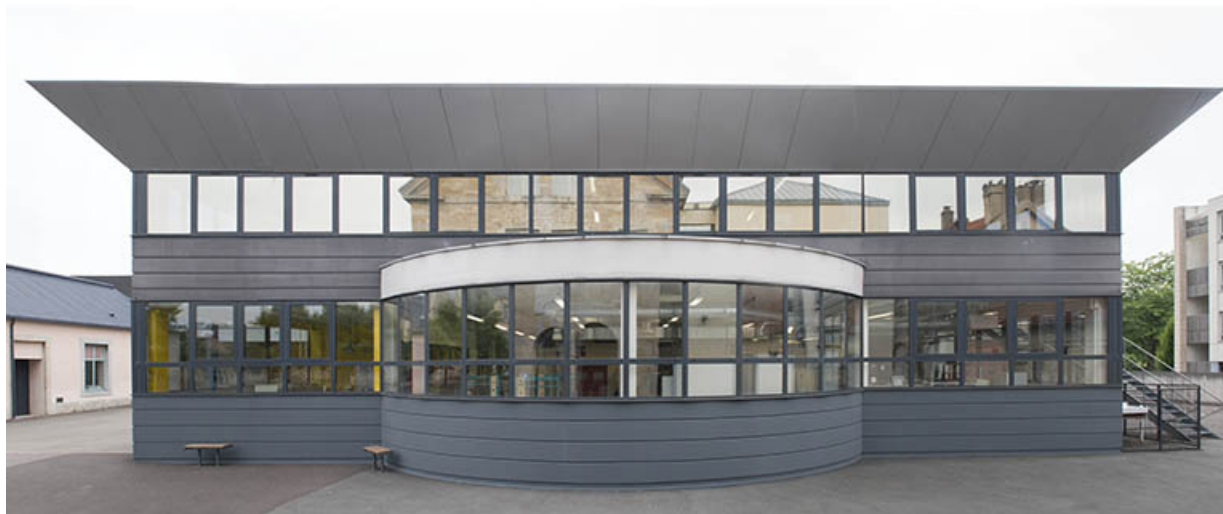
Façade sur cour de l'atelier froid et climatisation domotique.
