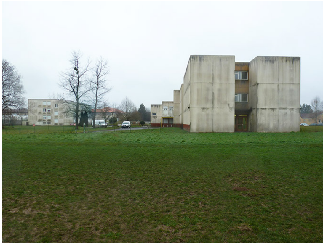
Façade nord de l'internat.
