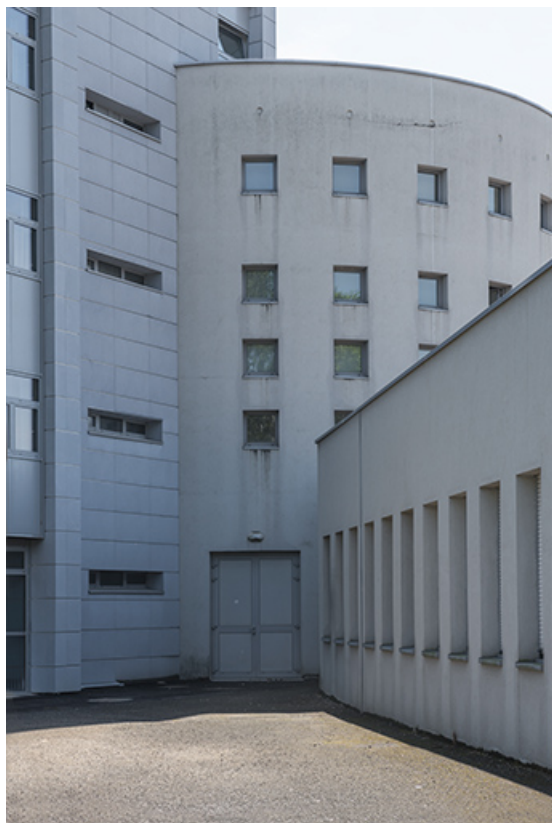
Détail de l'articulation entre l'ouest de la rotonde centrale, l'internat-externat et l'administration. 70, Lure, 1 rue Georges Colomb
