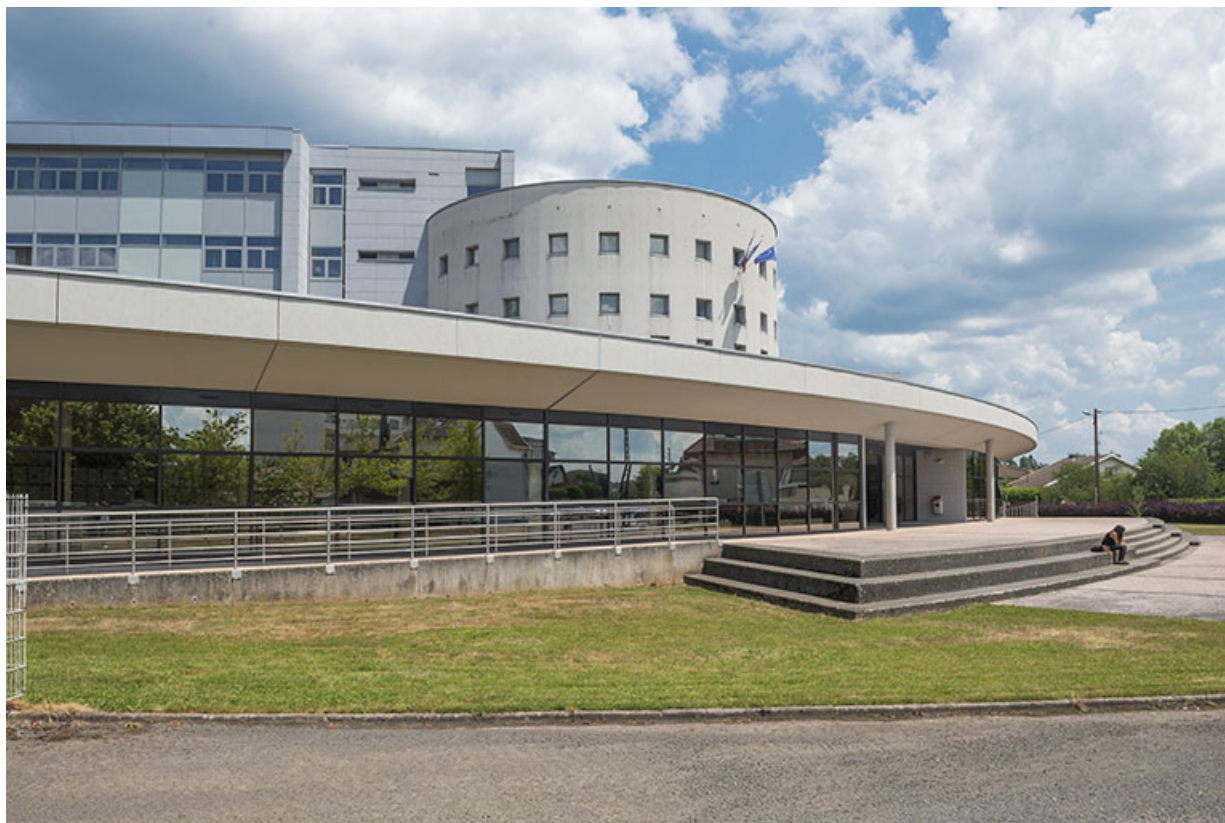
Vues de l'ouest : la place-parvis et la façade d'entrée.
