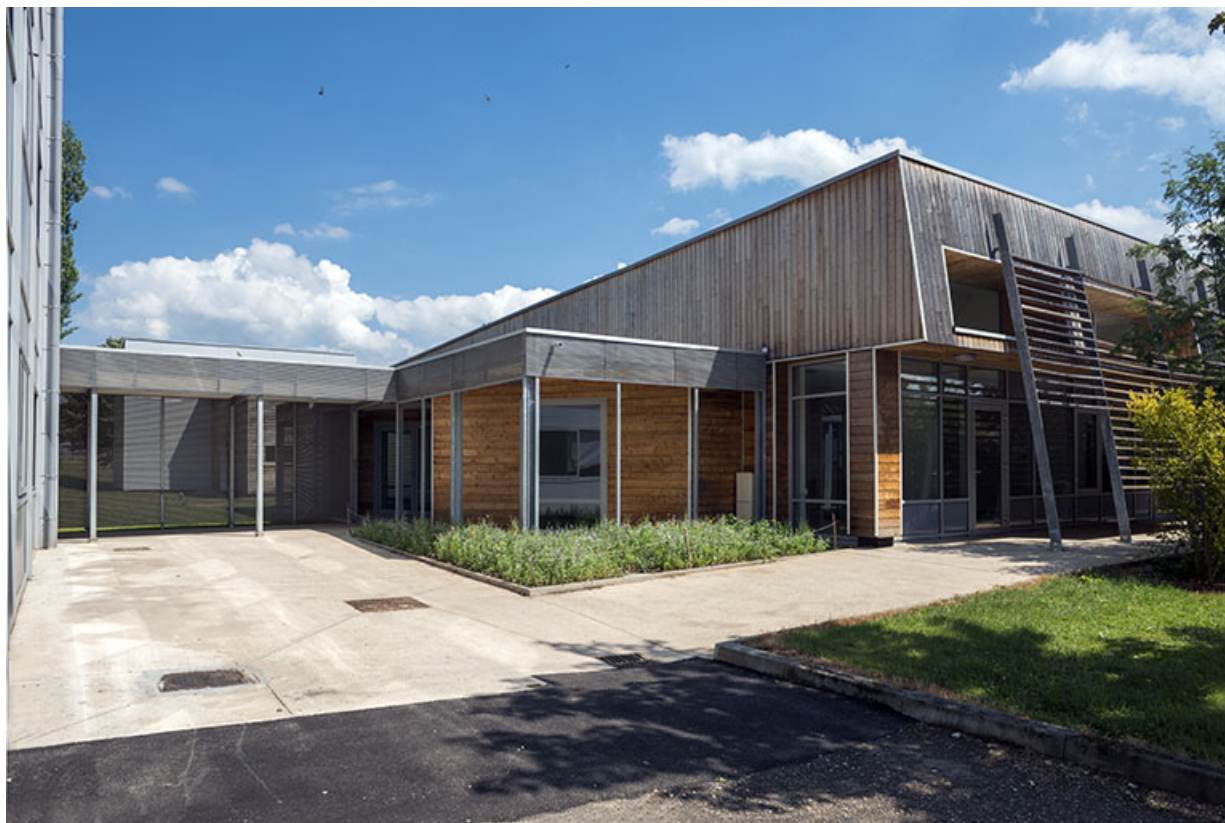
Liaison entre l'ouest de la cantine et l'externat.
