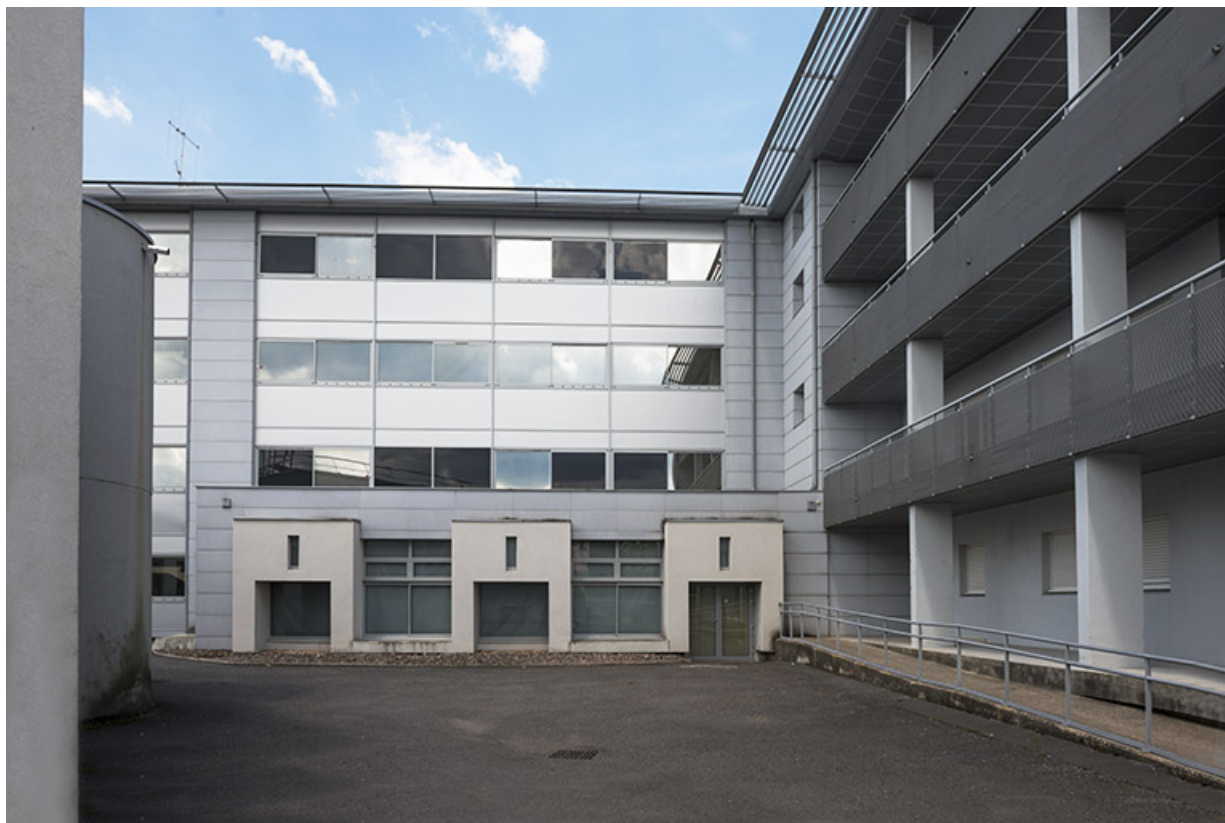
Façade postérieure ouest des logements et façade postérieure sud de l'internat-externat. 70, Lure, 1 rue Georges Colomb
