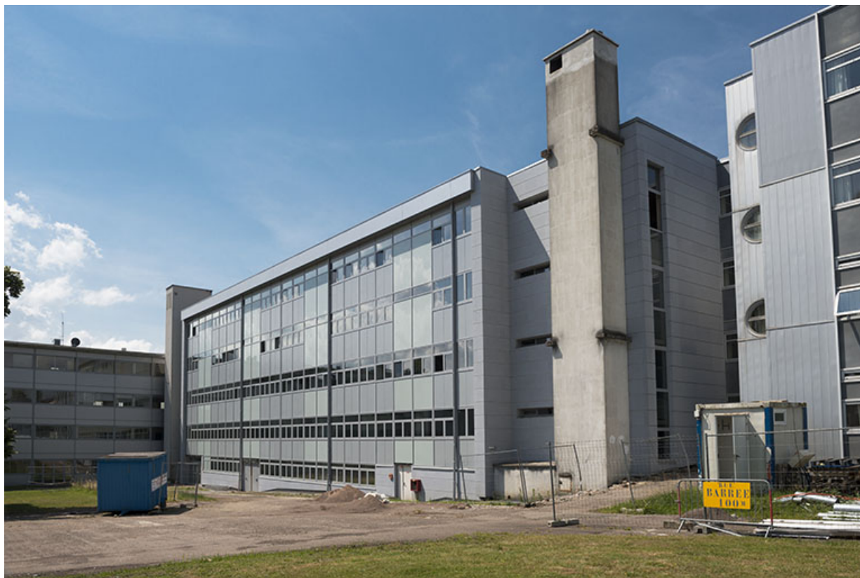
Façades orientales des externats et façade septentrionale de l'internat-externat. 70, Lure, 1 rue Georges Colomb
