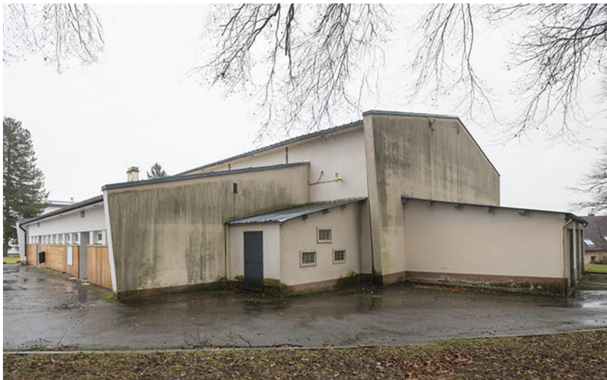
Angle nord-ouest du gymnase.
