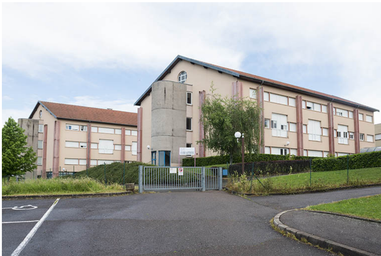
Les pignons sud-ouest de l'externat avec leurs cages d'escaliers en béton.
