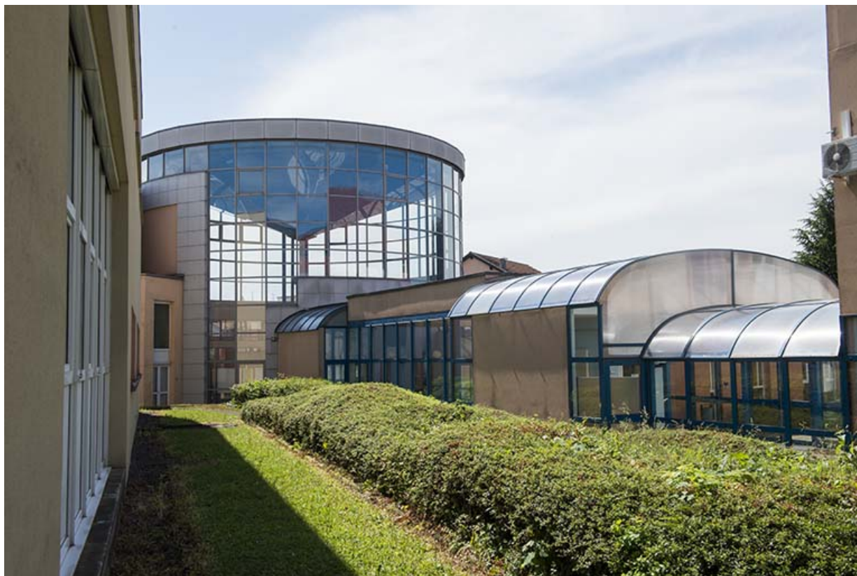
Façade postérieure de la tour d'entrée et couloirs abrités.
