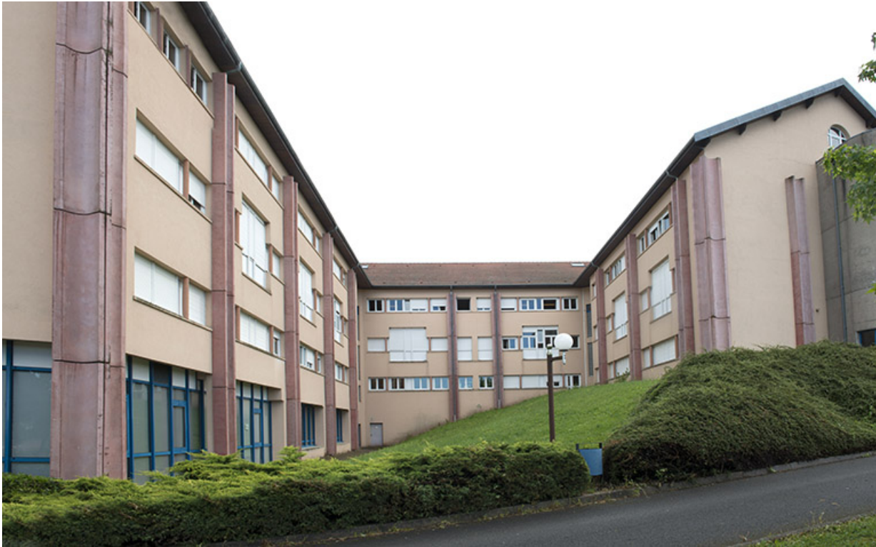
Détail de la façade sud-ouest de l'externat.
