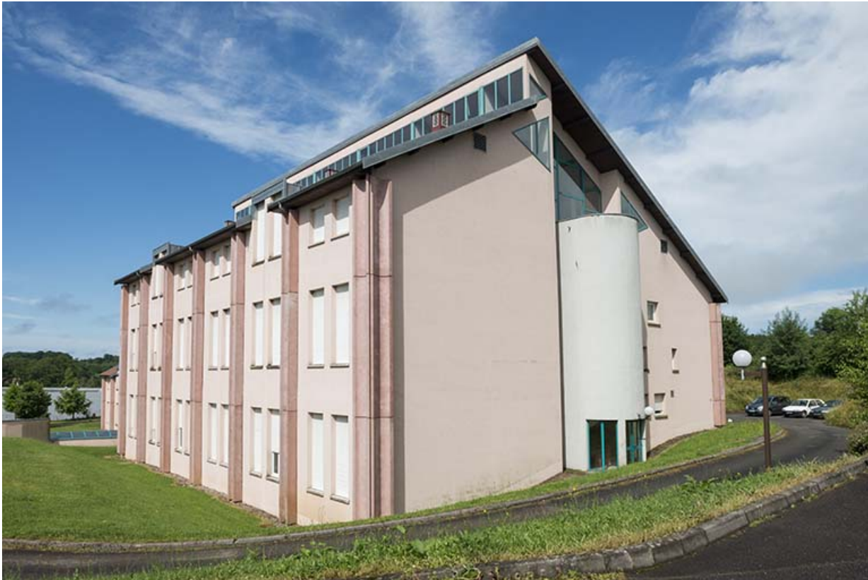
Angle est de l'internat de filles et des logements de fonction et infirmerie. 70, Luxeuil-les-Bains, 33 ter rue Grammont
