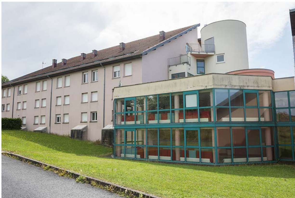
Façades postérieures nord de l'internat nord-est.
