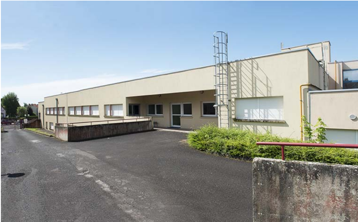
Façade postérieure est des bâtiments d'enseignement technologique hôtelier. 70, Luxeuil-les-Bains, 33 ter rue Grammont
