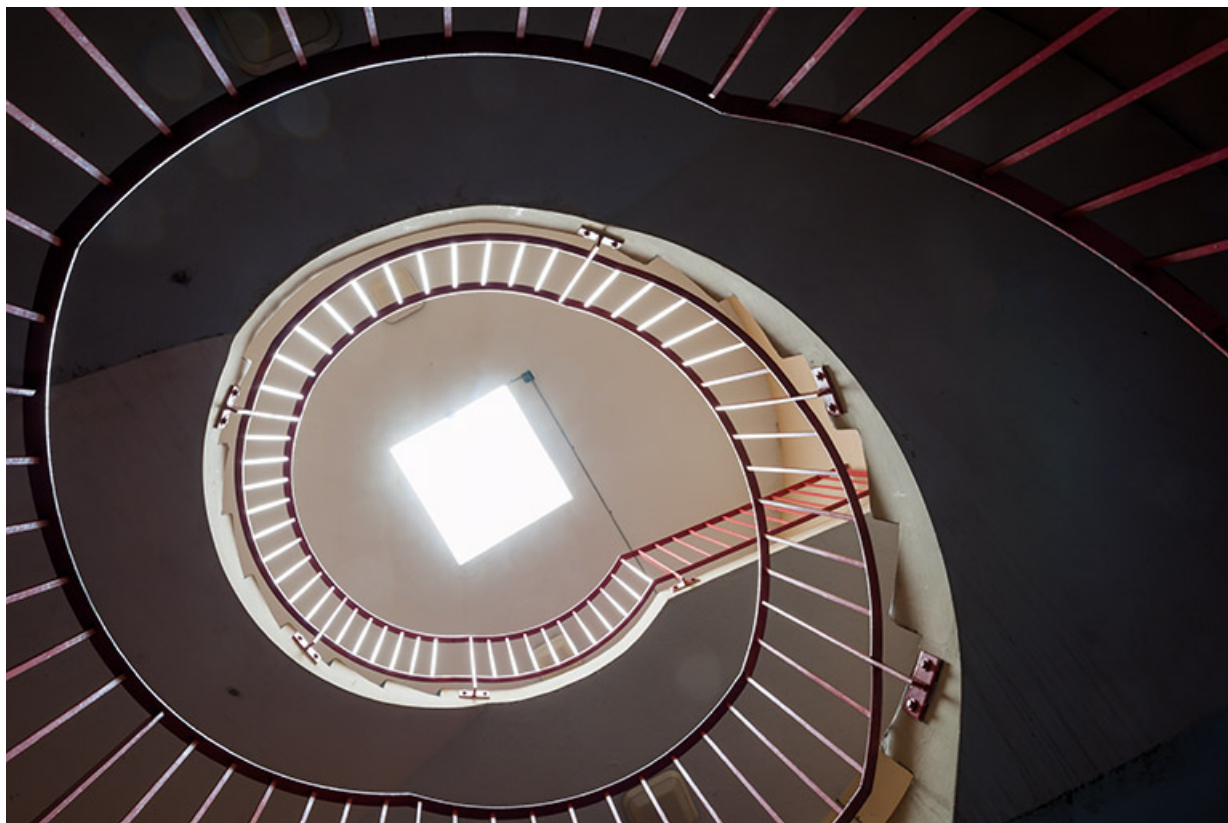
Escalier en vis en béton de l'internat.
