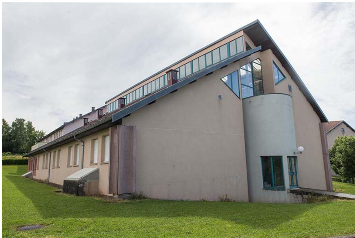
Pignon ouest de l'internat sud-ouest.
