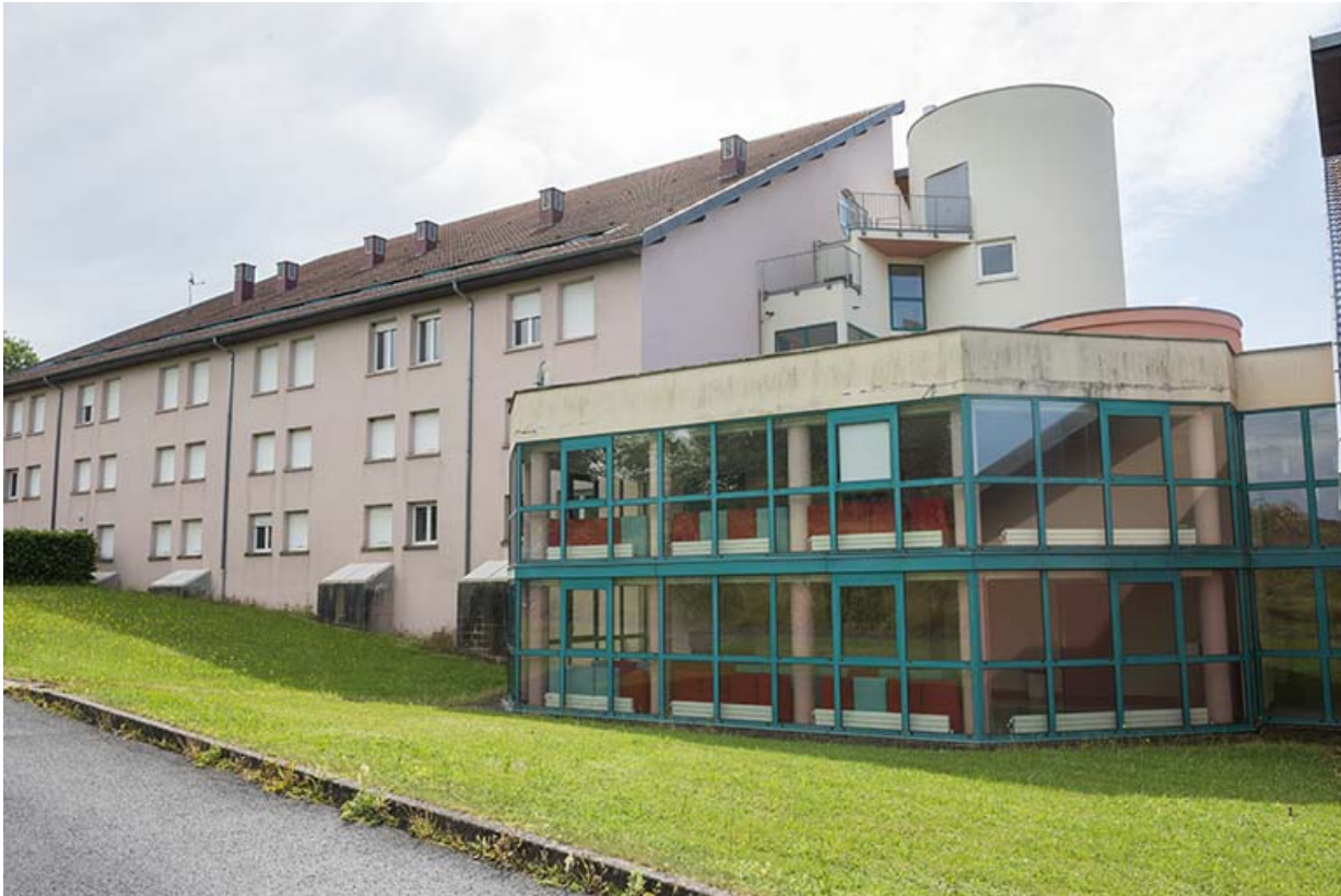
Façades postérieures nord de l'internat nord-est.
