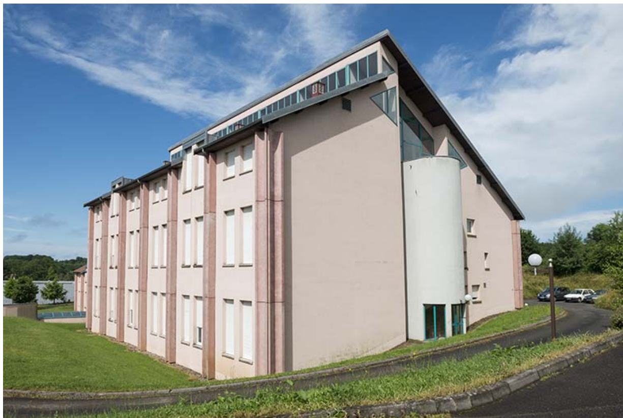
Angle est de l'internat de filles et des logements de fonction et infirmerie.
