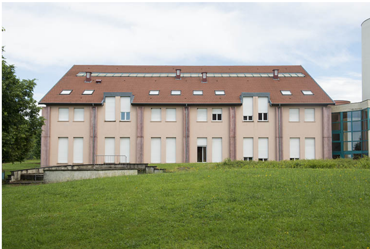
Façade antérieure sud de l'internat sud-ouest.
