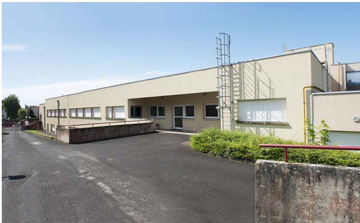
Façade postérieure est des bâtiments d'enseignement technologique hôtelier. 70, Luxeuil-les-Bains, 33 ter rue Grammont
