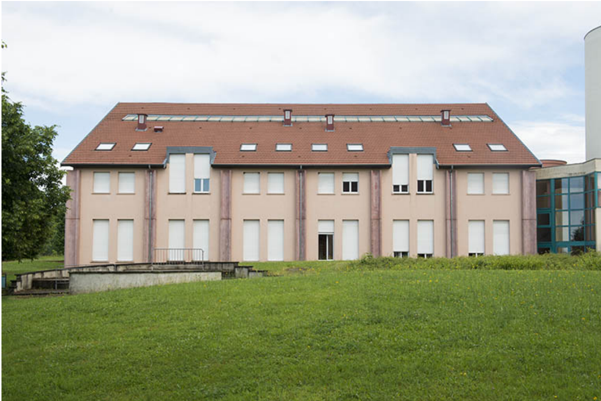
Façade antérieure sud de l'internat sud-ouest.
