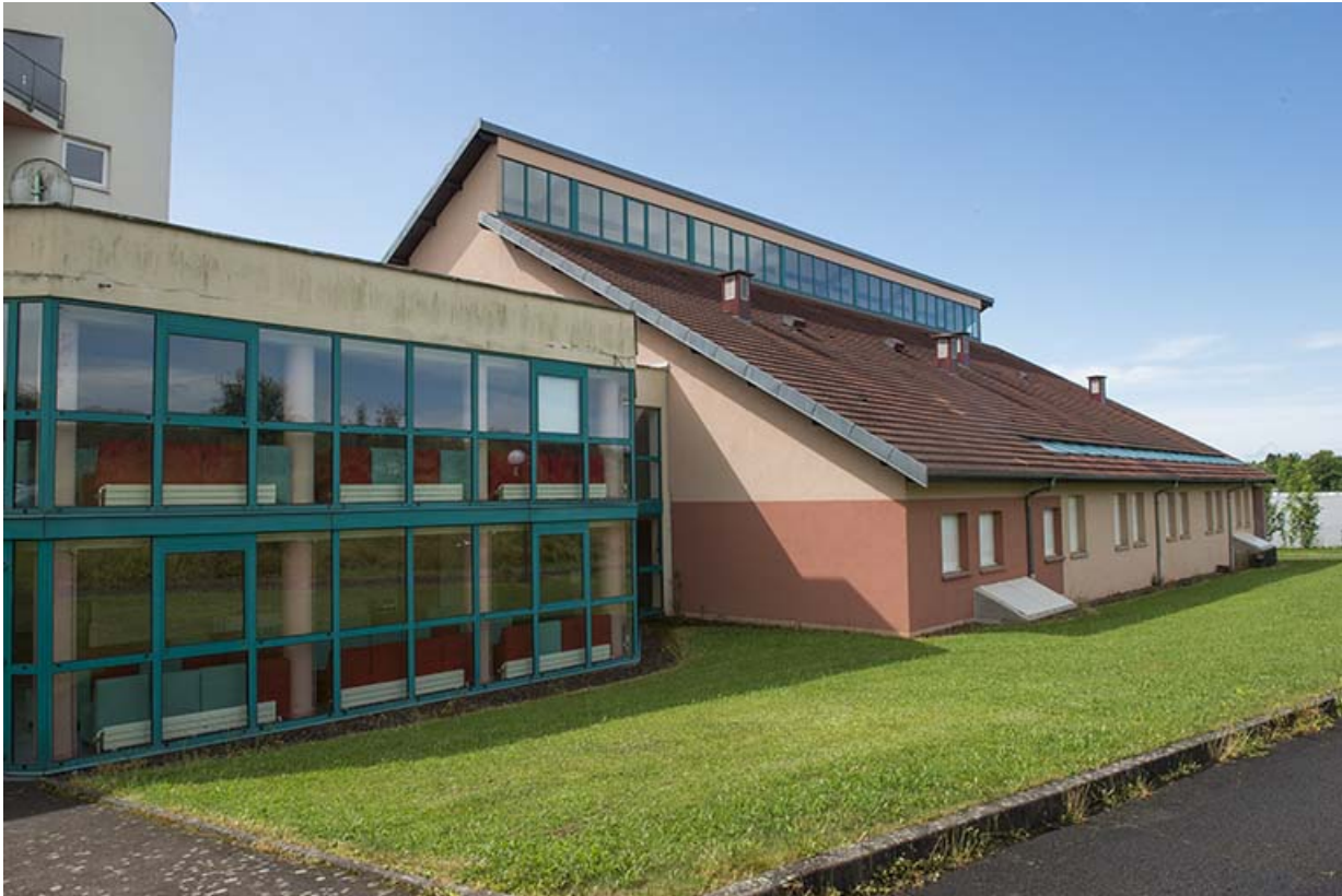
Façades postérieures nord de l'internat sud-ouest.
