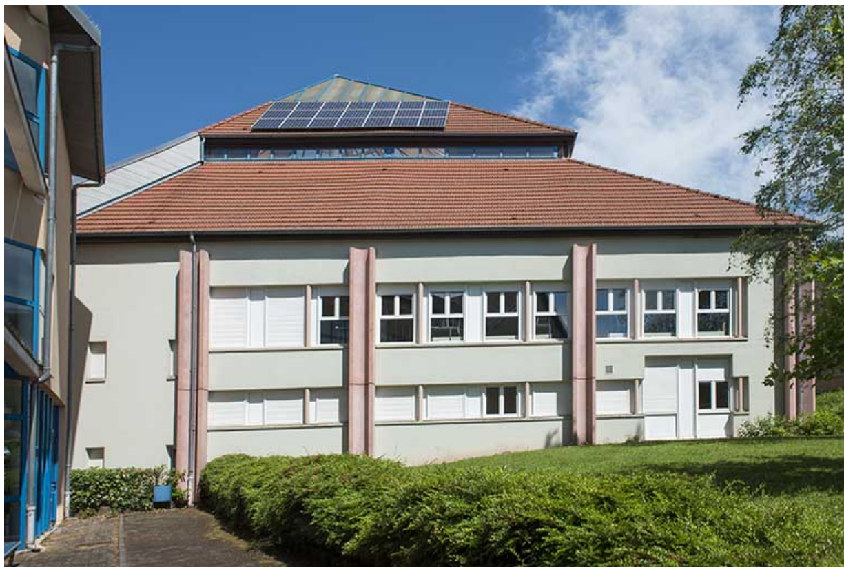
Façade sud du centre de documentation et d'information.
