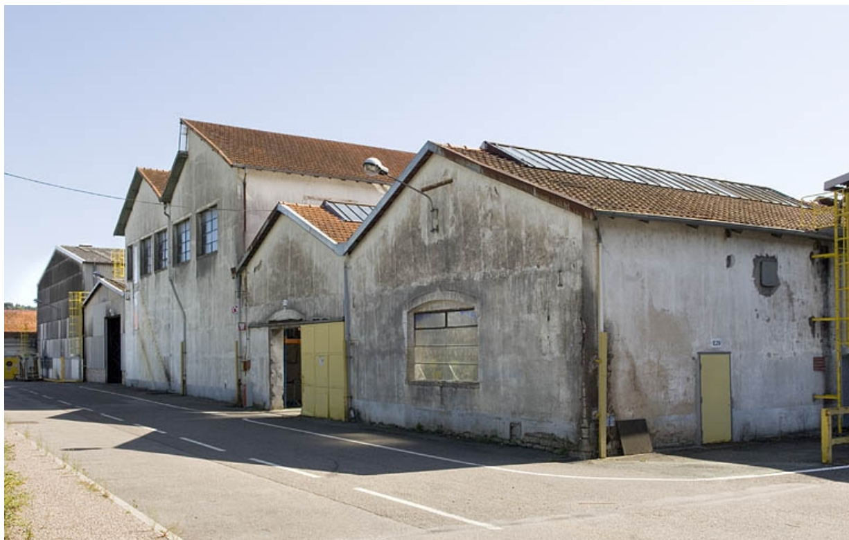
Pignons ouest de magasins industriels et de la fonderie.
