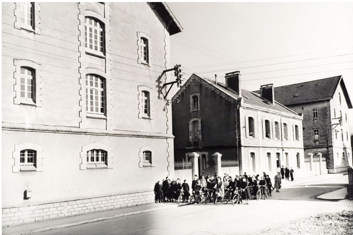
Vue d'ensemble depuis la rue Jean Jaurès des ailes B et C des bâtiments d'exploitation et pavillon A. Sortie du personnel. 70, Vesoul, 53 rue Jean Jaurès
