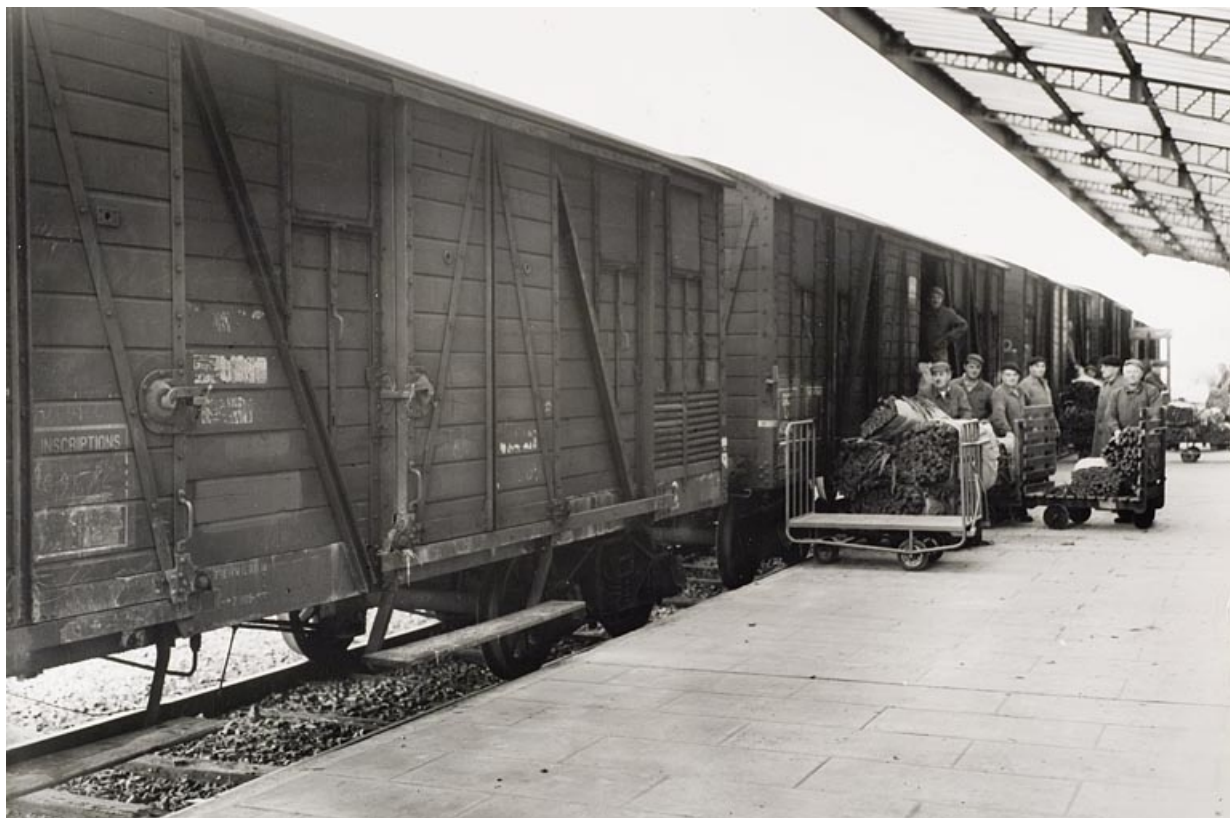
Quai de l'embranchement ferroviaire. Déchargement d'une rame de wagons d'une récolte provenant d'un centre d'achat extérieur. 70, Vesoul, 53 rue Jean Jaurès
