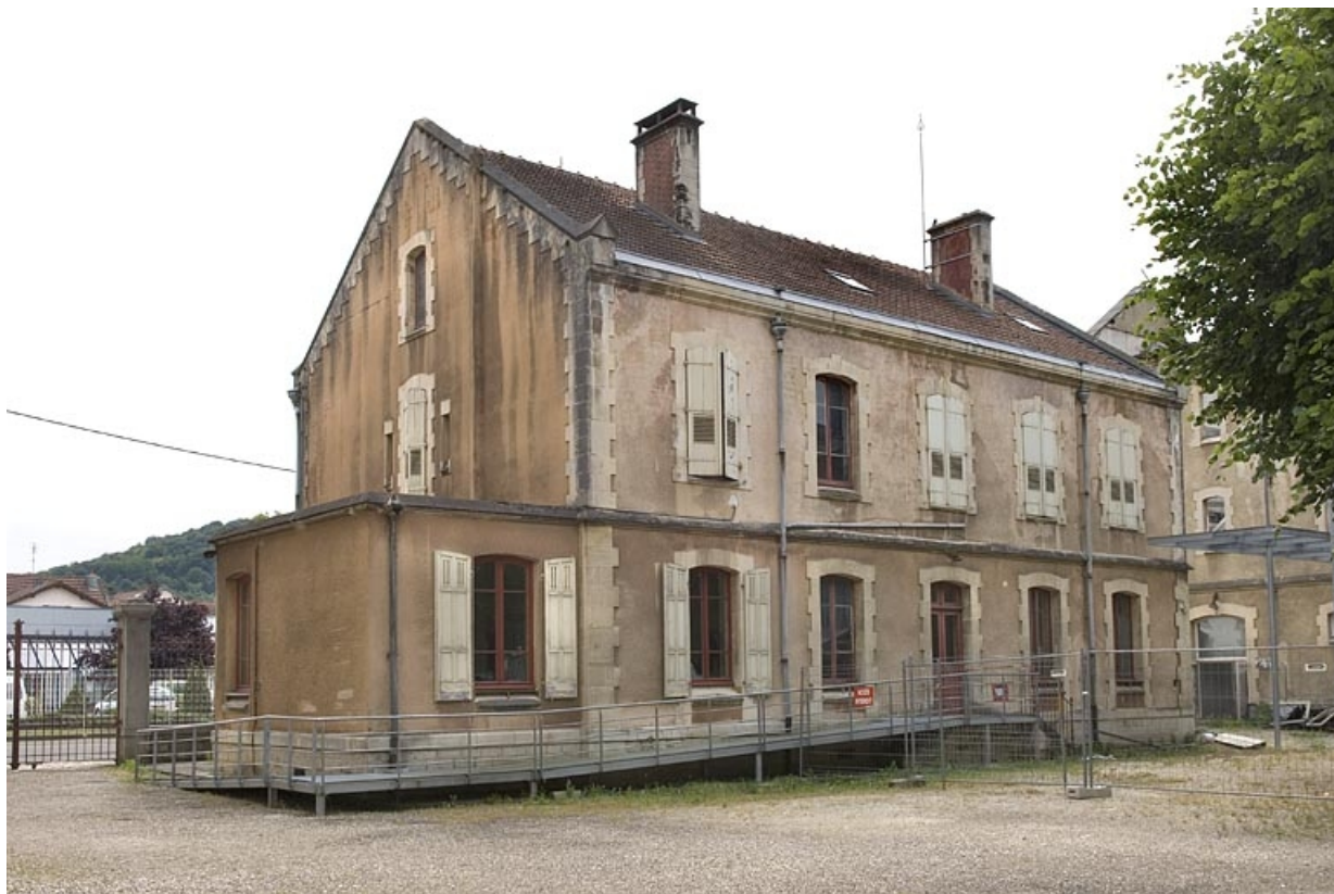
Façade postérieure du bâtiment des bureaux.
