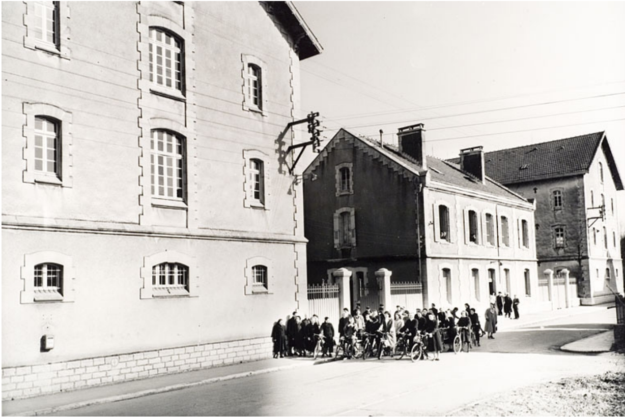
Vue d'ensemble depuis la rue Jean Jaurès des ailes B et C des bâtiments d'exploitation et pavillon A. Sortie du personnel. 70, Vesoul, 53 rue Jean Jaurès
