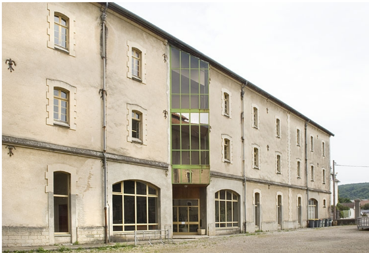
Vue depuis la cour. Élévation de l'aile est.
