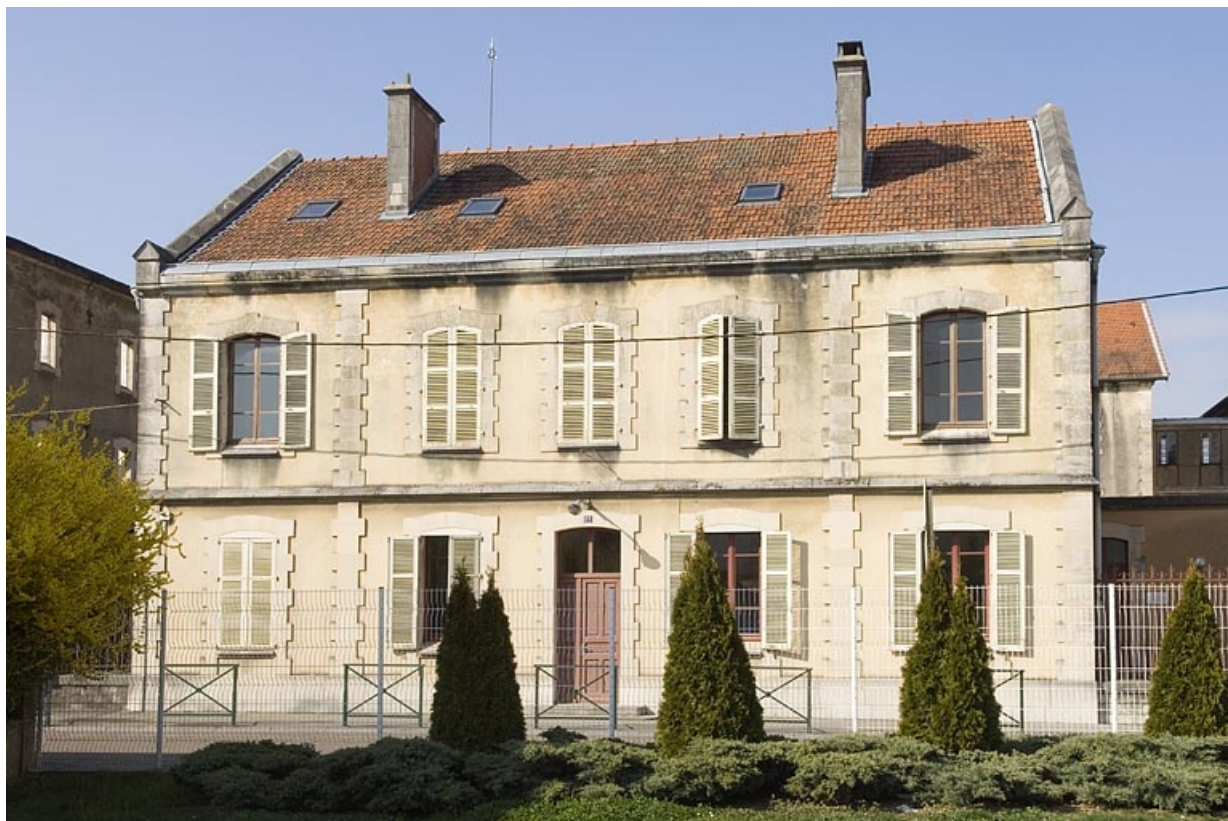
Bâtiment des bureaux. Façade antérieure.
