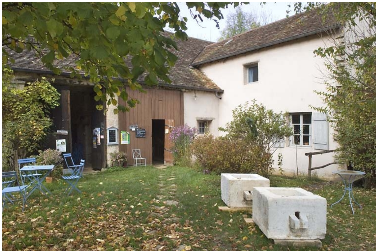
Façade est du moulin et logement.
