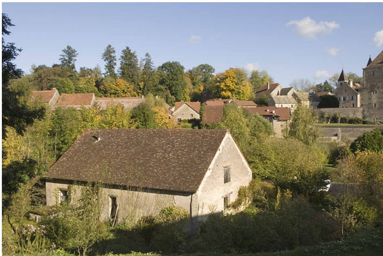
Vue plongeante depuis l'ouest. 70, Fondremand, lieudit : le Moulin
