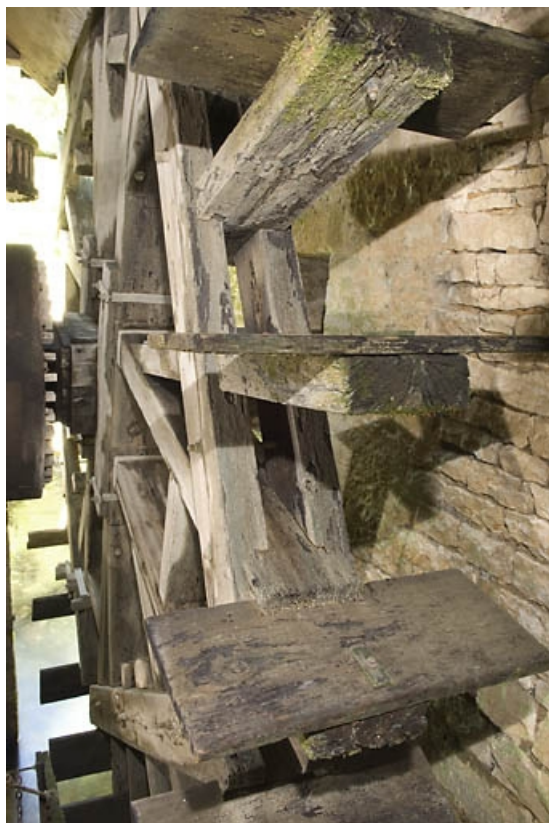
Détail de la roue hydraulique.
