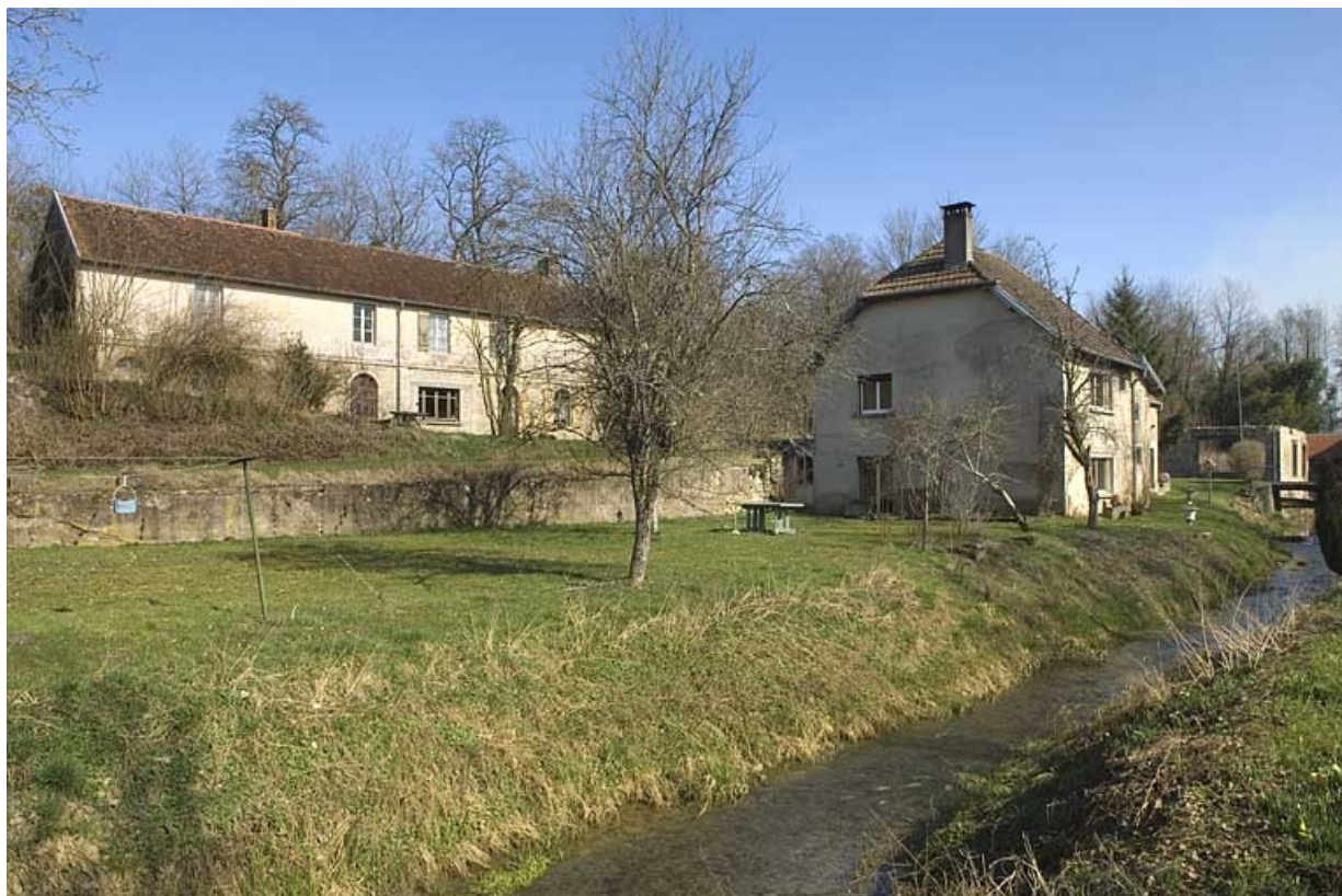
Vue d'ensemble des logements depuis le sud-ouest.
