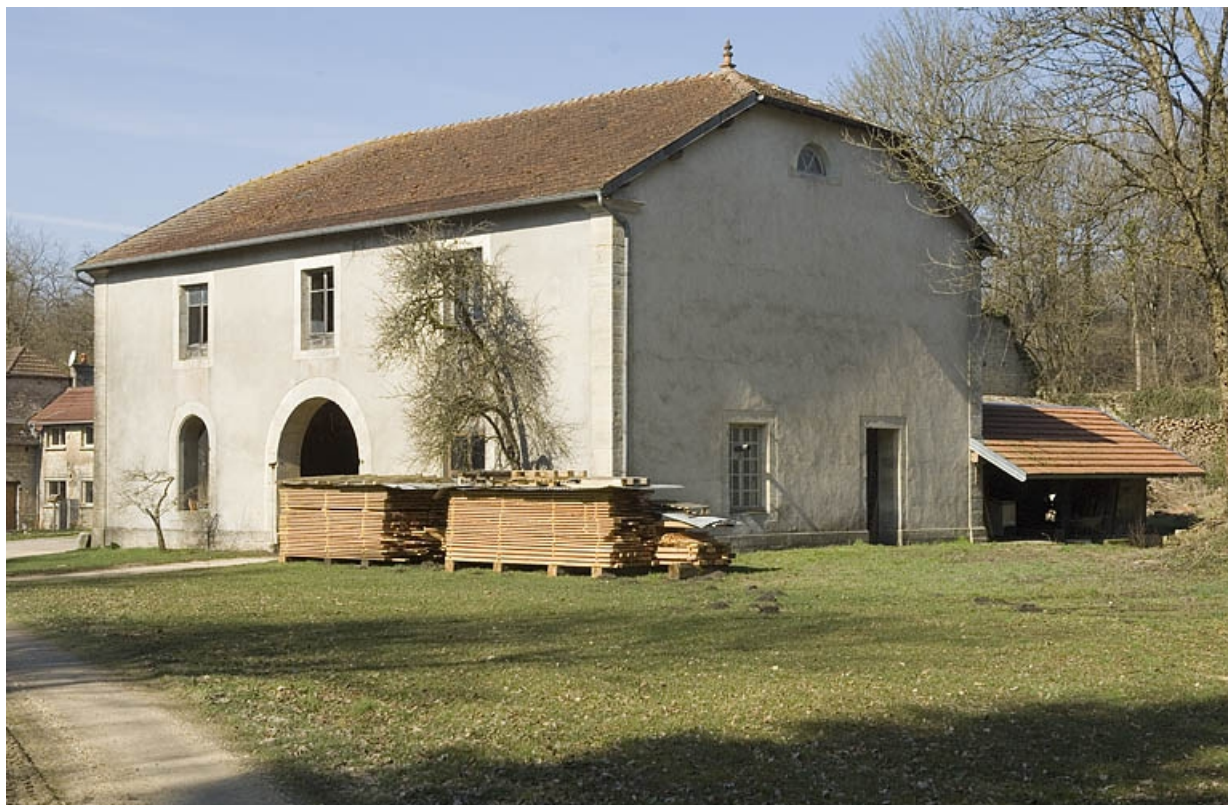
Bâtiment du haut fourneau depuis le sud-est.
