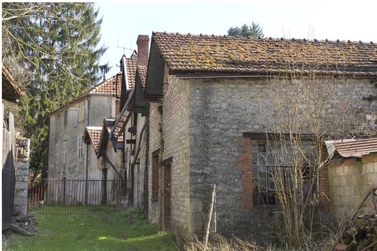
Logement et ateliers de fabrication depuis le sud-ouest.
