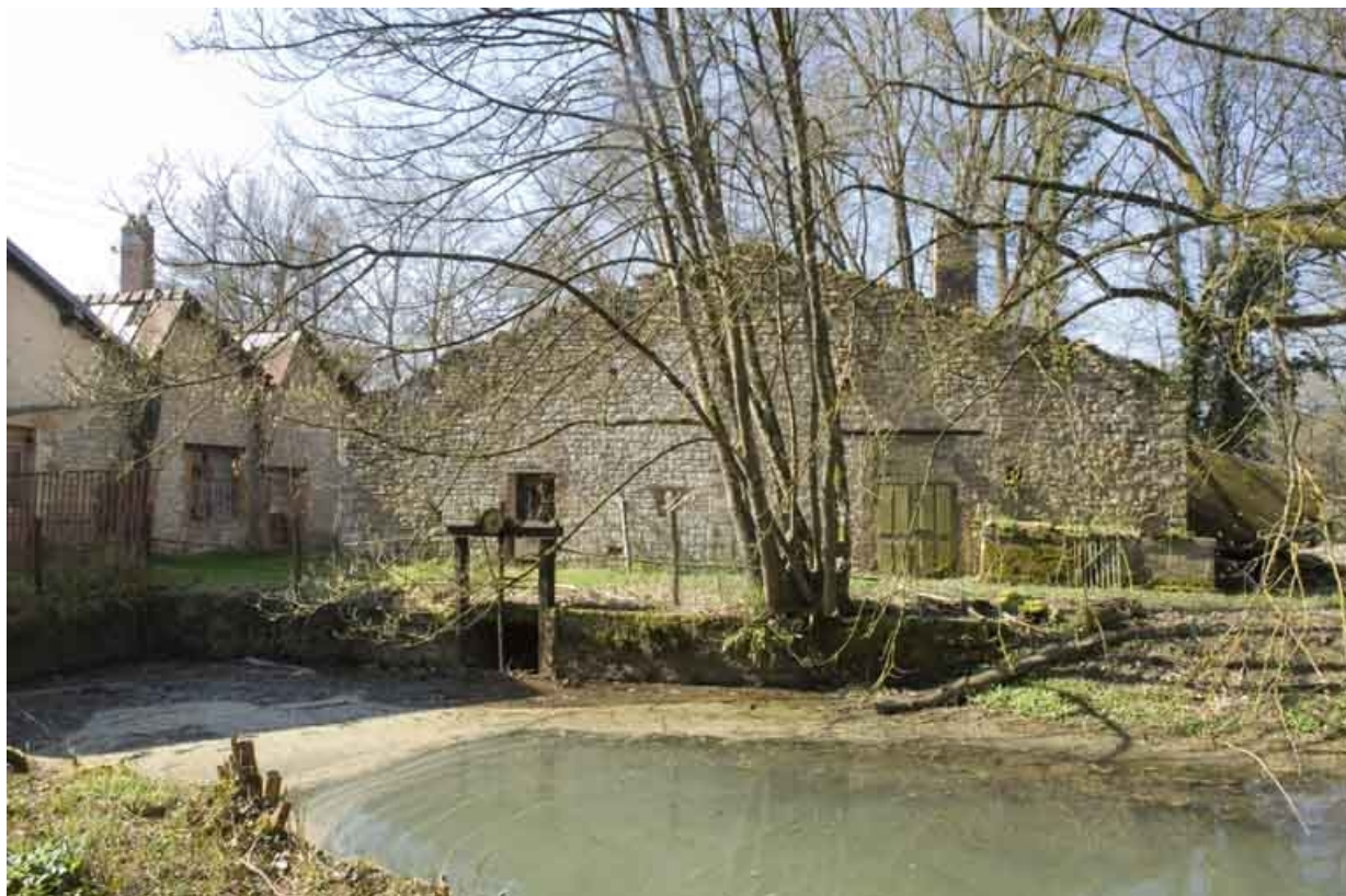
Bief d'aménée et pignon de l'entrepôt industriel (?).
