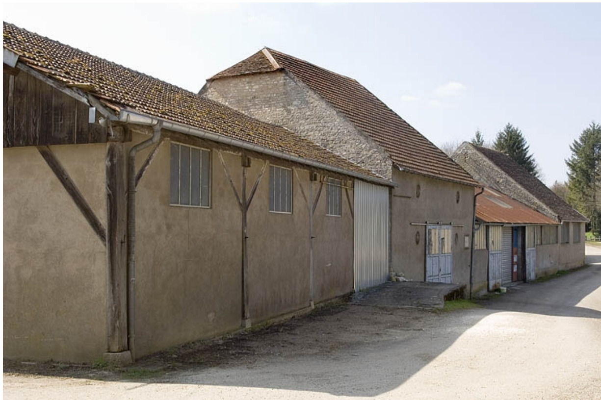
Façade nord de l'ancienne halle à charbon.
