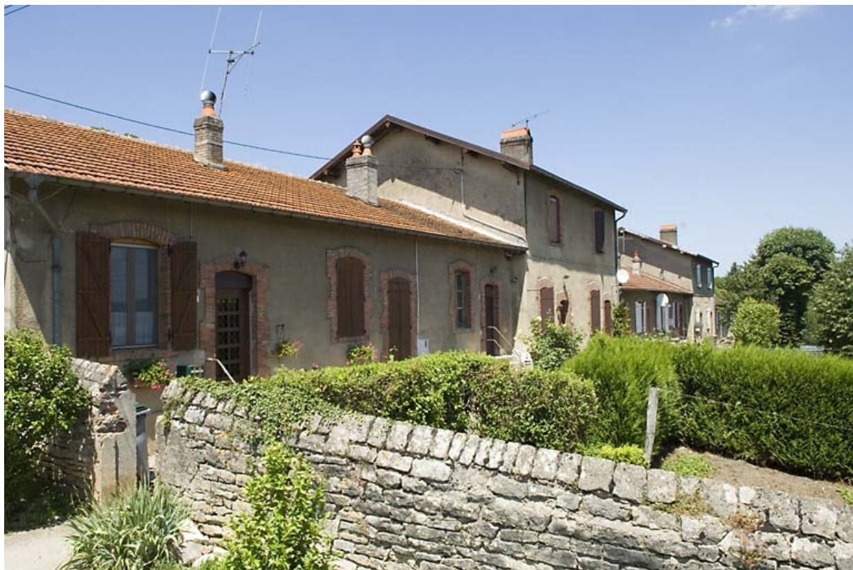
Logements ouvriers contigus. Vue depuis le sud-est.
