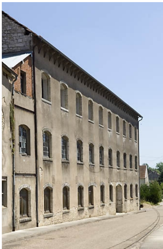
Façade sud de l'atelier de fabrication à étages.
