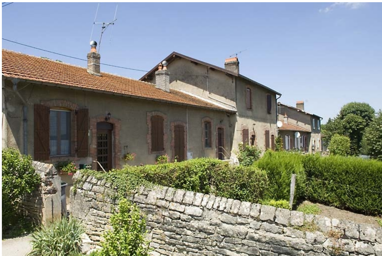
Logements ouvriers contigus. Vue depuis le sud-est.
