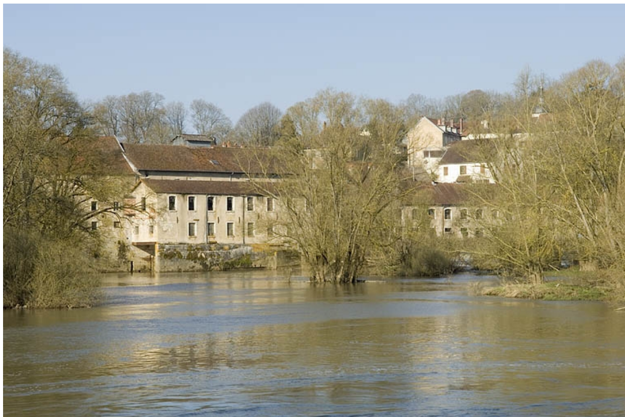
Façade sur la rivière de l'atelier de la machine à papier.
