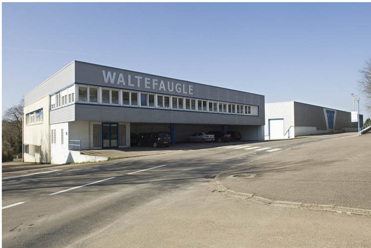
Vue d'ensemble des bâtiments au sud de la route de Champlitte.
