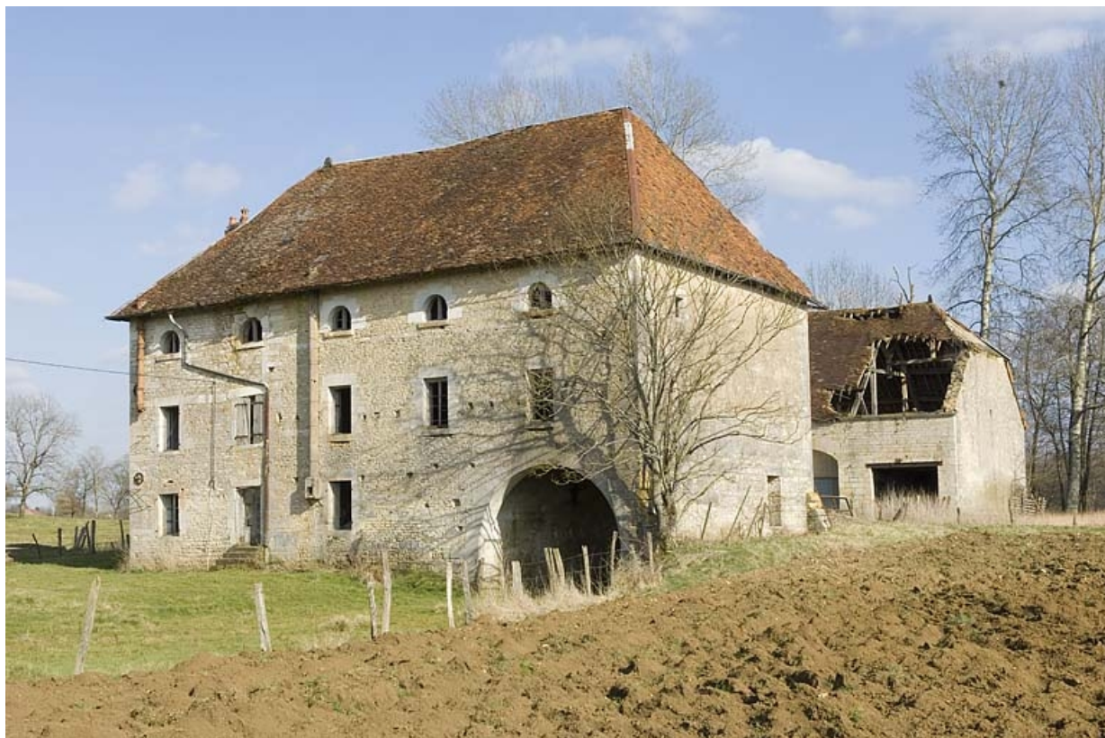
Vue depuis l'ouest.
