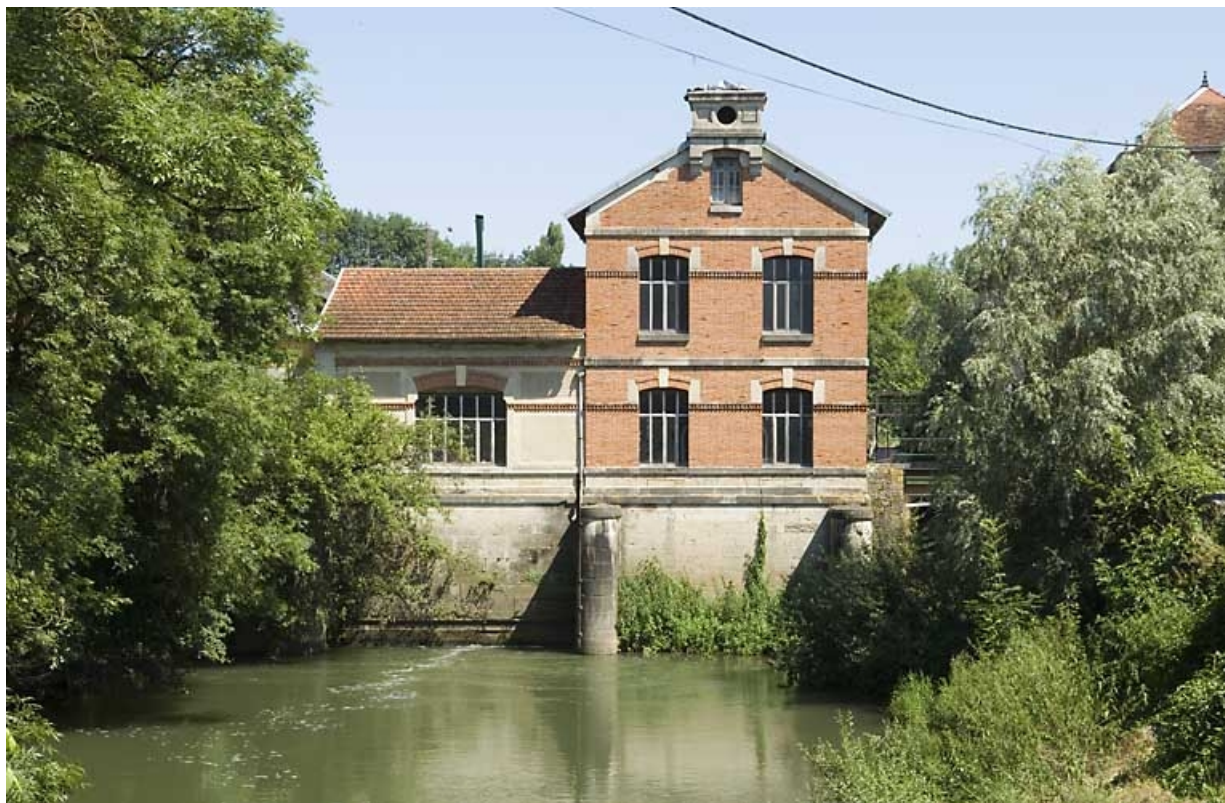
Vue rapprochée du bâtiment d'eau.
