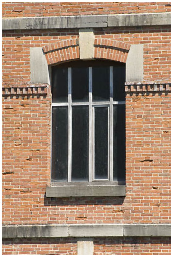
Détail d'une fenêtre du bâtiment d'eau.
