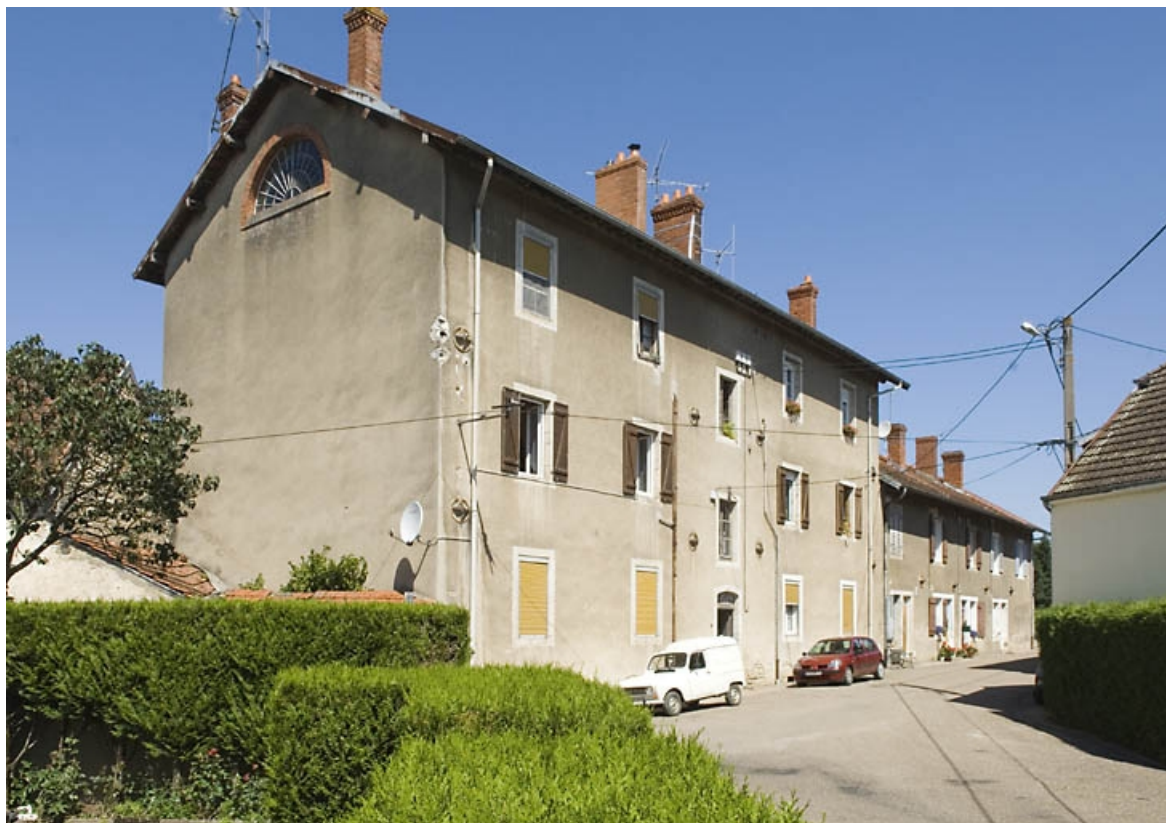
Façade est du logement ouvrier rue du Cornot. 70, Seveux, 1 Grande-Rue
