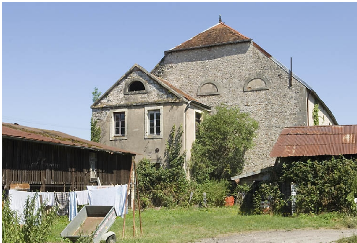
Le haut fourneau vu depuis le sud.
