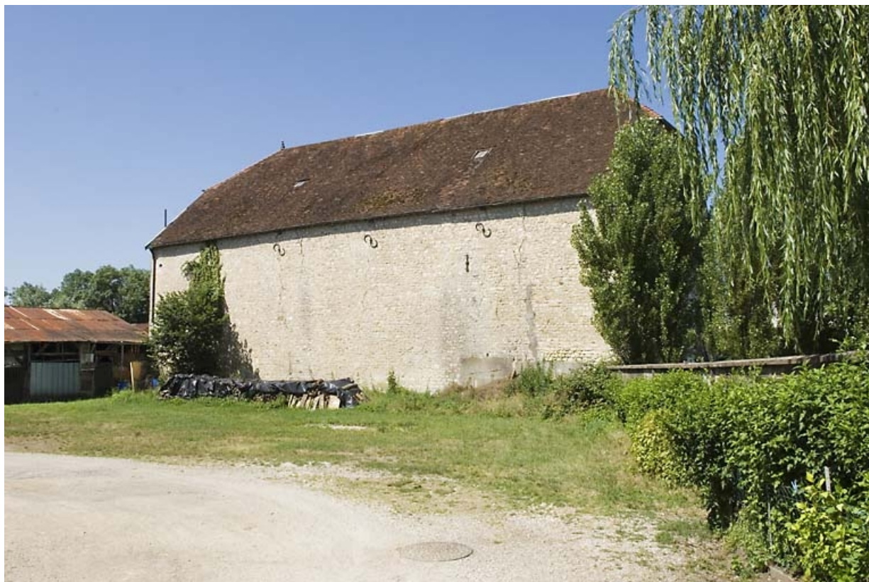
Façade est du haut fourneau.
