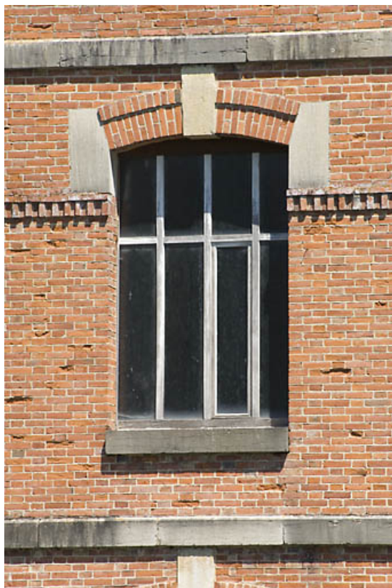
Détail d'une fenêtre du bâtiment d'eau.
