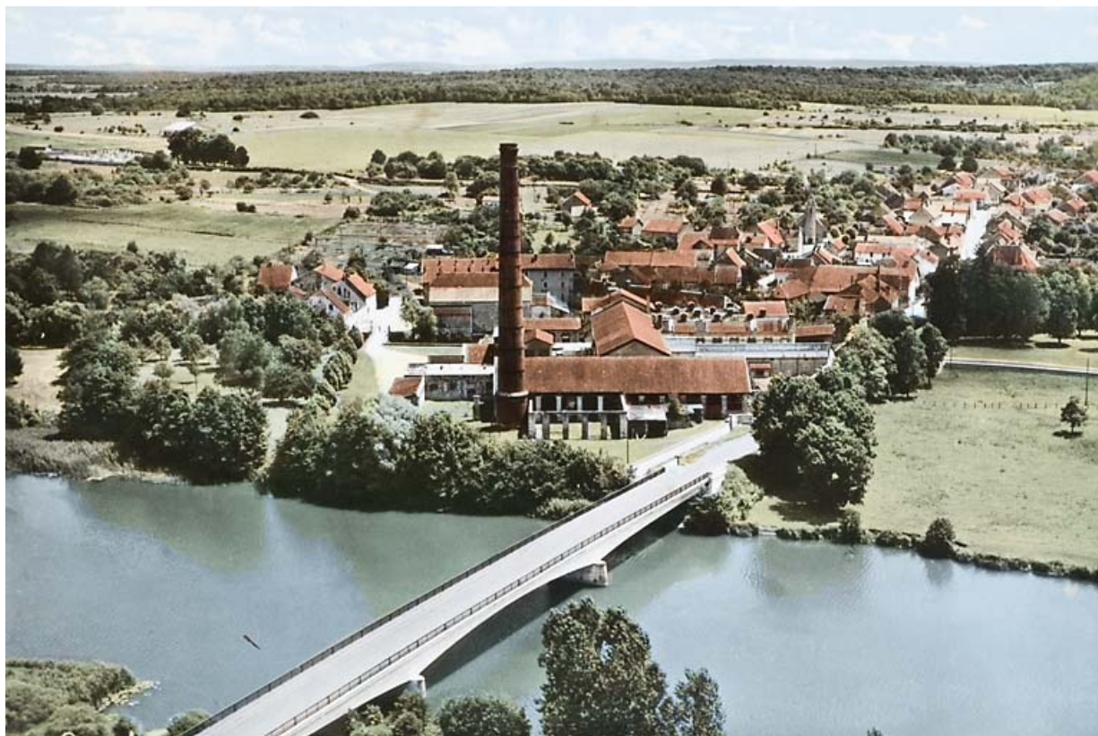
Seveux (70). Vue aérienne. Le Pont sur la Saône et les caves d'affinage.
