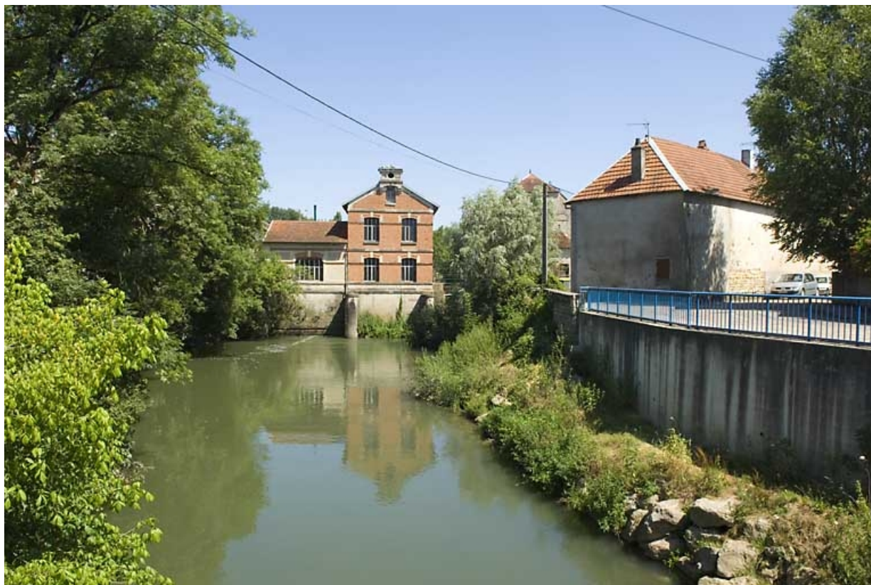
Bâtiment d'eau (actuelle centrale hydroélectrique) et canal de fuite.
