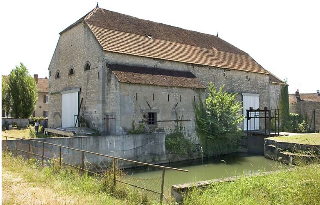
Vue du haut fourneau depuis l'ouest.
