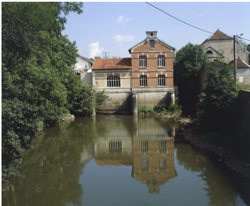
Le bâtiment de la turbine et celui du haut fourneau en 1989.
