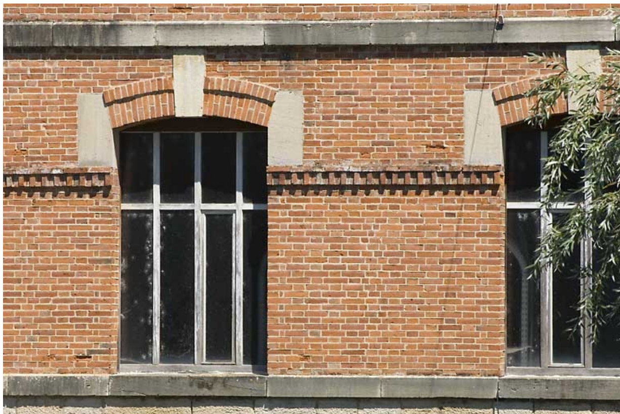
Fenêtres de la façade sud du bâtiment d'eau.
