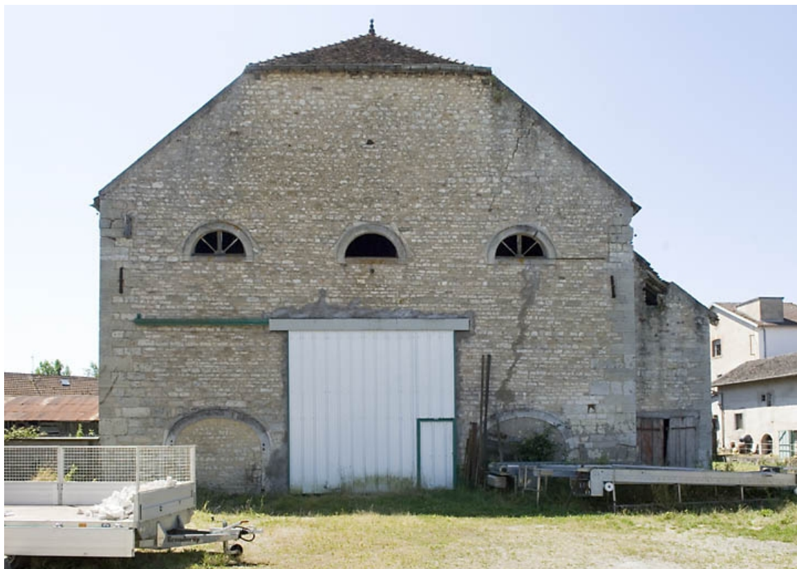
Mur-pignon nord du haut fourneau.
