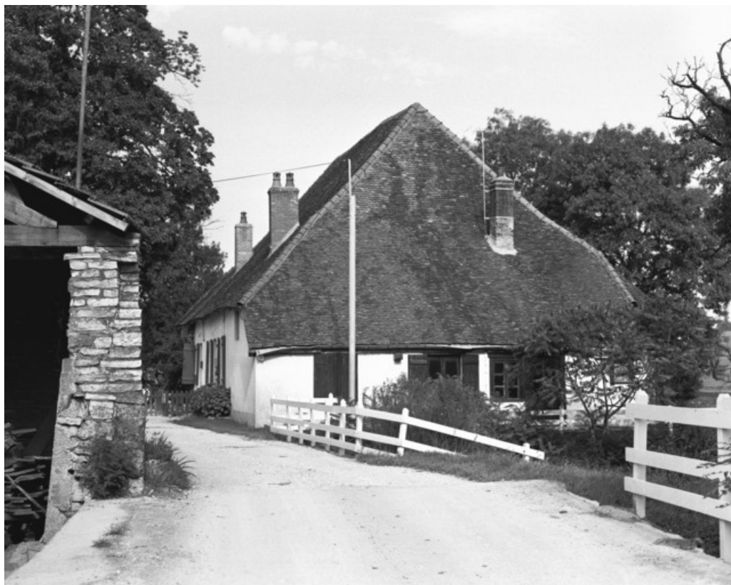
Halle à charbon vue de trois quarts en 1989.
