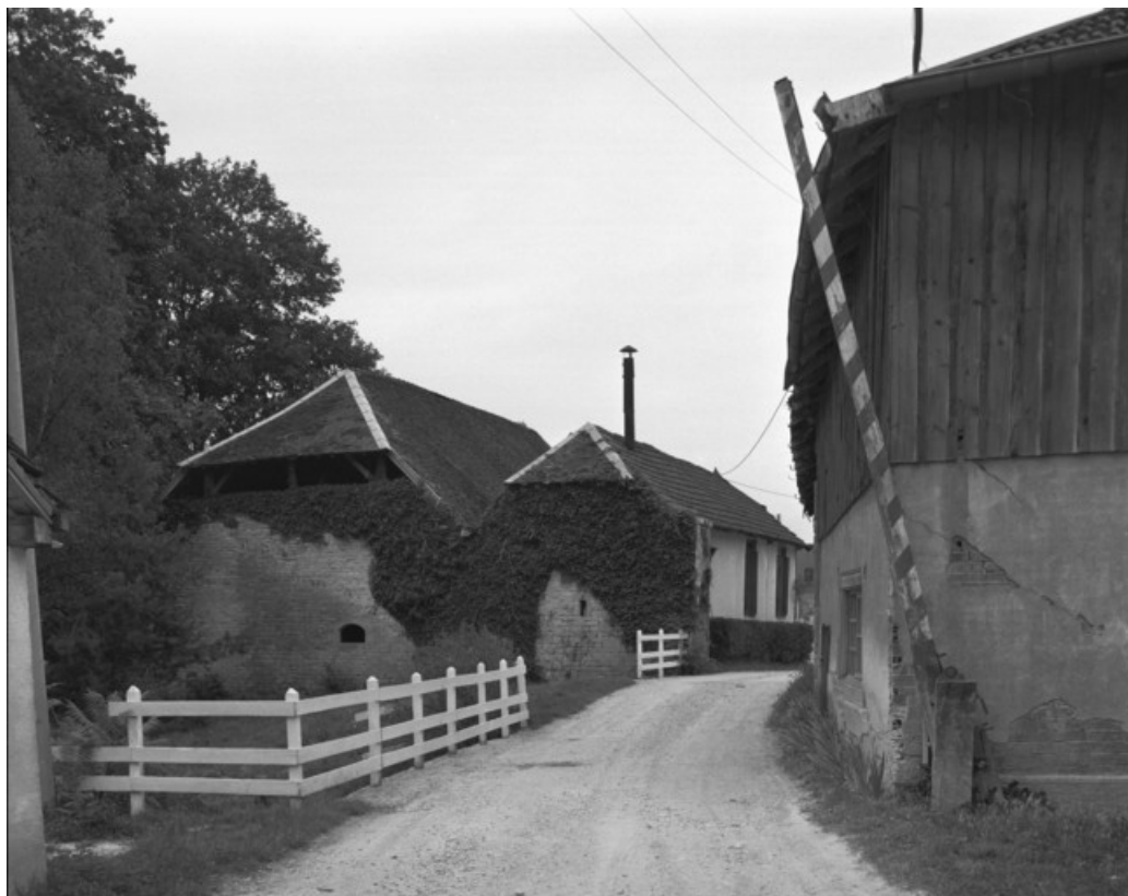
Halle à charbon sud depuis l'entrée en 1989.
