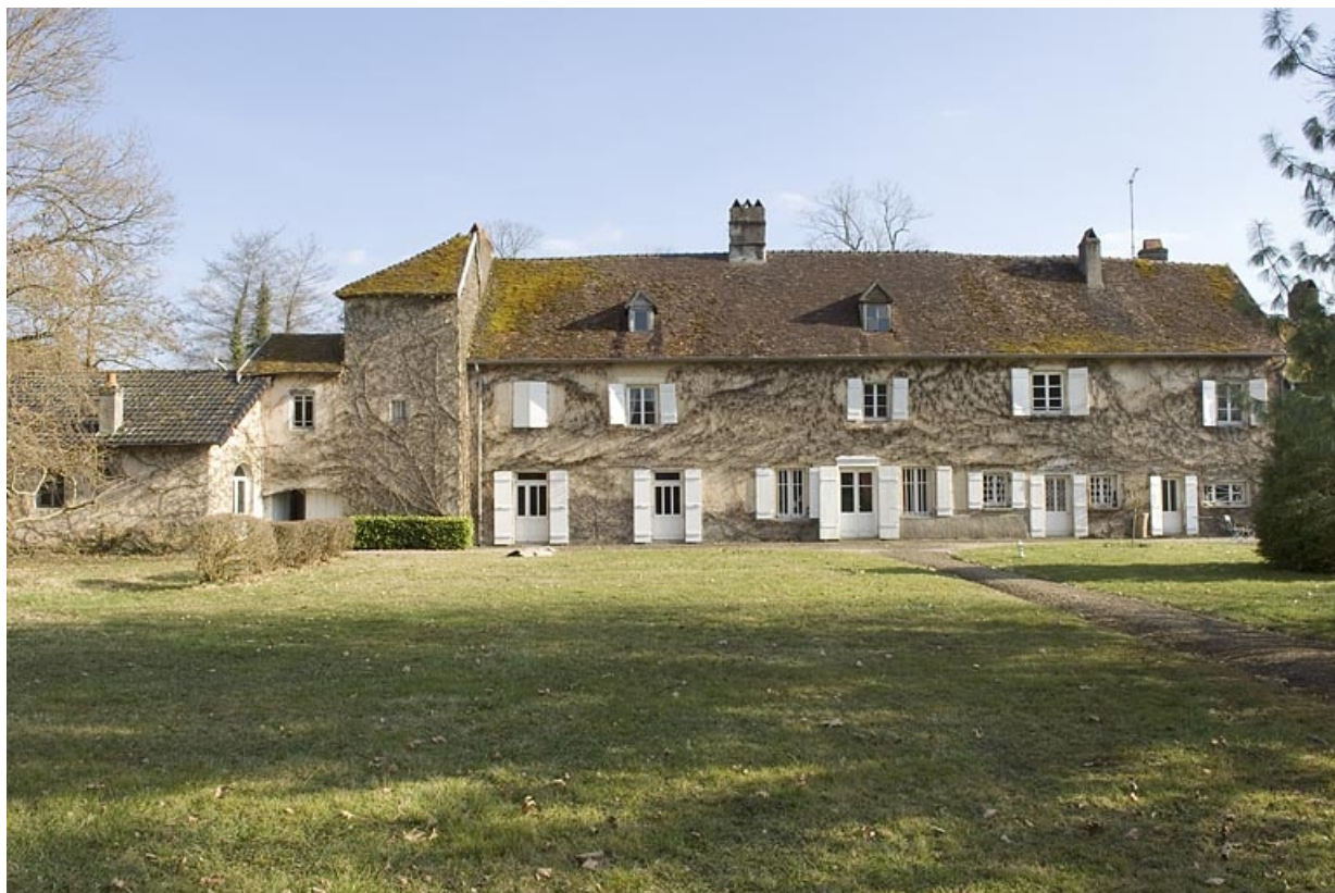
Façade postérieure du logis ouest.
