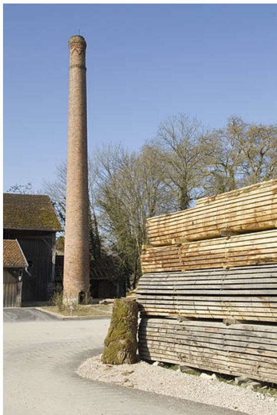
Cheminée depuis le nord-est.
