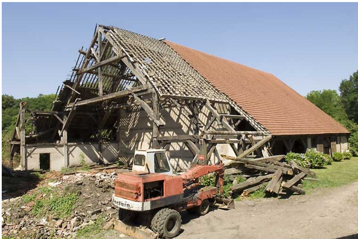
La halle à charbon vue depuis l'est.
