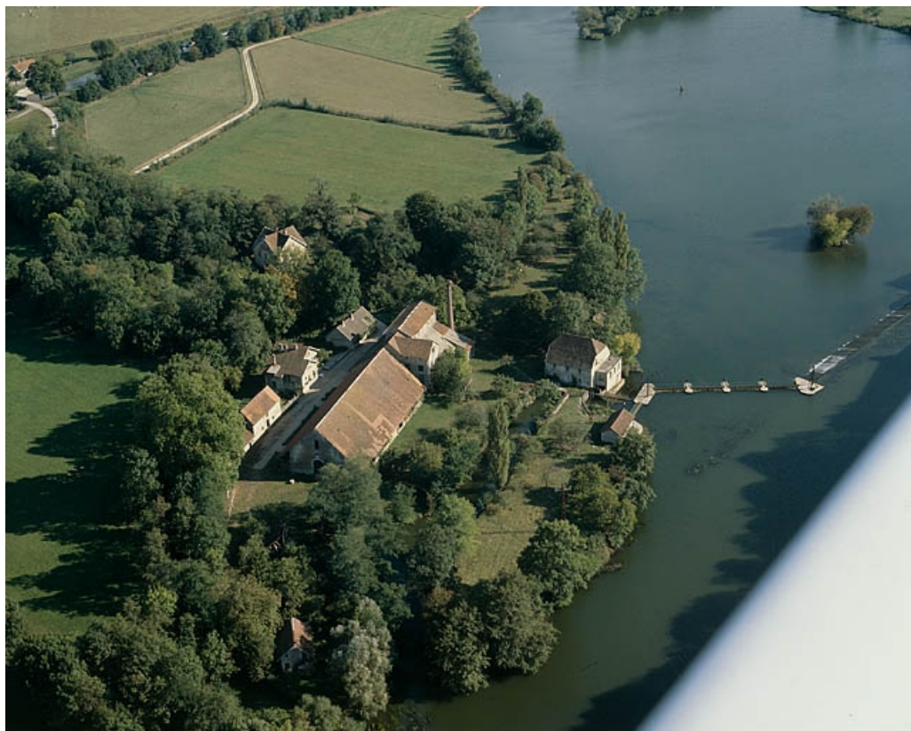
Vue aérienne plongeante depuis le nord en 1989.
