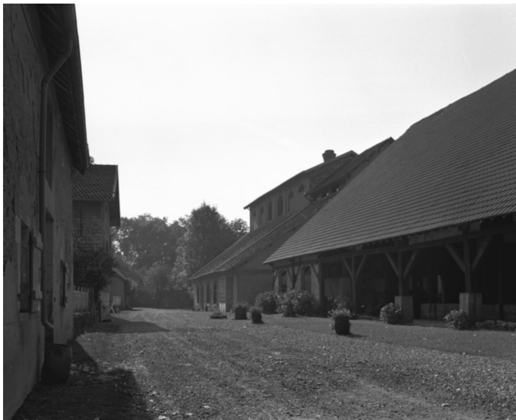
Haut fourneau et halle à charbon depuis le nord en 1990.
