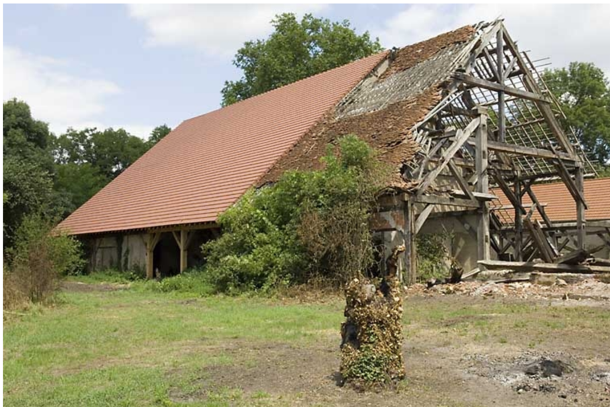
La halle à charbon vue depuis le sud.
