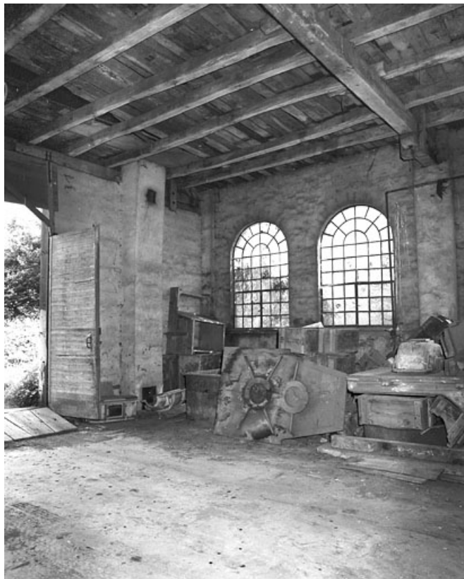
Angle nord de l'atelier de fabrication en 1981.
