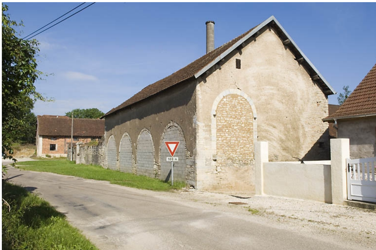
Bâtiment du haut fourneau vu de trois quarts.
