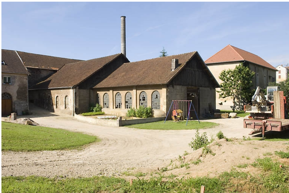
Atelier de fonderie et logement patronal depuis le nord-est. 70, Vy-le-Ferroux, 7 rue de Raze
