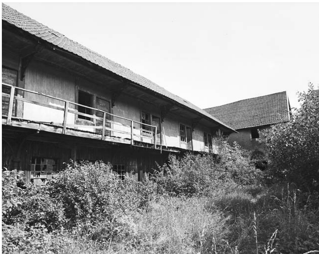
Ateliers en rez-de-chaussée et logements ouvriers à l'étage.
