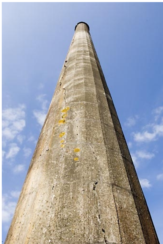
Cheminée vue en contre-plongée (1).
