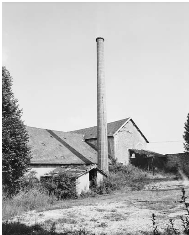
La cheminée et l'atelier de fabrication depuis le nord-ouest en 1981.
