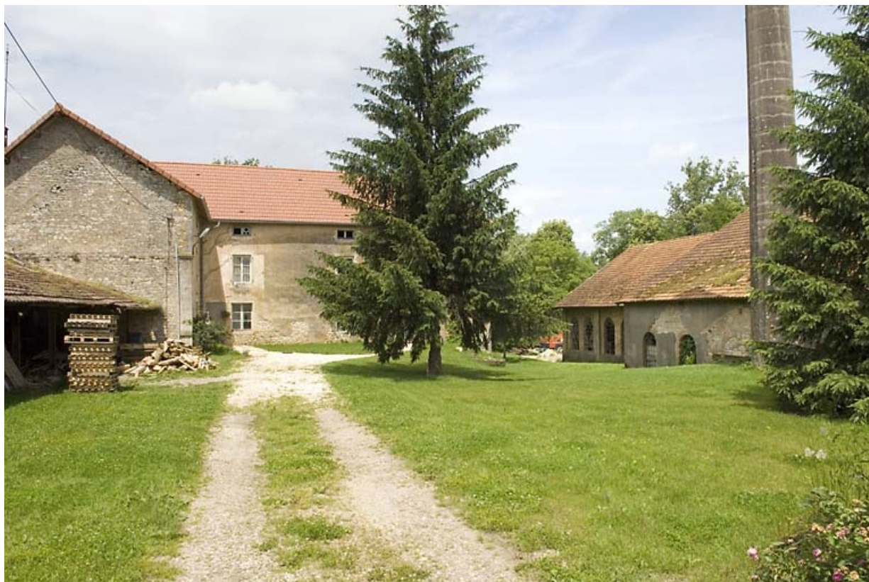
Vue d'ensemble depuis l'entrée.
