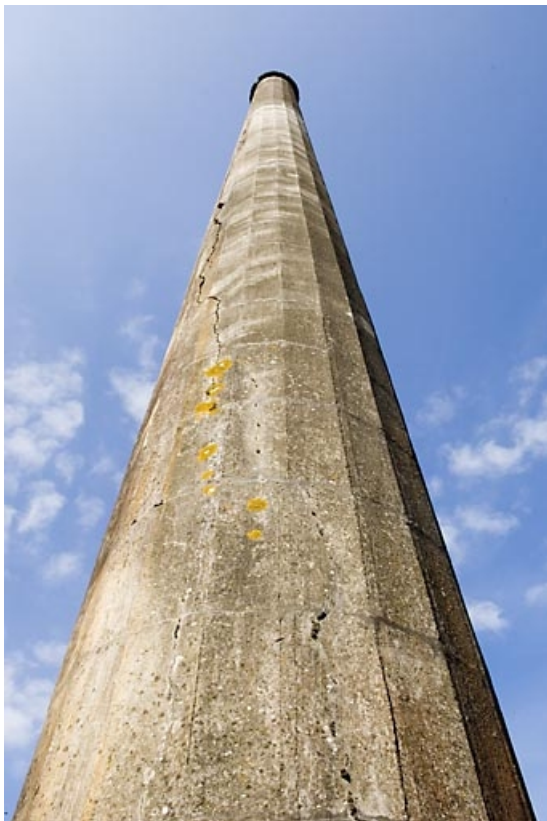
Cheminée vue en contre-plongée (1).
