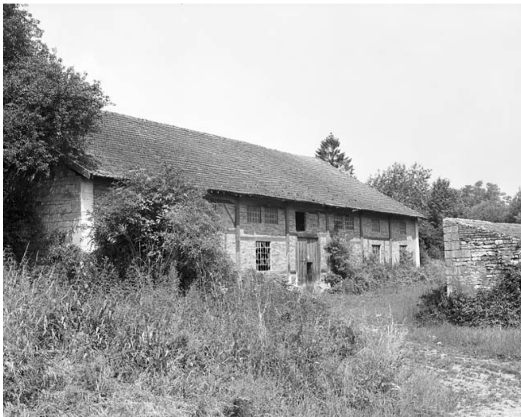
La halle à charbon en 1981.
