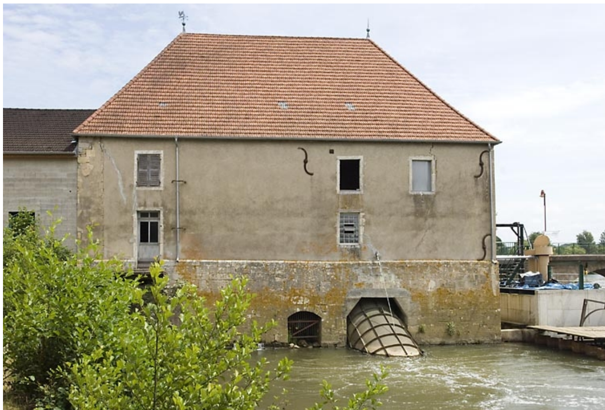
Façade postérieure du moulin.
