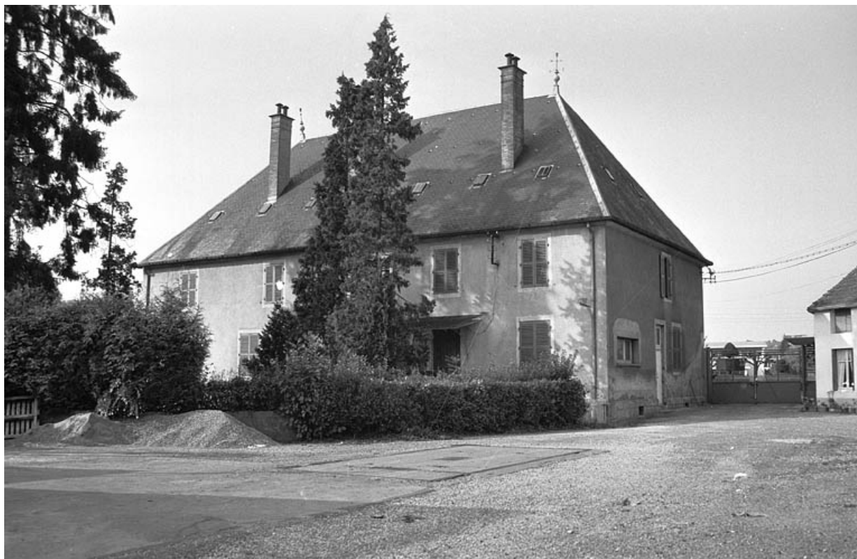
Logement patronal vu de trois quarts arrière en 1987.
