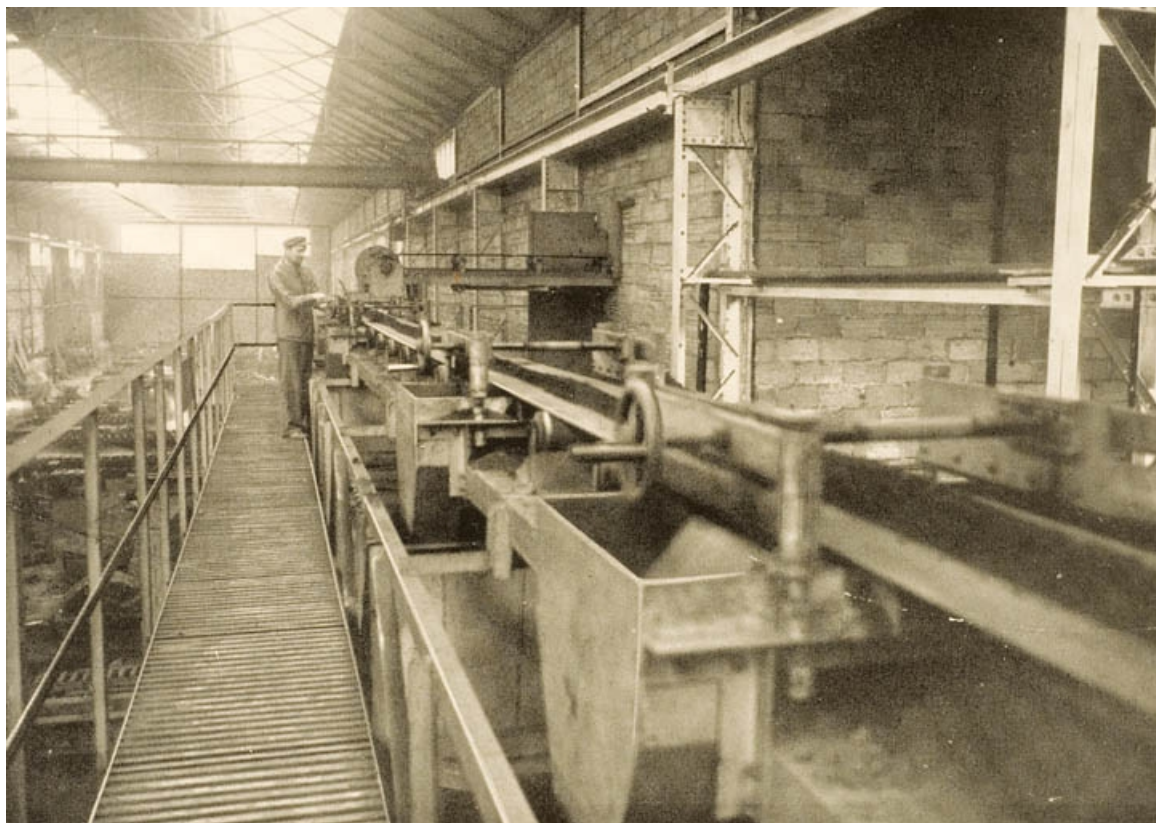
Halle de moulage. Alimentation automatique des machines à mouler.
