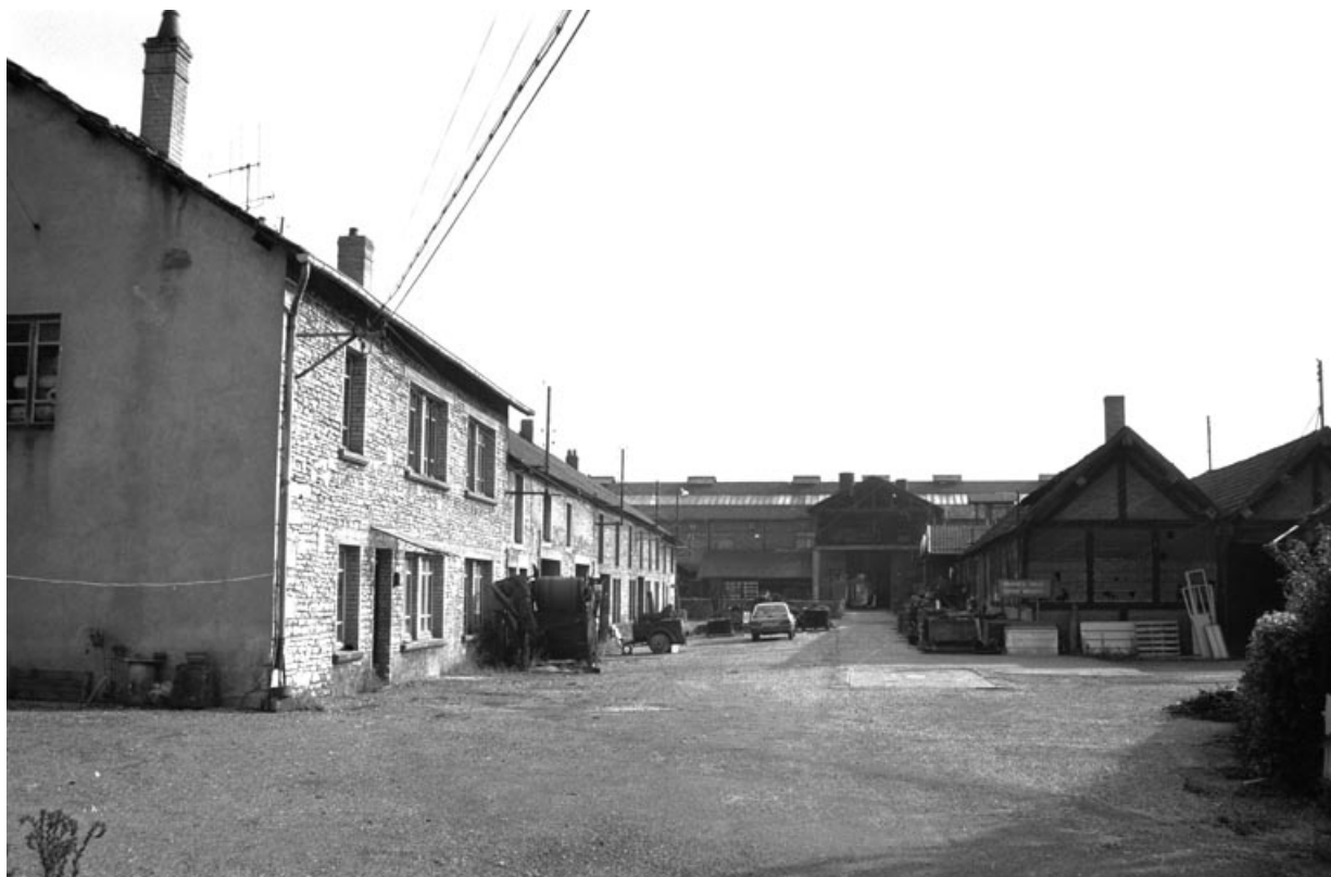
Vue d'ensemble depuis l'entrée en 1987.
