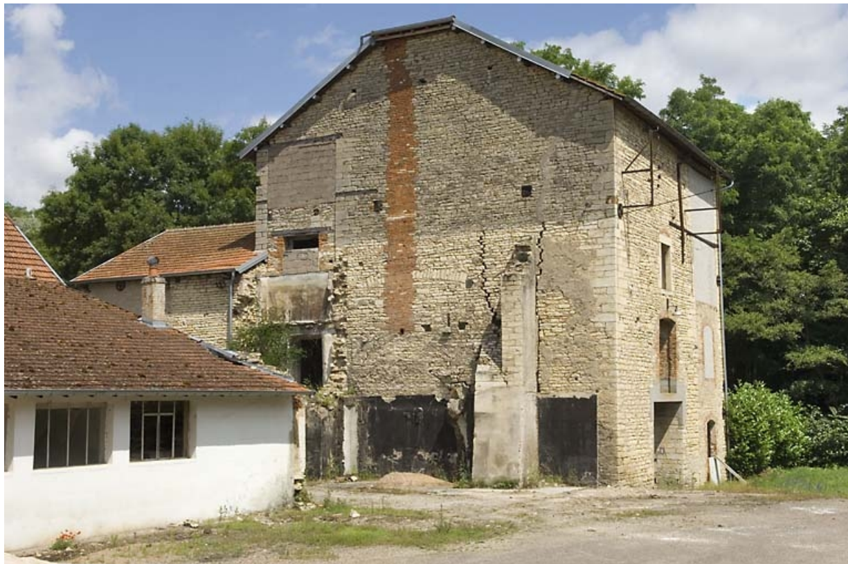
Le haut fourneau vu depuis le sud.
