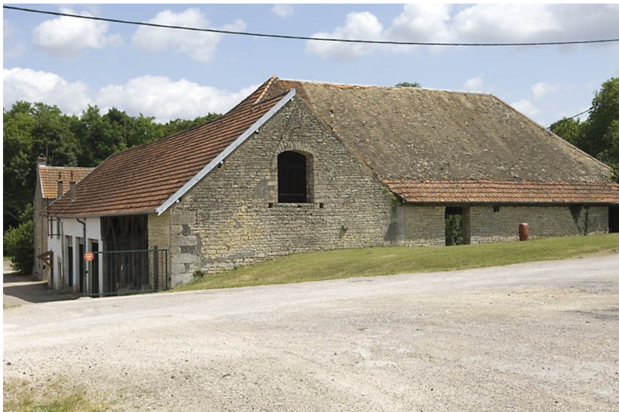
Halle à charbon depuis le sud-est.
