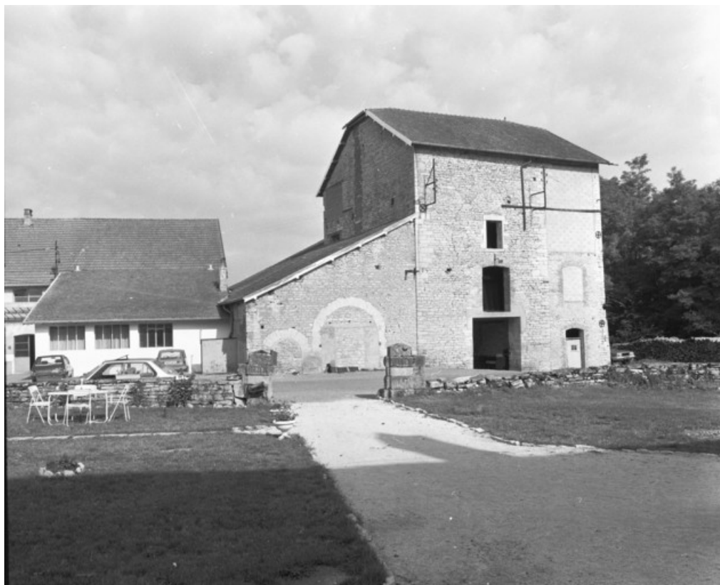
Vue d'ensemble du bâtiment du haut fourneau. Elévation est en 1989.
