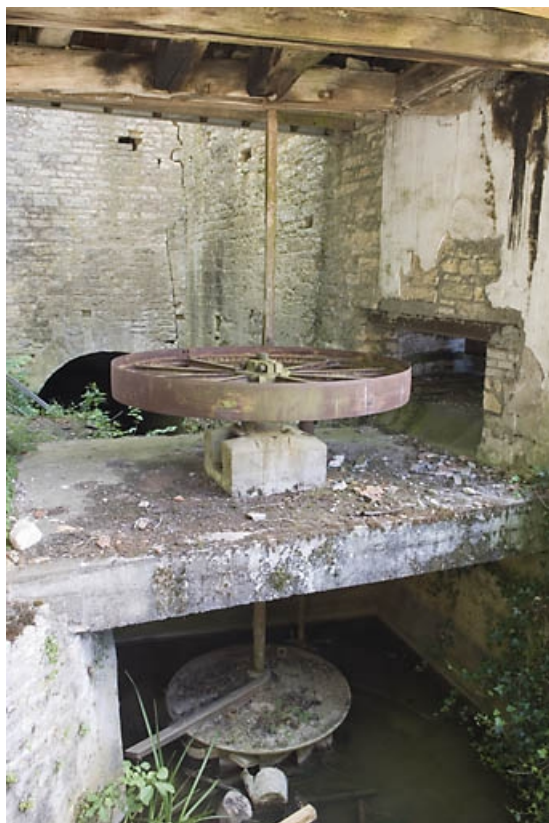
Bâtiment d'eau. Turbine hydraulique et éléments de transmission.
