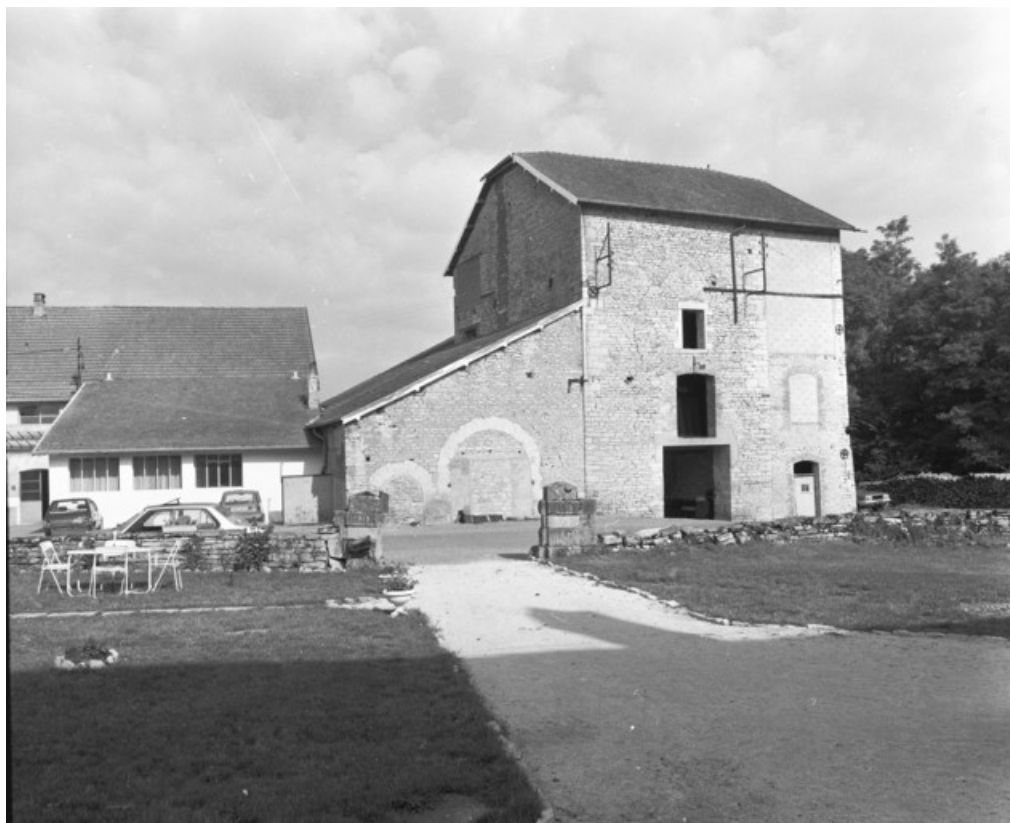
Vue d'ensemble du bâtiment du haut fourneau. Elévation est en 1989. 70, Framont, lieudit : le Crochot
