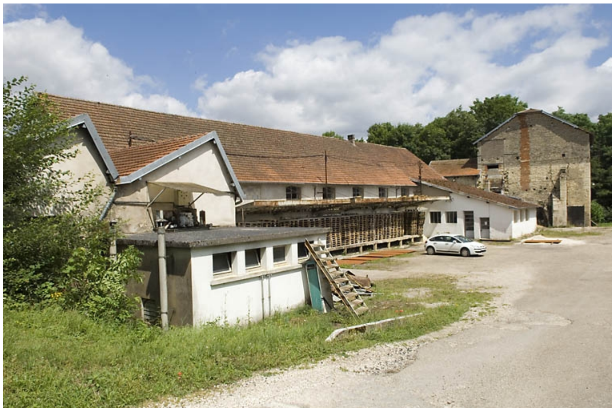
Vue d'ensemble depuis l'entrée du site.
