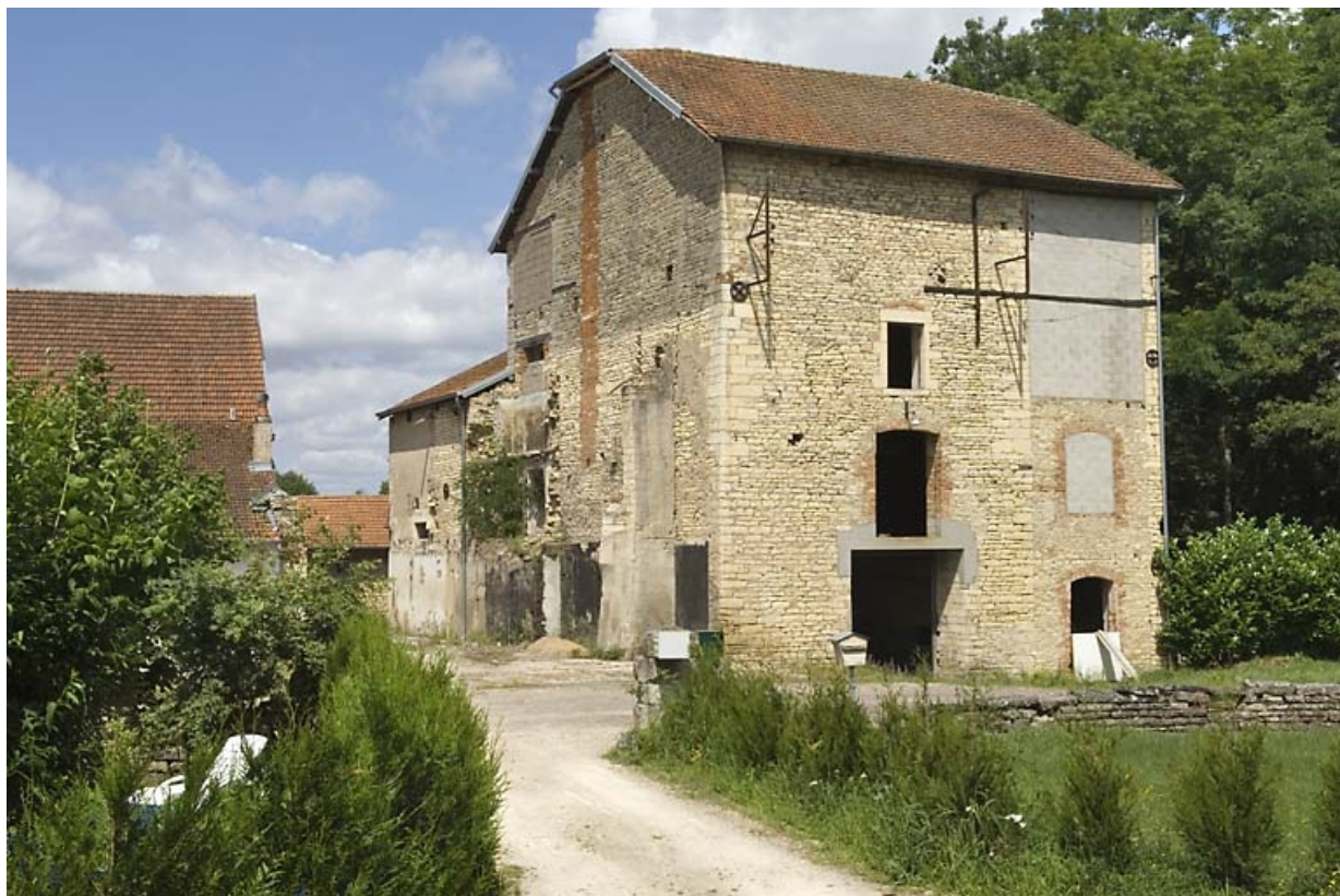
Le haut fourneau vu depuis le sud-ouest.
