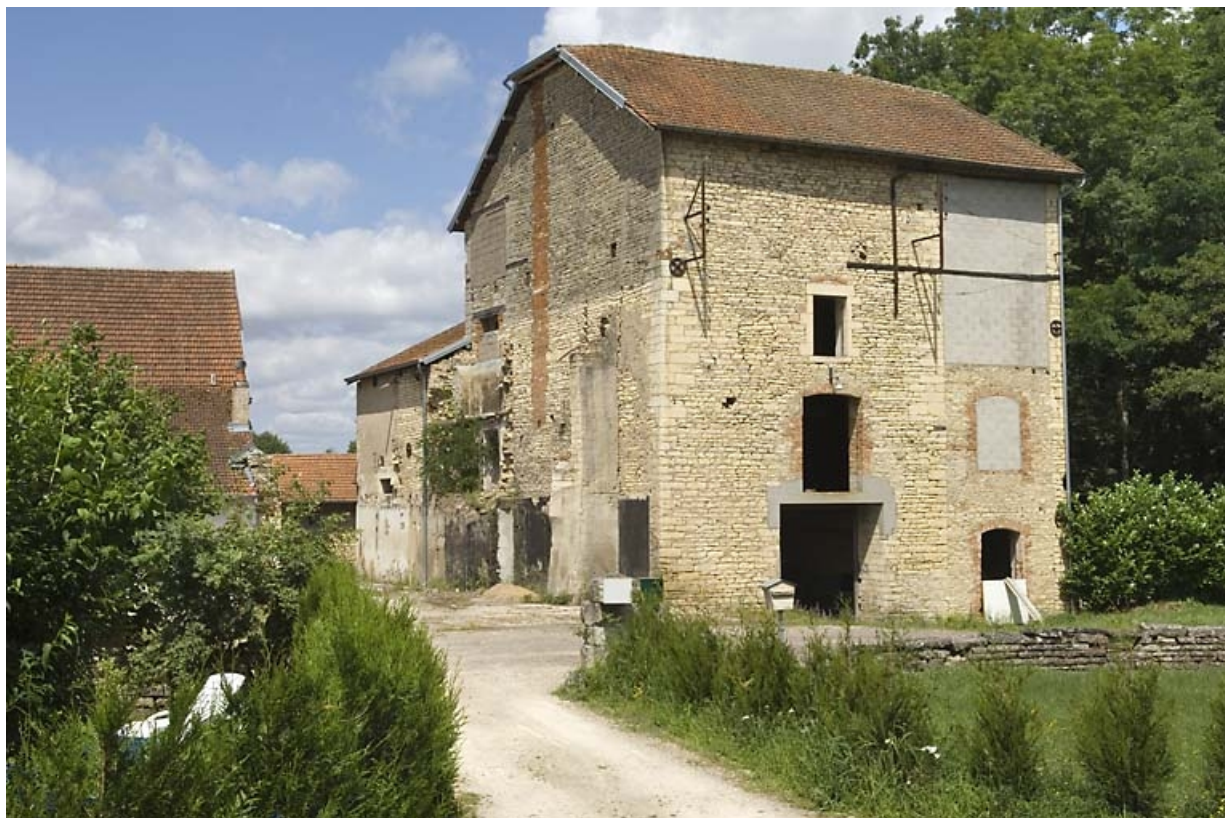
Le haut fourneau vu depuis le sud-ouest.
