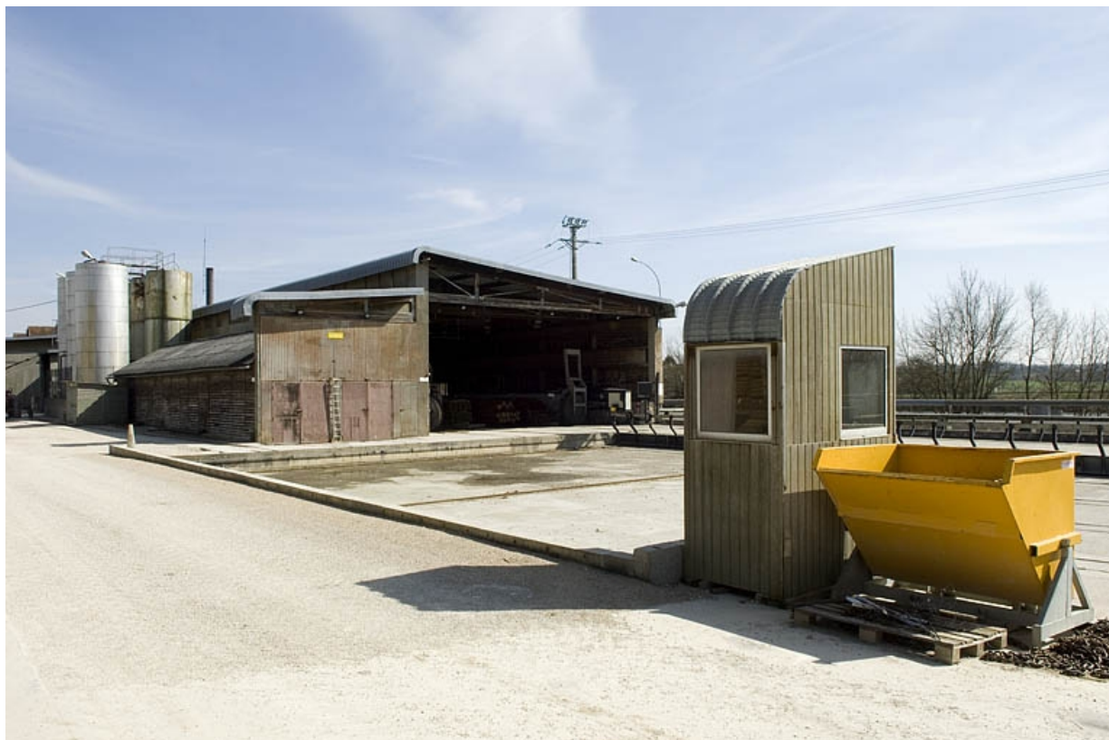
Atelier de fabrication depuis le nord-ouest. 70, Arc-lès-Gray R.D. 70
