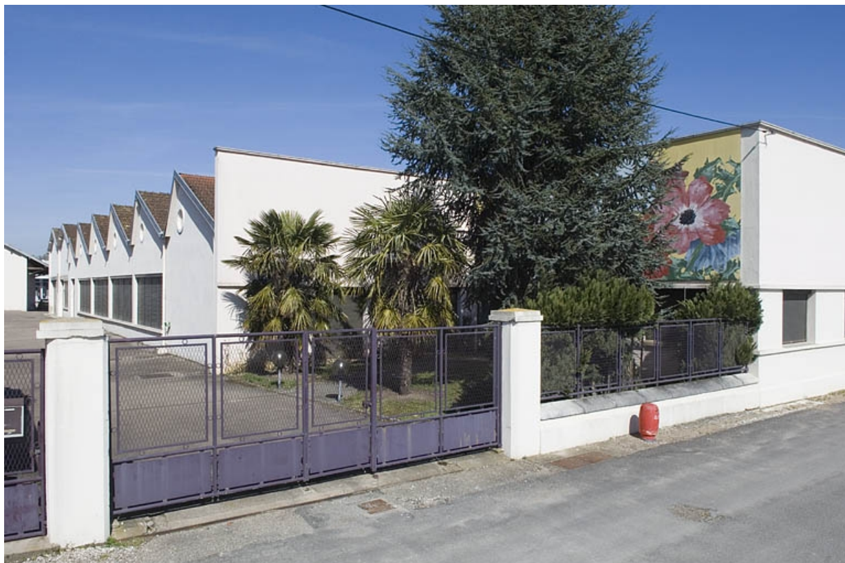
Vue de l'atelier depuis l'ancienne entrée.
