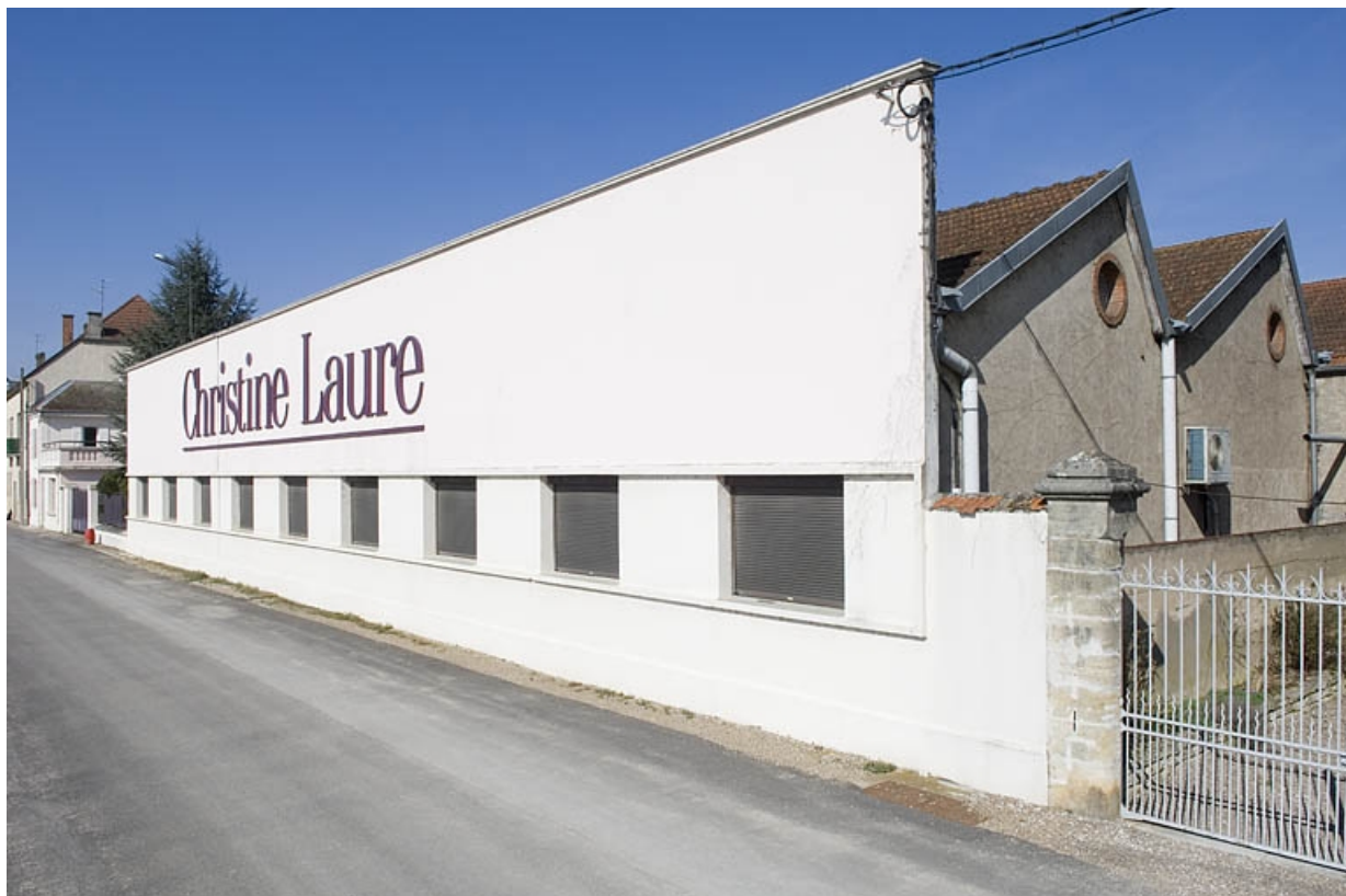
Façade sud de l'atelier de fabrication.
