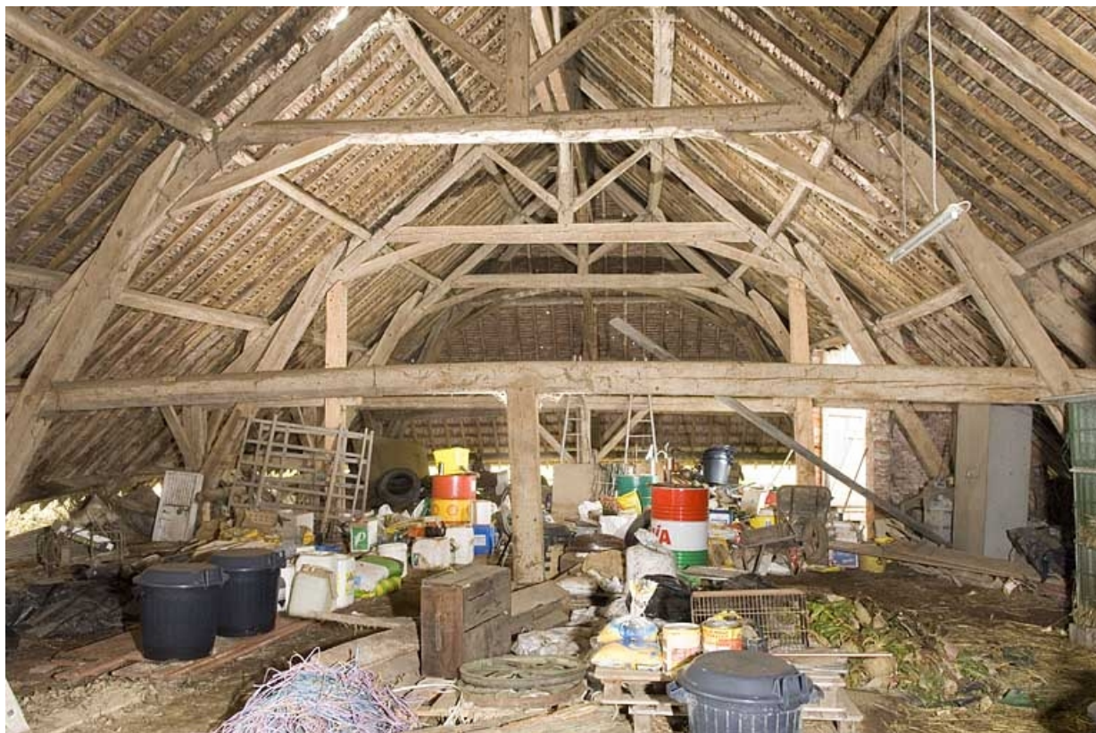
Séchoir. Partie sud de la charpente.
