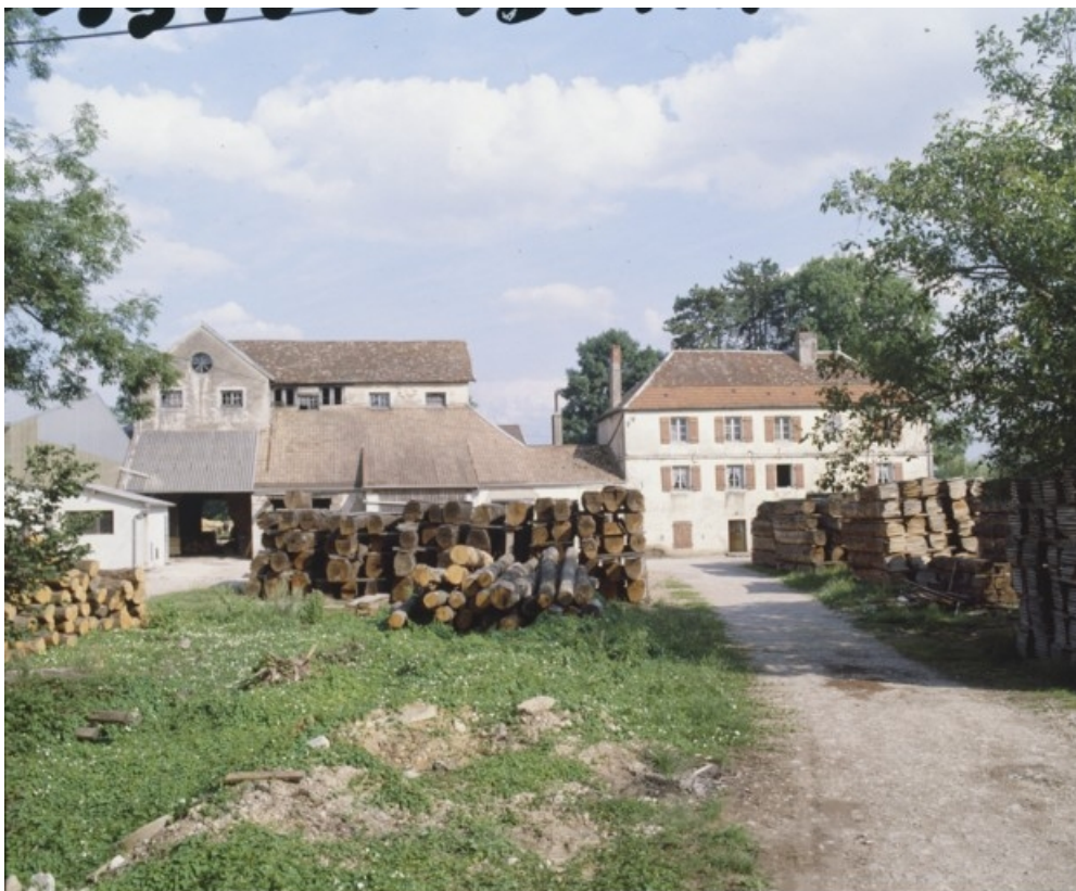
Vue d'ensemble depuis l'entrée du site en 1989.
