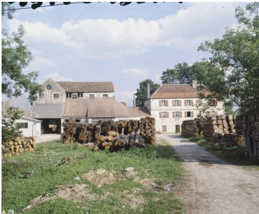
Vue d'ensemble depuis l'entrée du site en 1989.
