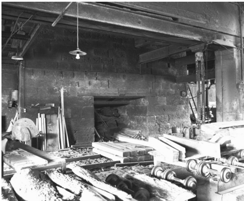
Mur nord du haut fourneau (ouverture de la tuyère) en 1990.
