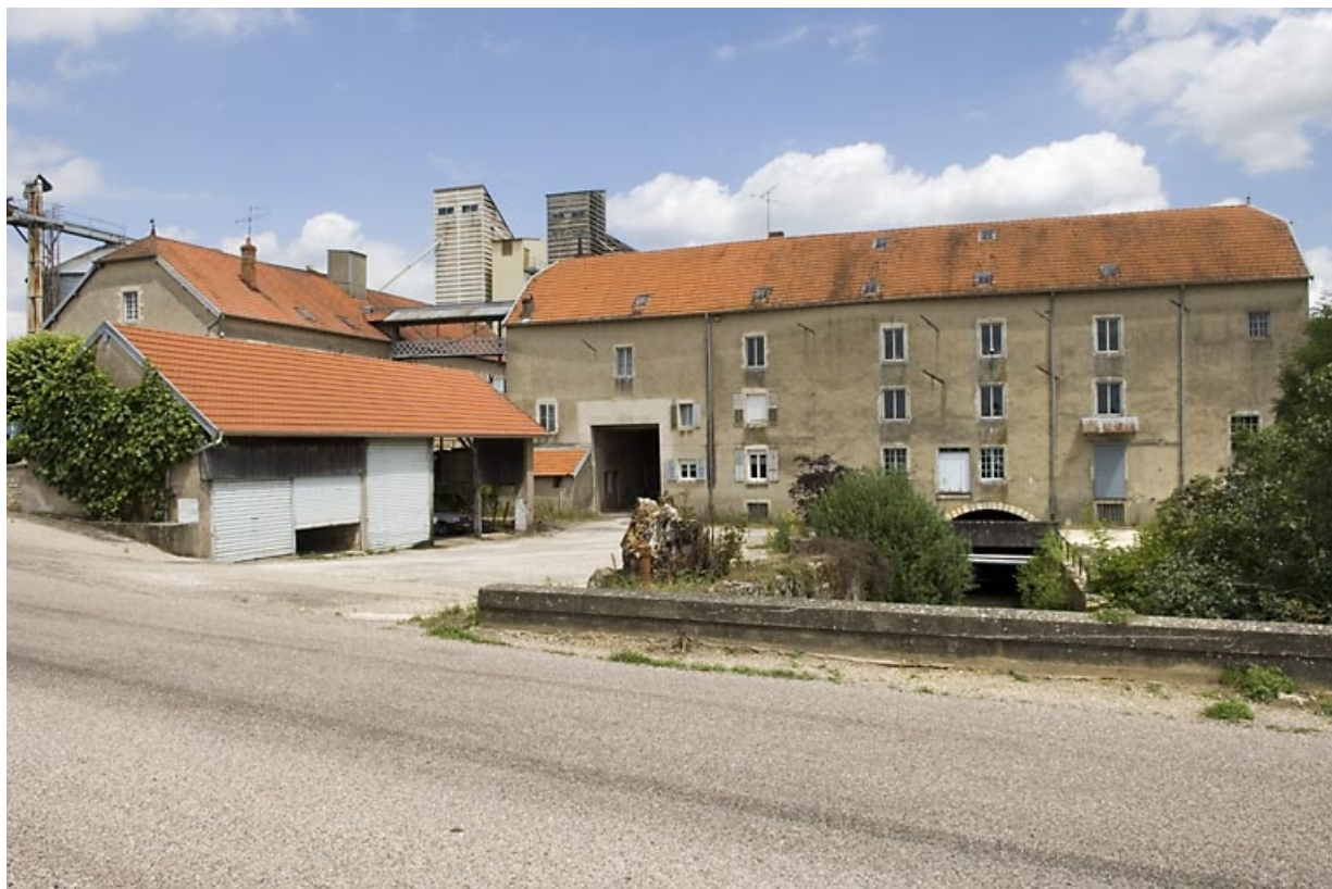
Vue d'ensemble depuis la route, à l'ouest.
