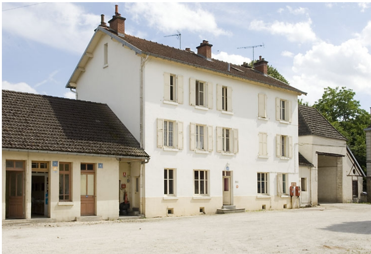
Bureau et logement. Vue de trois quarts gauche.
