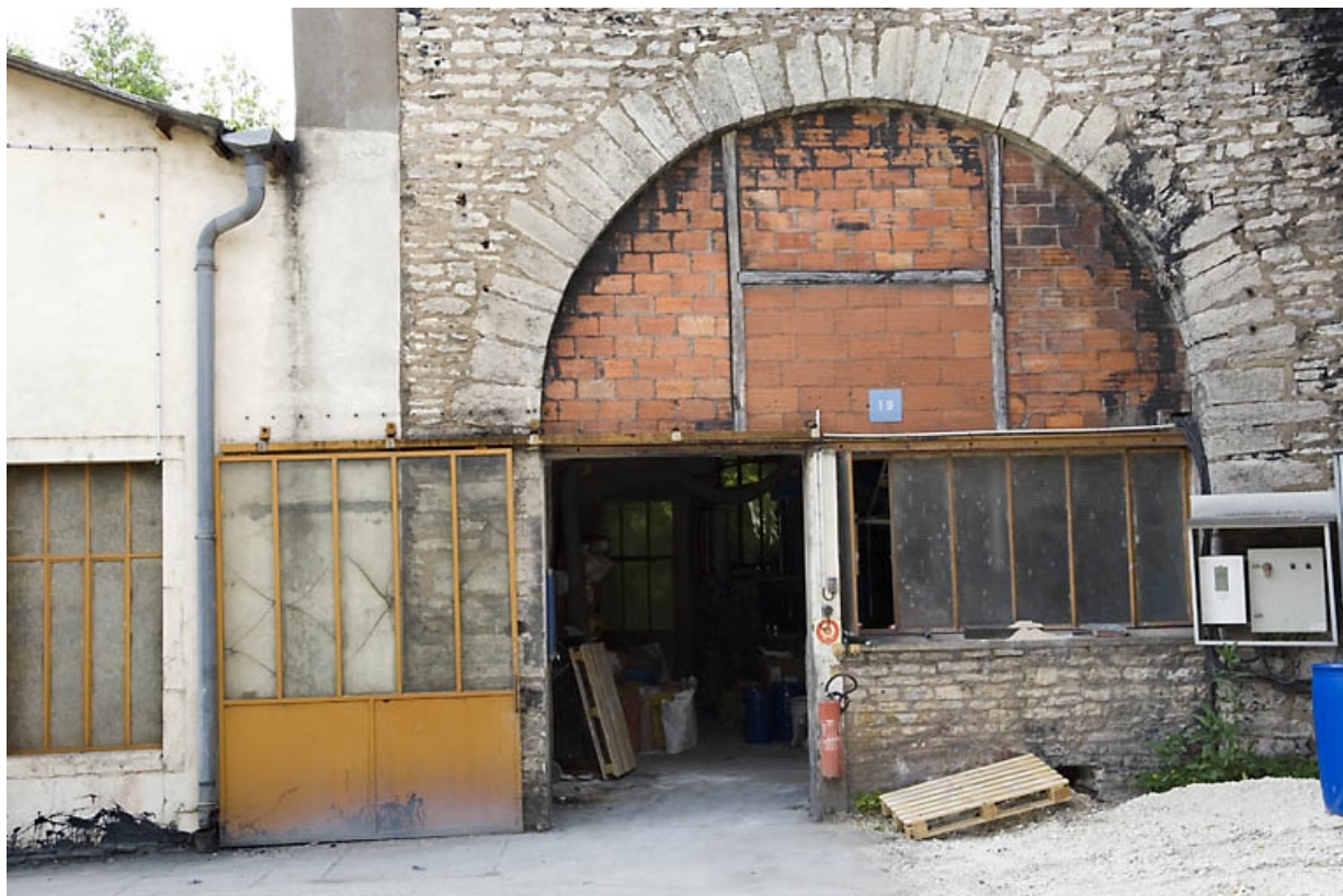
Vestiges du bâtiment du haut fourneau (?). 70, Lœuilley, lieudit : la Forge
