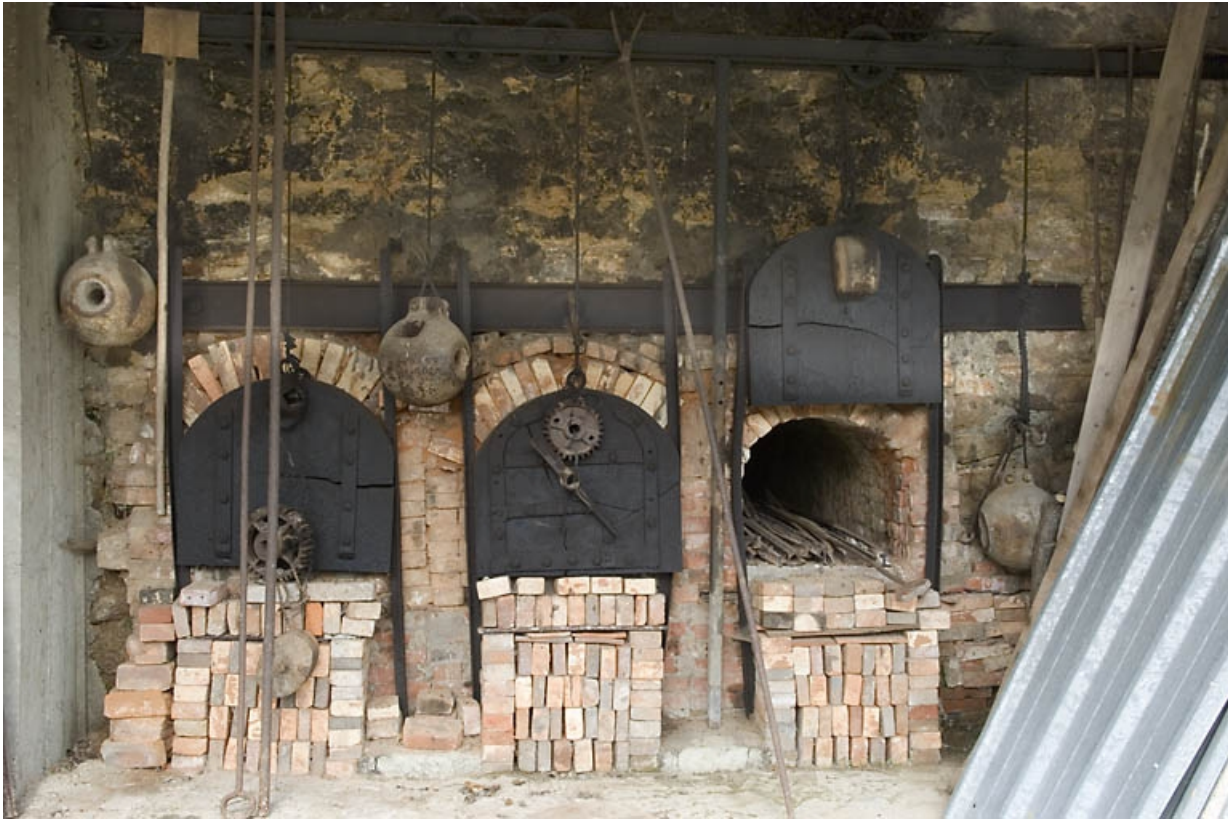
Façade est du four. Gueules de charge.
