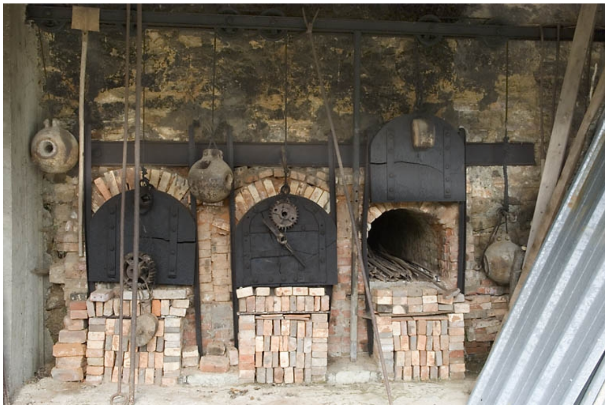
Façade est du four. Gueules de charge.
