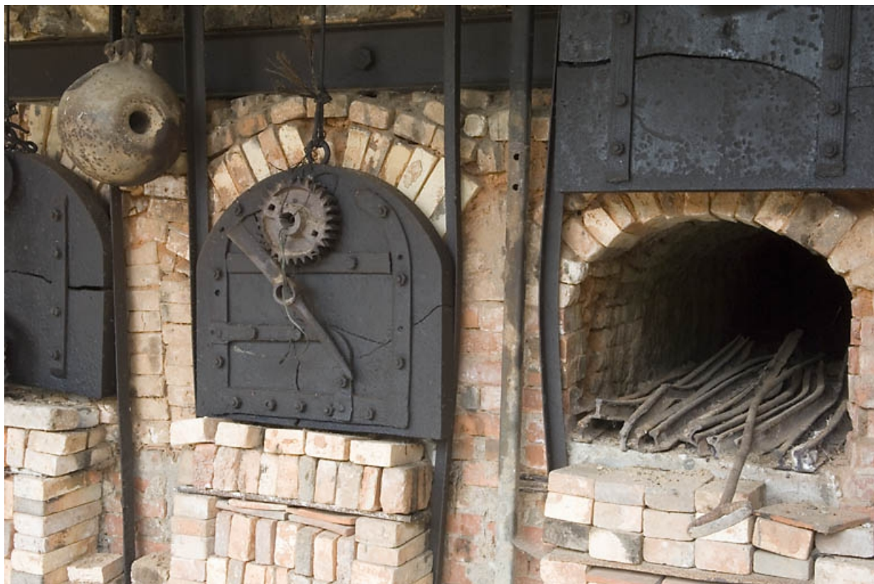
Gueules de charge du four, avec système d'ouverture à contrepoids.
