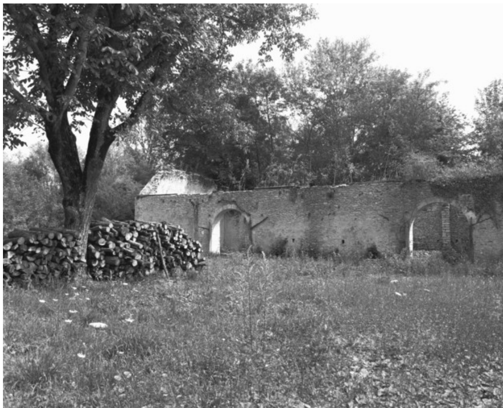
Ruines de la halle à charbon est en 1989.
