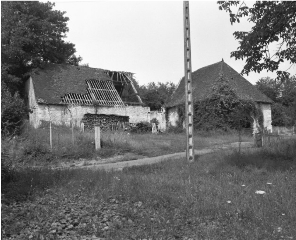
Halle à charbon en L en 1989.
