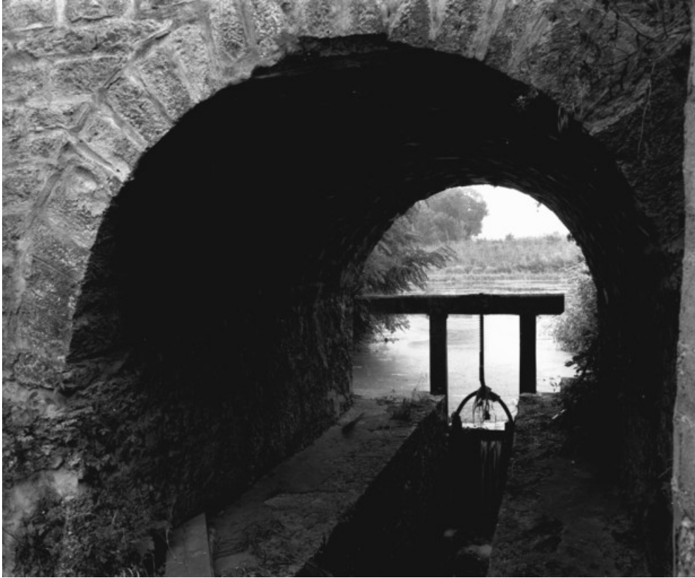
Vannage sur le canal de décharge en 1989.
