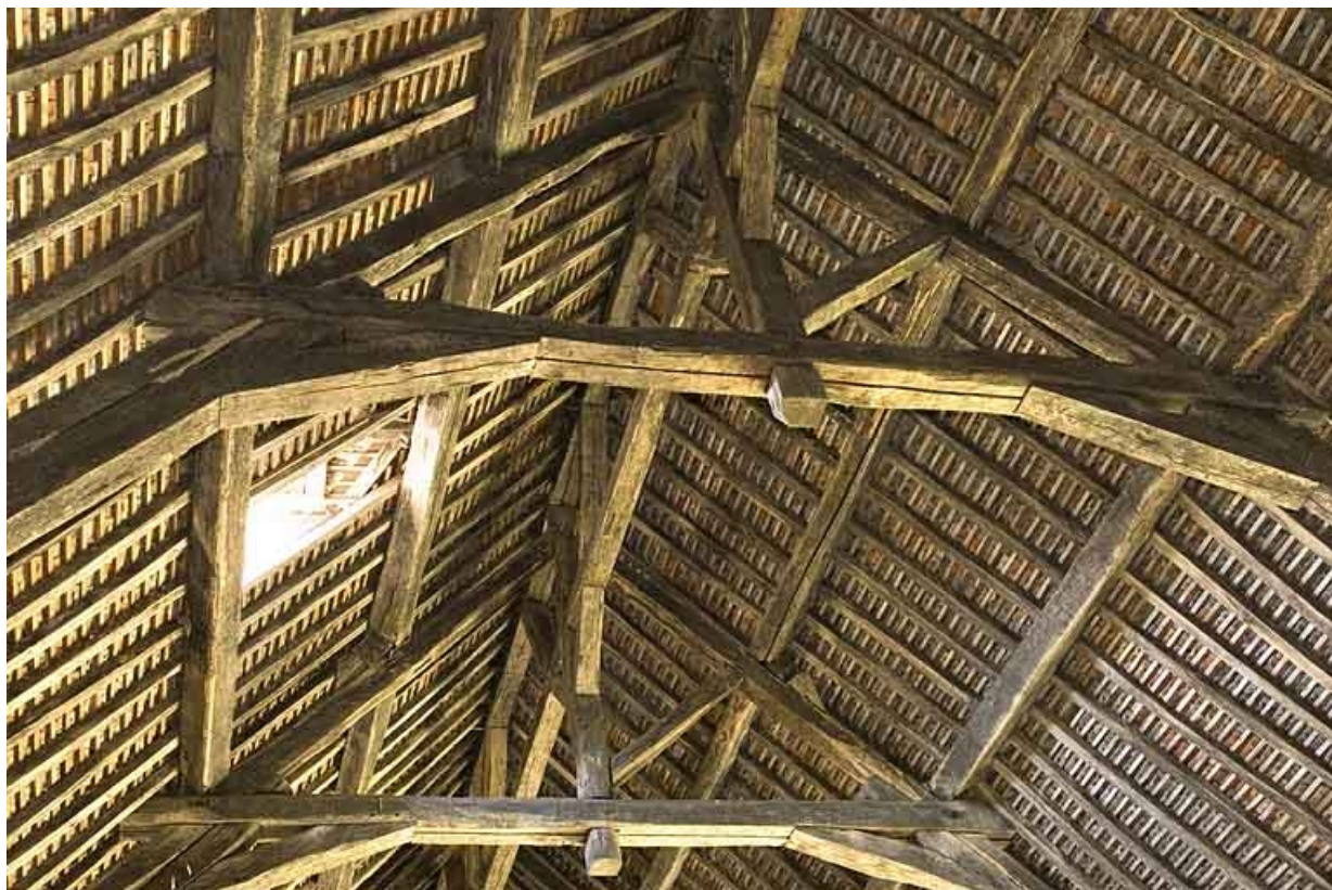
Charpente de la halle à charbon. Partie centrale.
