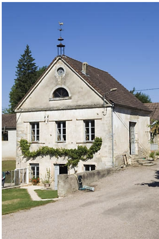
Bâtiment d'eau vu de trois quarts droite.
