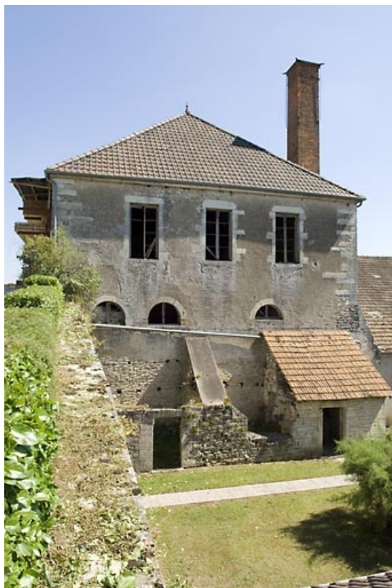
Façade nord-ouest du haut fourneau.
