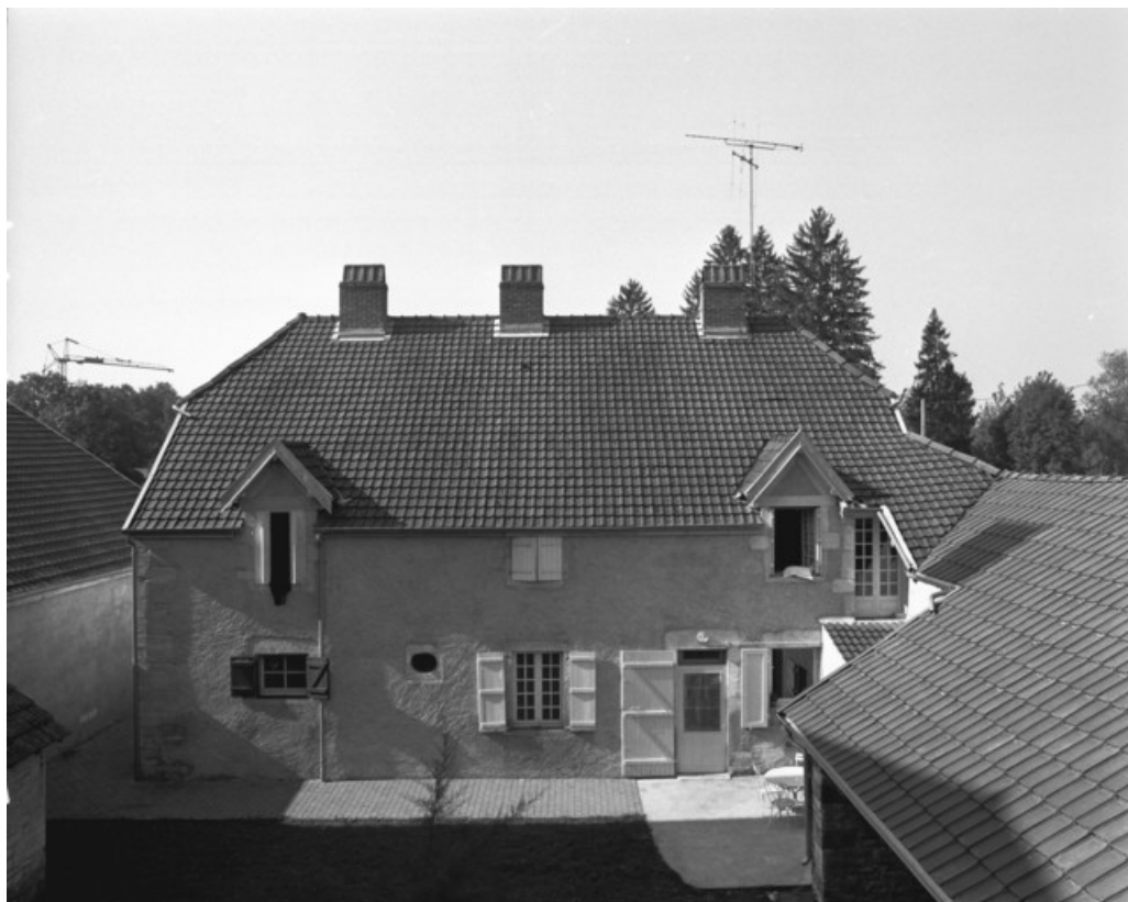
Logement patronal. Façade postérieure en 1989.
