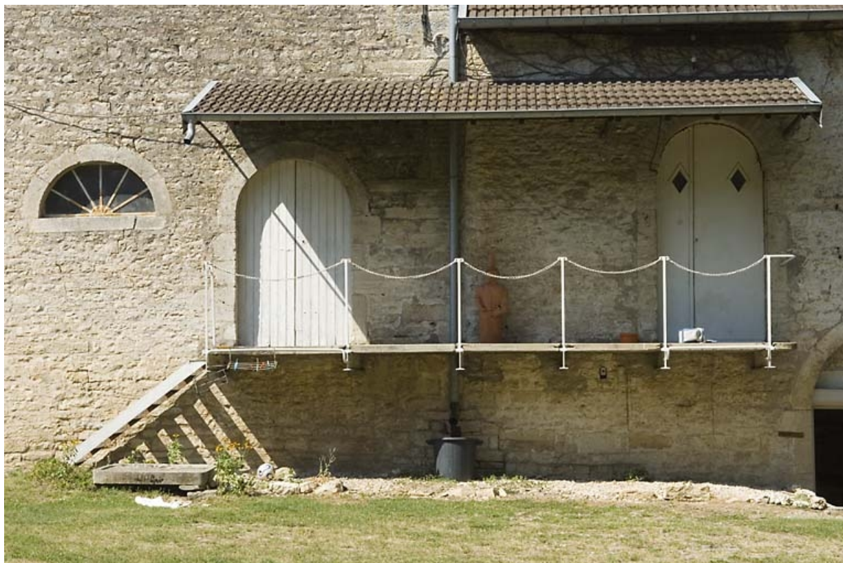
Détail de la façade sud du haut fourneau.
