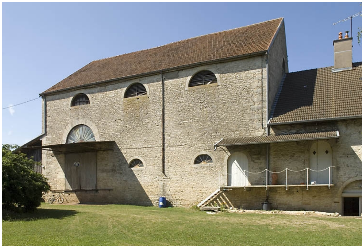
Façade sud du haut fourneau.
