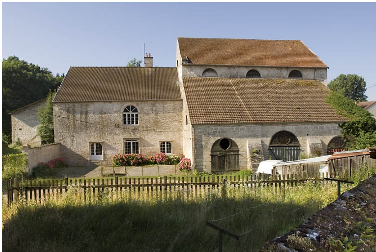
Façade nord du haut fourneau.
