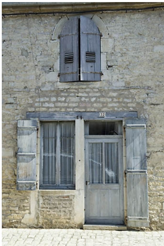
Travée de la façade du logement ouvrier.
