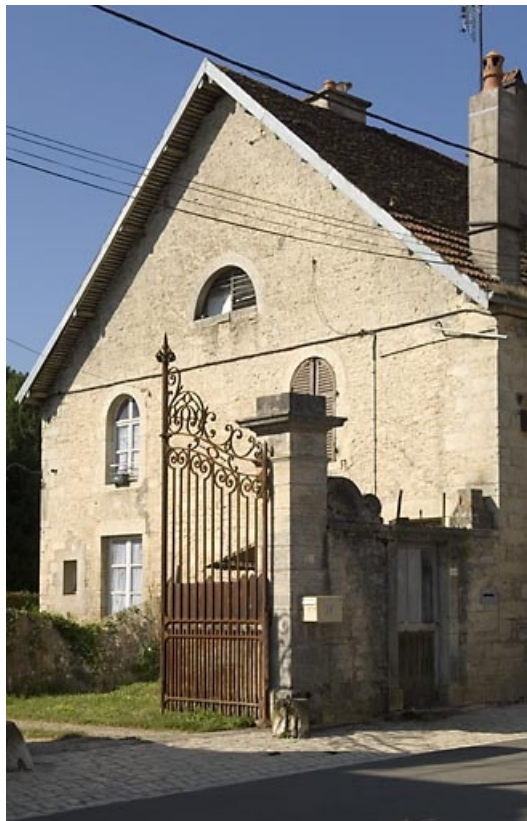
Grille du parc et pignon est du logement ouvrier. 70, Autrey-lès-Gray, 36 rue du Polon
