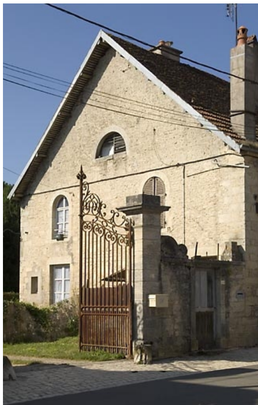
Grille du parc et pignon est du logement ouvrier. 70, Autrey-lès-Gray, 36 rue du Polon
