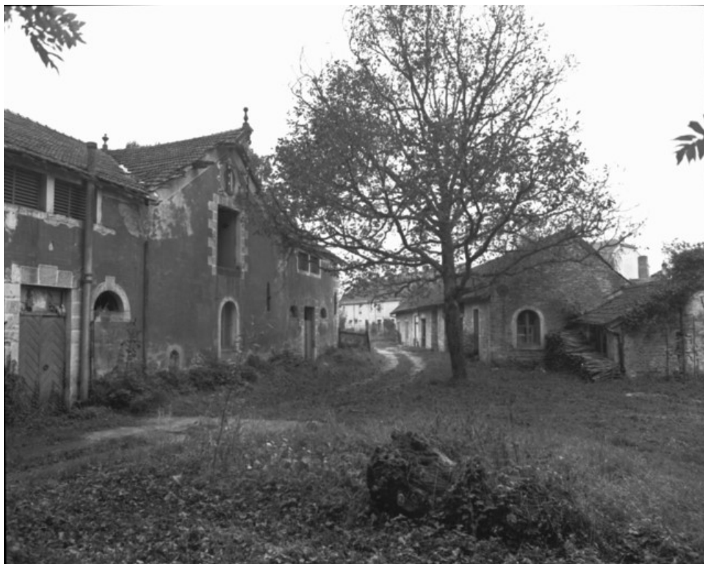
Ecurie et logement ouvrier depuis l'est en 1989.
