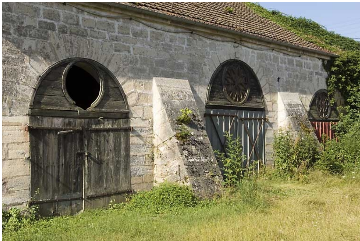
Mur nord du haut fourneau (halle de coulée ?).
