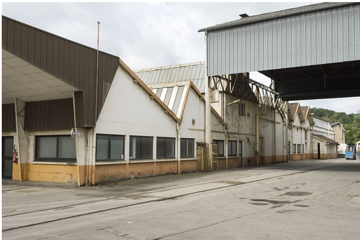
Façades nord des ateliers de fabrication.
