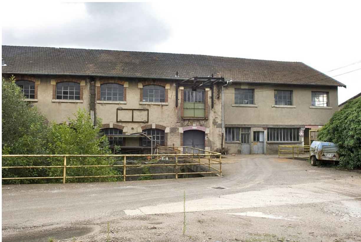
Façade ouest d'un atelier de fabrication (papeterie).
