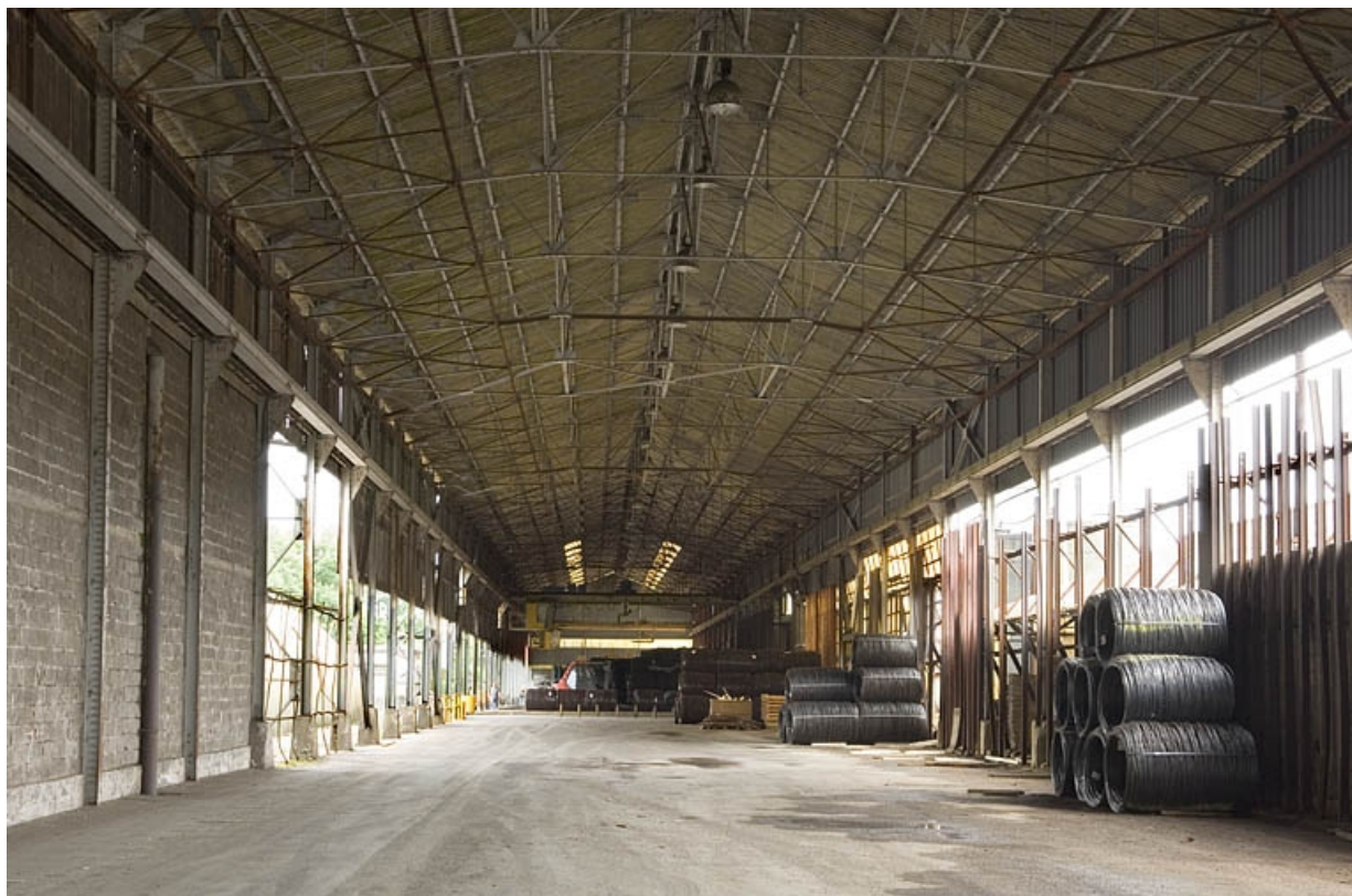
Vue intérieure d'un entrepôt industriel.
