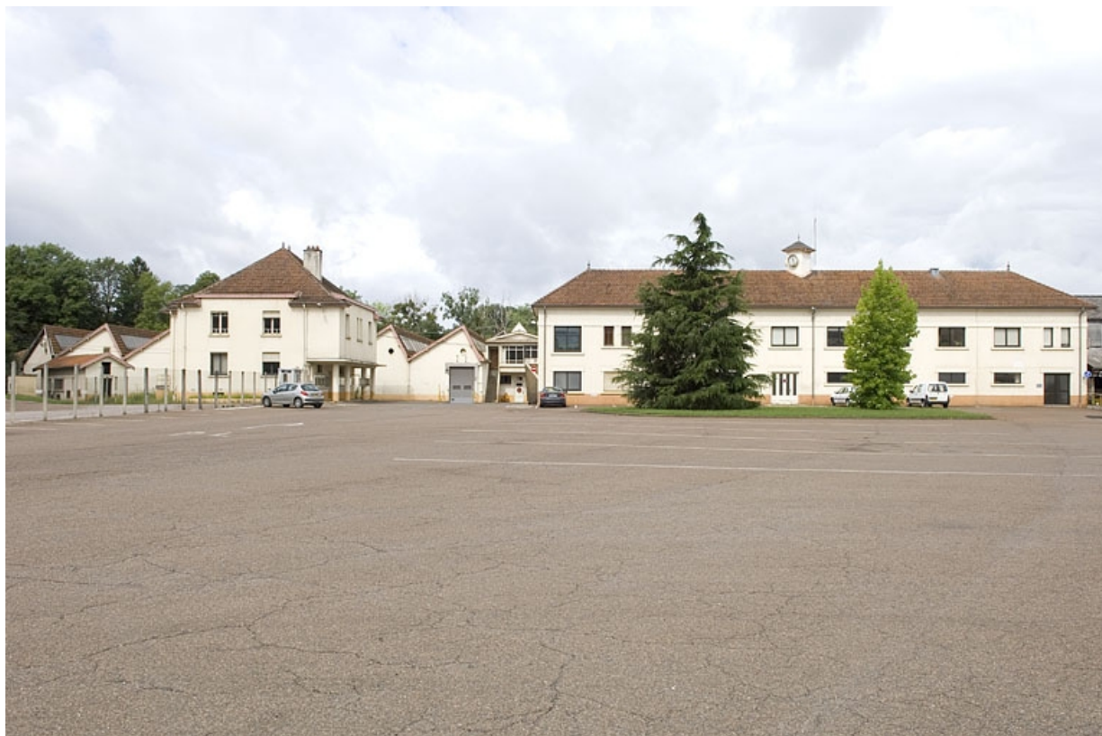
Vue d'ensemble depuis l'entrée.
