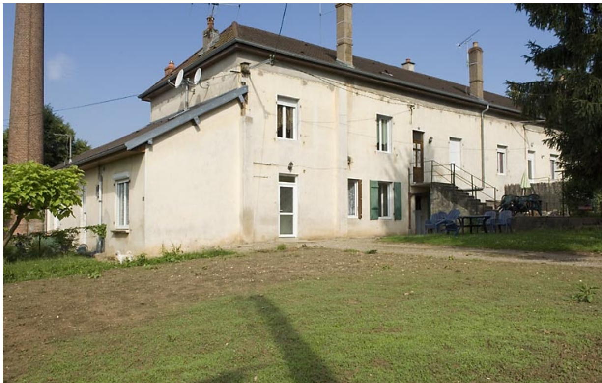
Cheminée, salle des machines et ancien atelier.
