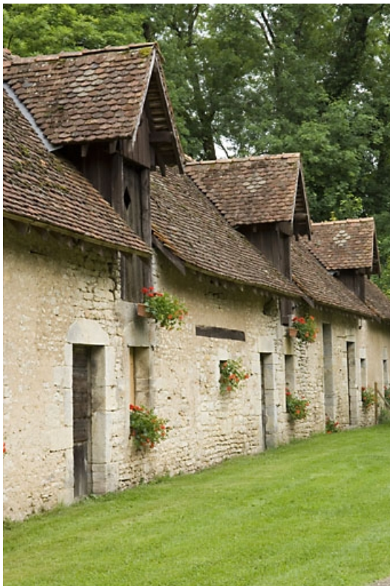
Détail de la façade antérieure du logement ouvrier.
