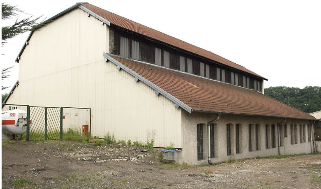
Atelier de fonderie depuis le nord-est.
