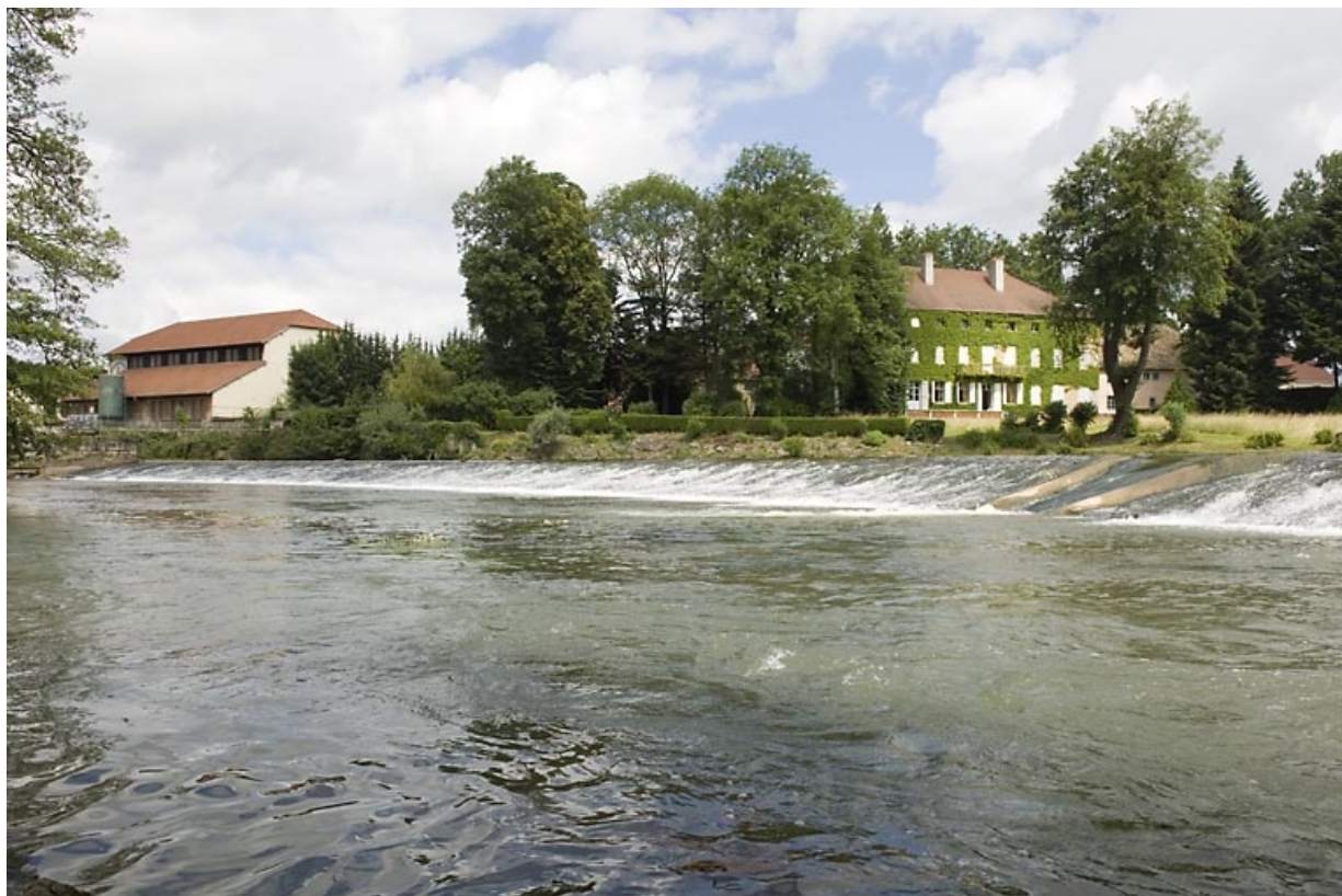
Vue d'ensemble depuis la rive gauche de l'Ognon.
